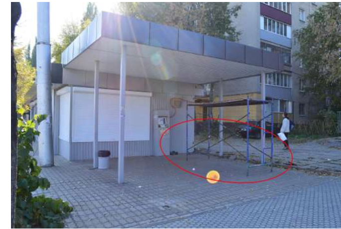
отсутствие сидений на остановочном павильоне
