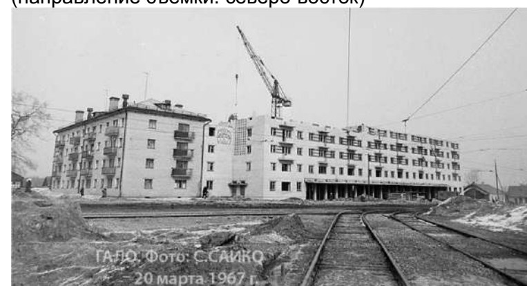
1967 г. Строительство магазина «Старт» (направление съёмки: северо-восток)
