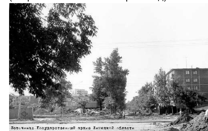
1971 г. Начало строительства «Трансагенства» (направление съёмки: северо-запад)
