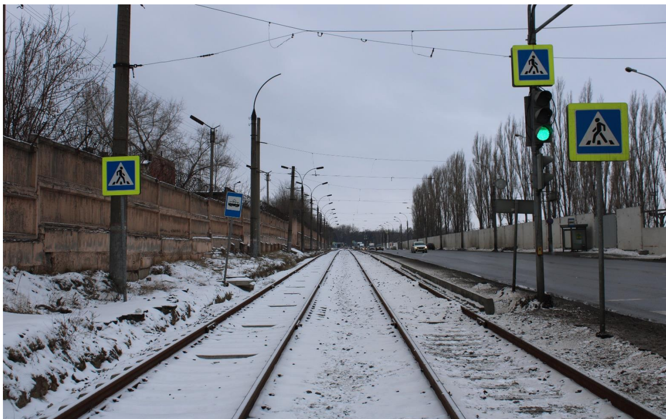
Рис. 67. Общий вид новой уложенной РШР по ул. Metallургов
