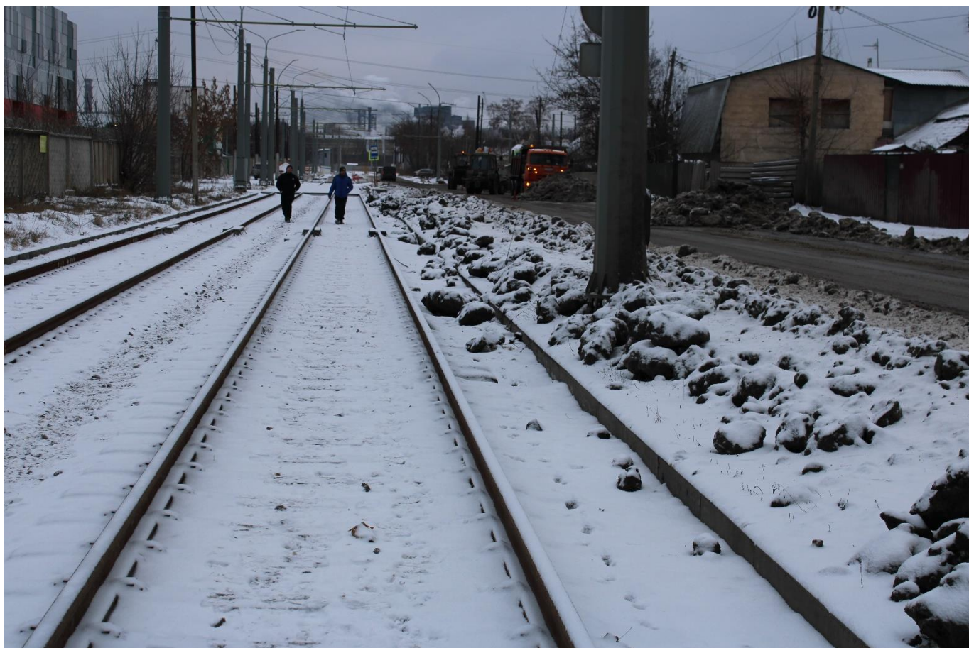
Рис. 28. Предпосылки к загрязнению балластного слоя по ул. 3-е Сентября.
