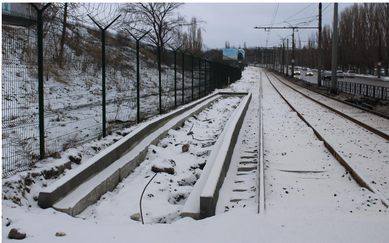
Рис. 80. Обустройство посадочной площадки на остановке «ул. Речная».
