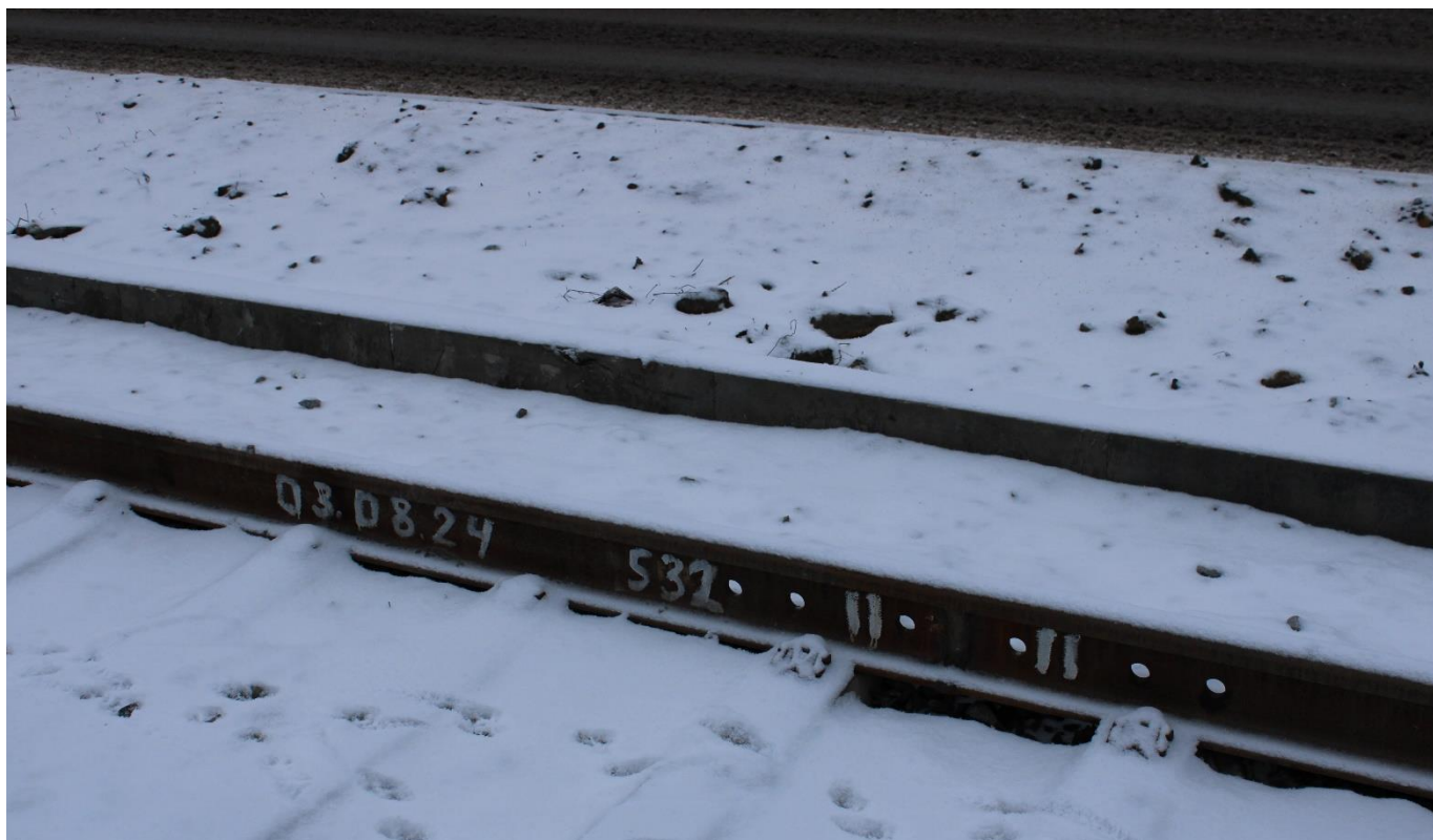
Рис. 18. Зафиксировано проведение работ по маркировке и нумерации стыков масляной краской по ГОСТ 10503 светлого тона для последующей Приёмки работ
