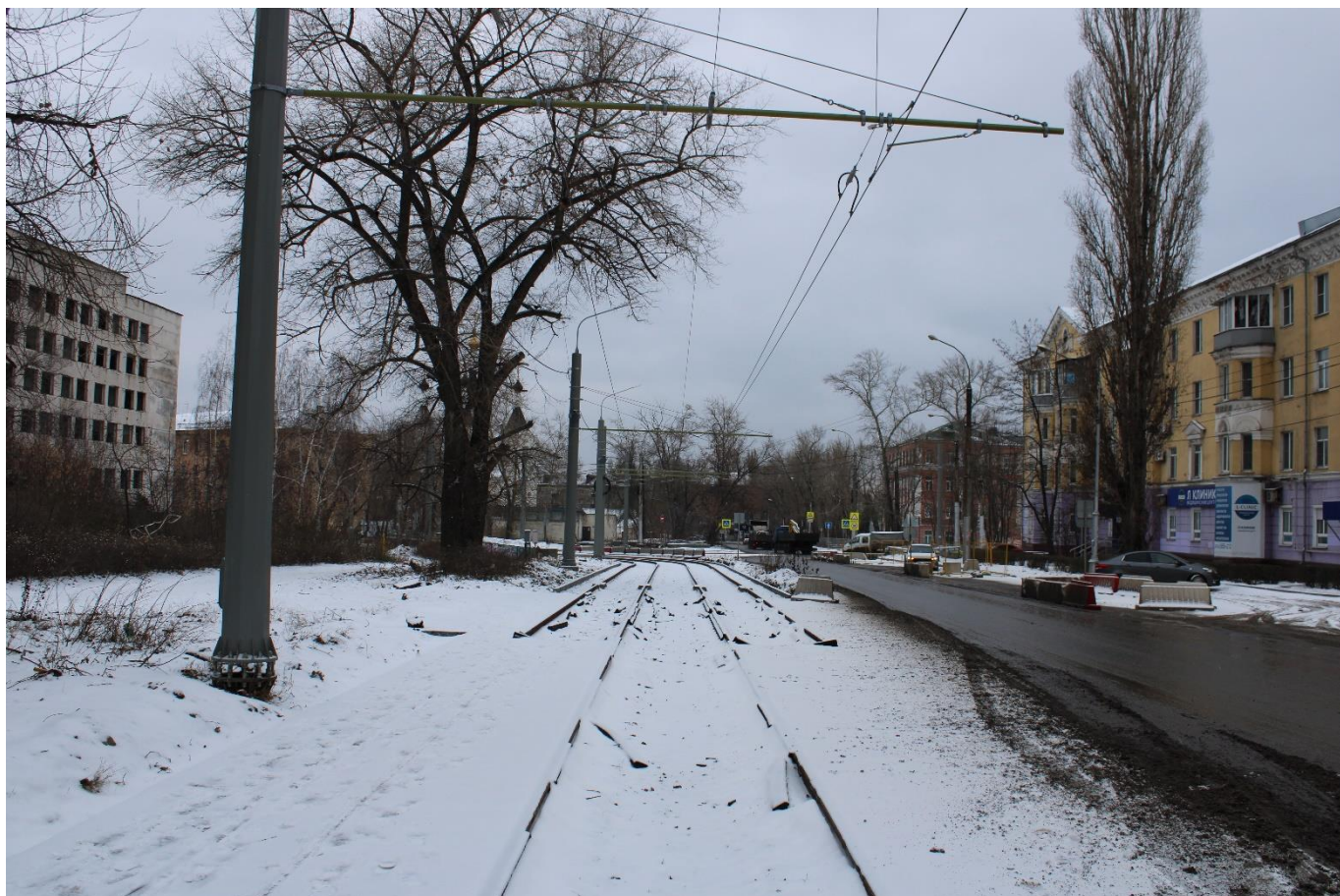
Рис. 22. Общий вид трамвайной инфраструктуры по ул. Краснозаводская
