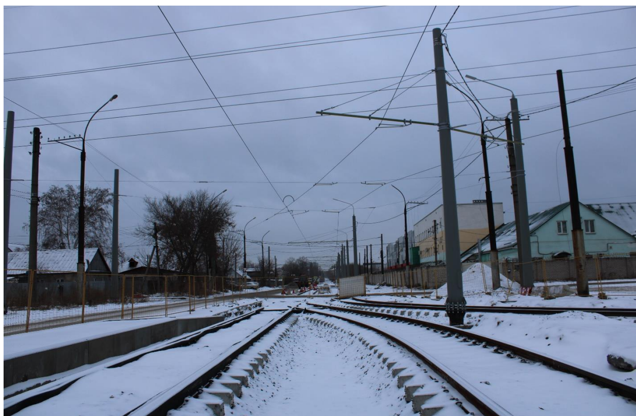
Рис. 11. Реконструкция трамвайных путей в районе ул. Чехова
