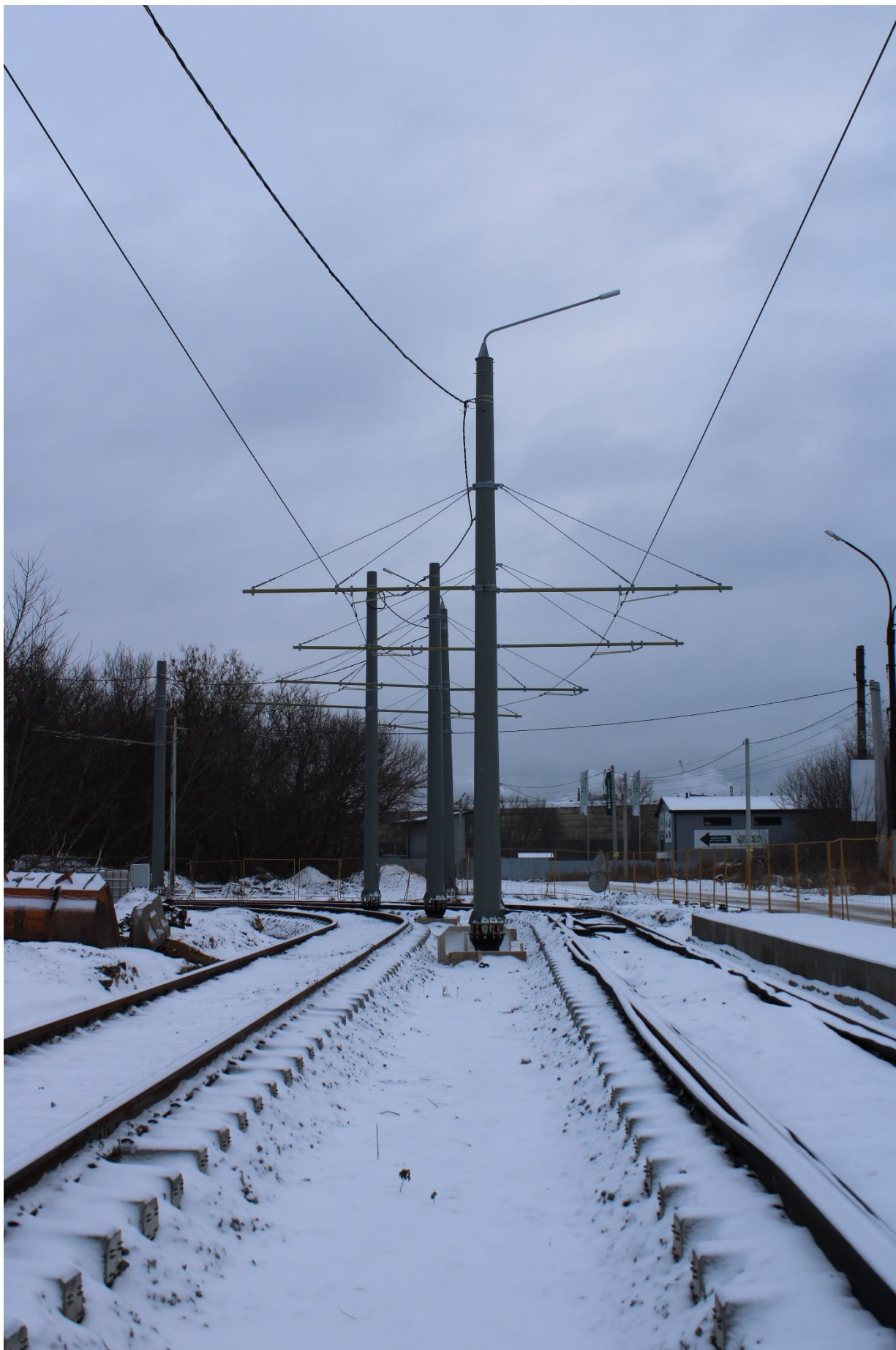
Рис. 12. Реконструкция трамвайных путей в районе ул. Чехова
