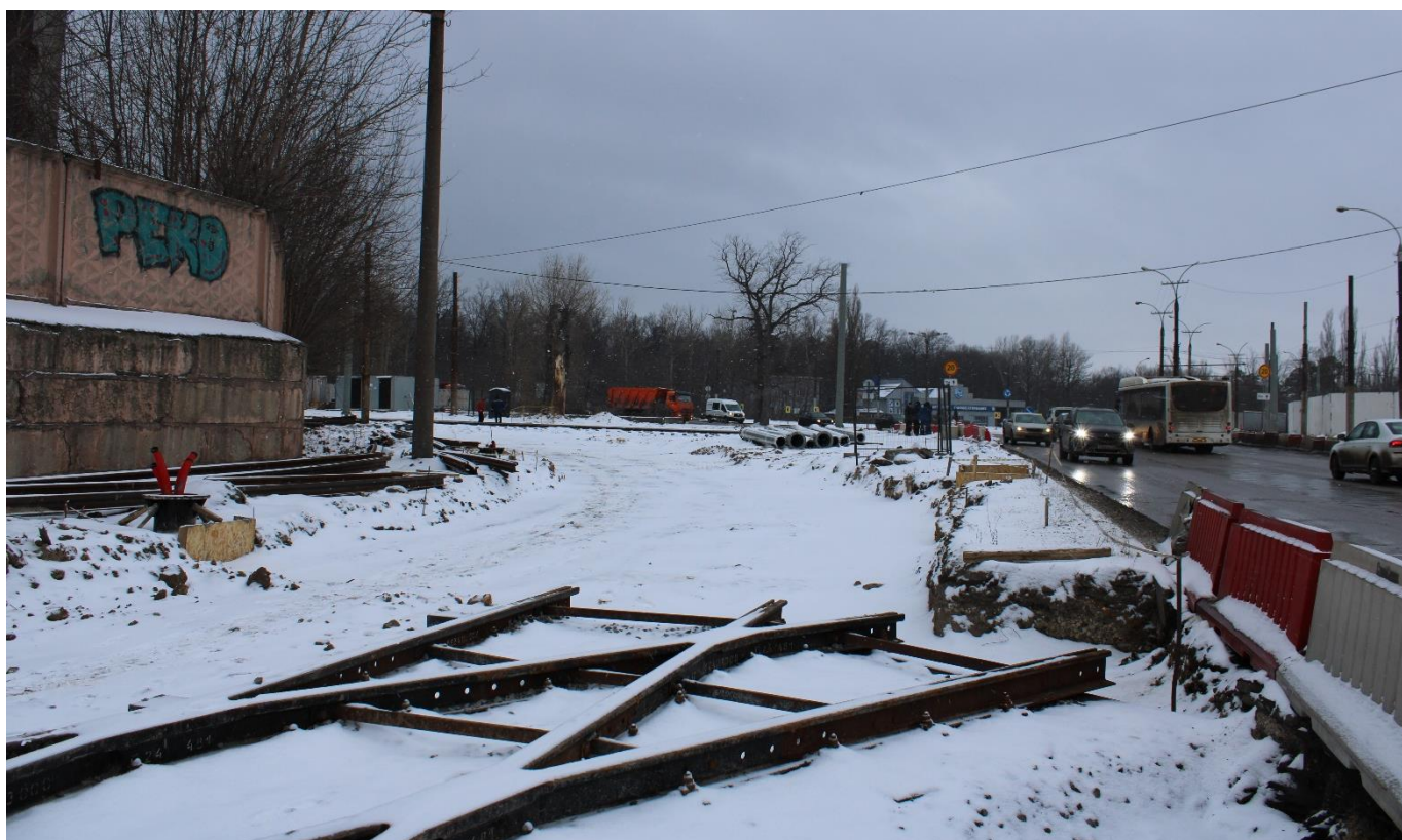
Рис. 27. Участок работ в районе пересечения ул. Краснозаводская с ул. Metallургов
