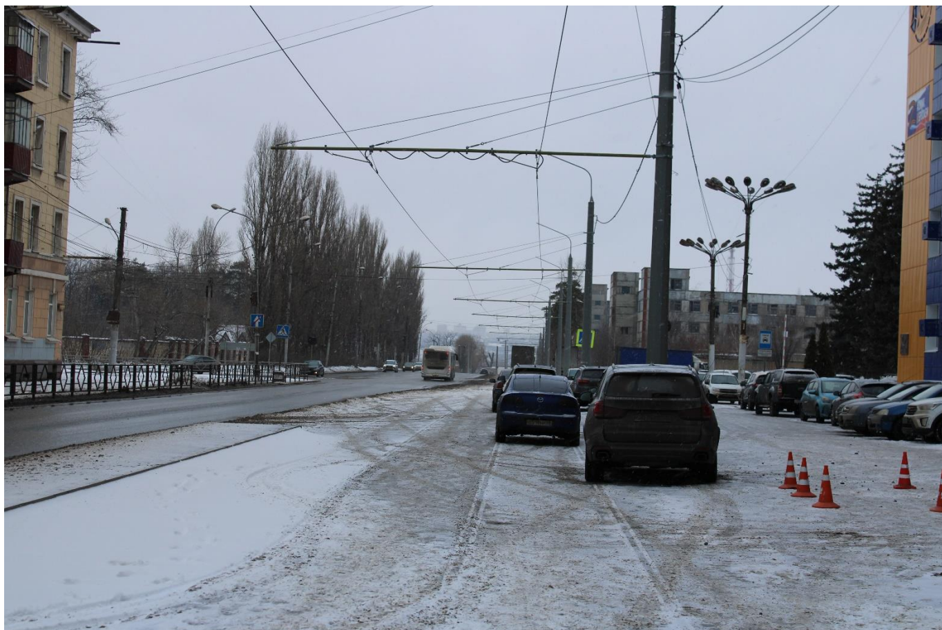
Рис. 29. Общий вид трамвайной инфраструктуры по ул. Краснозаводская.
