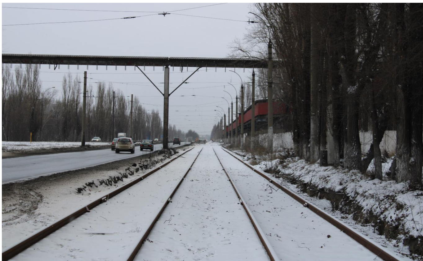
Рис. 69. Общий вид новой уложенной РШР по ул. Metallургов
