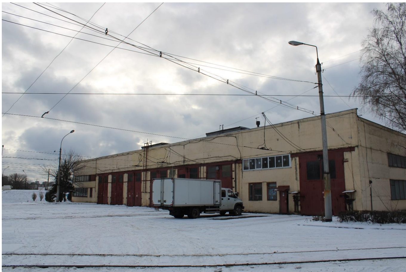
Рис. 87. Общий вид трамвайного депо на момент проведения Проверки.
