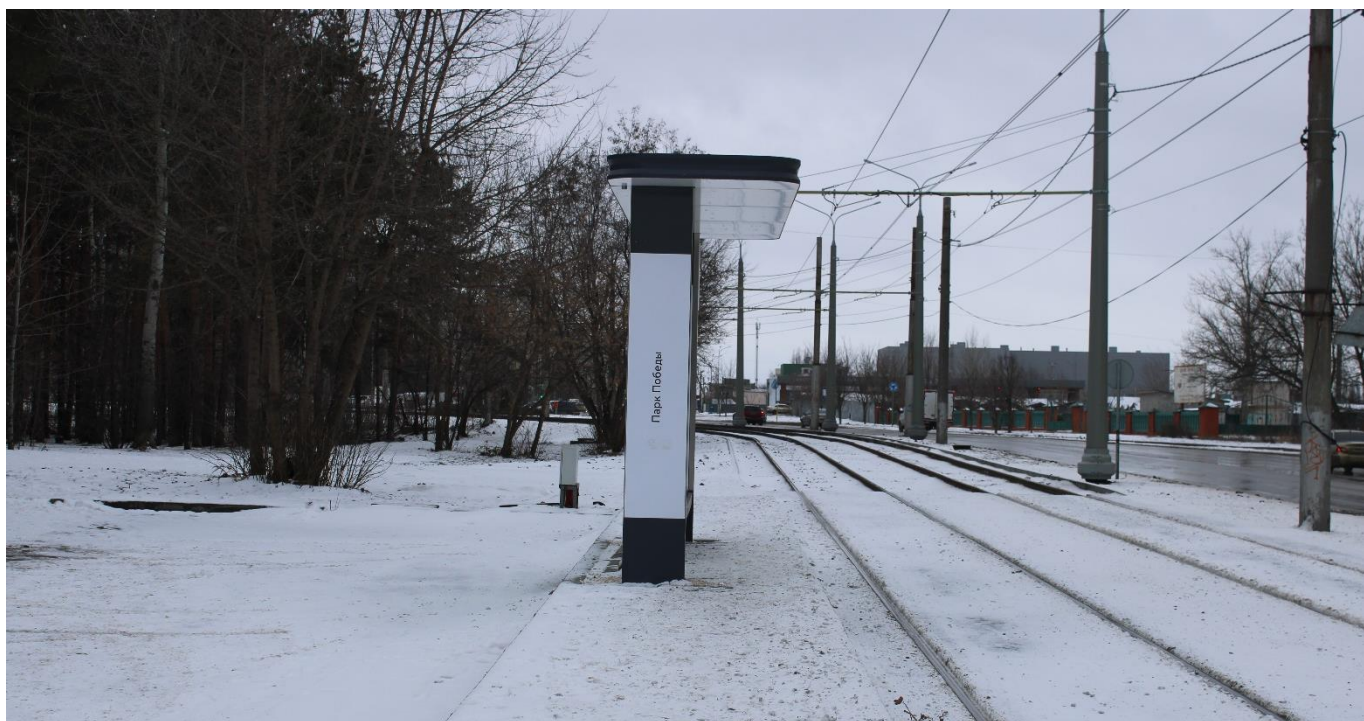
Рис. 42. Остановочный пункт «Парк Победы» в сторону ул. Полиграфическая. Павильон размещён на ненормативном расстоянии от края посадочной площадки. Требуется переустройство со смещением на территорию парковки.
