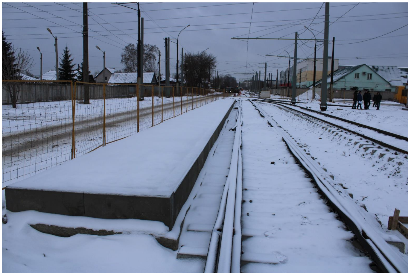
Рис. 13. Обустройство посадочной площадки в районе ул. Чехова
