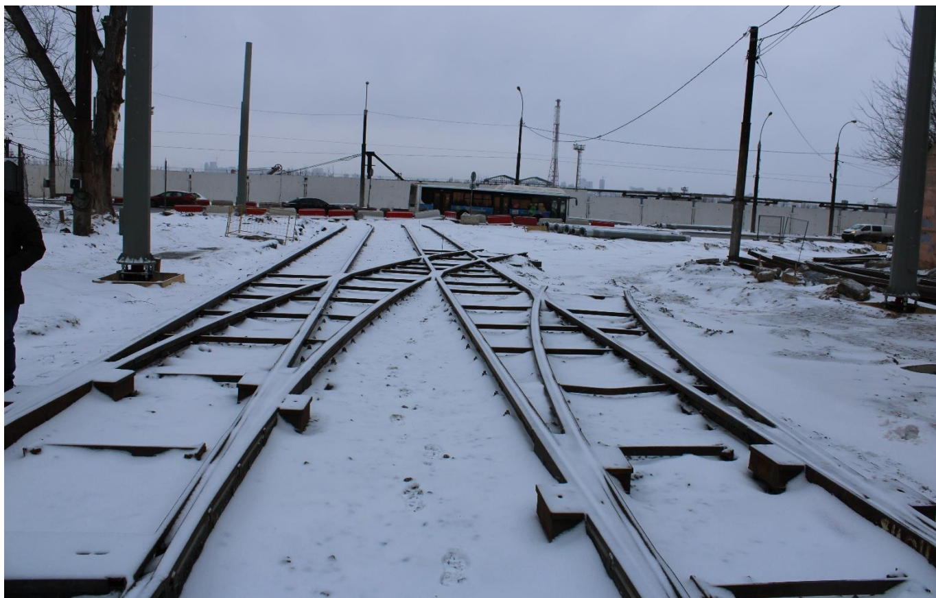
Рис. 24. Общий вид трамвайной инфраструктуры по ул. Краснозаводская в районе пересечения с ул. Metallургов
