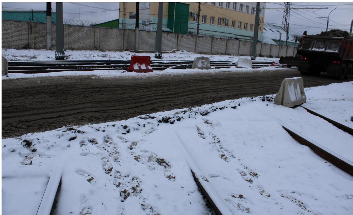
Рис. 16. Текущее состояние временного переезда по ул. 3 Сентября
