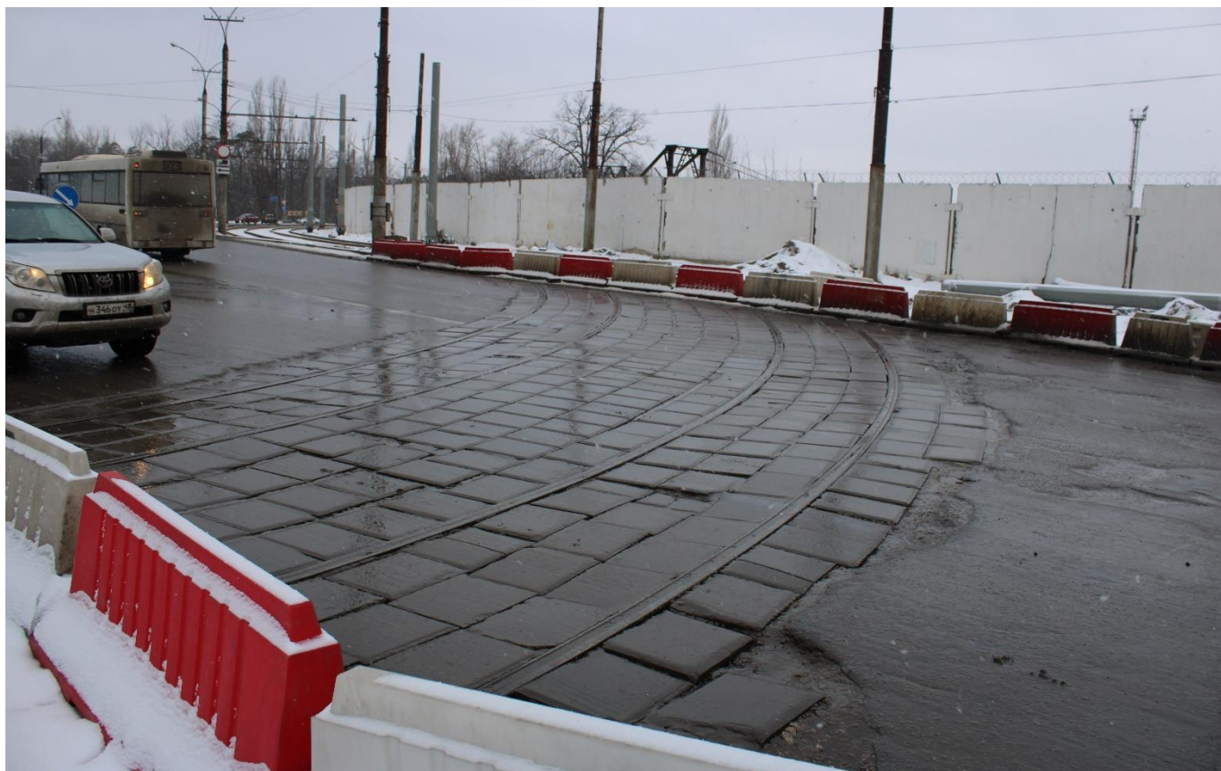
Рис. 26. Временный переезд в районе пересечения ул. Краснозаводская с ул. Metallургов
