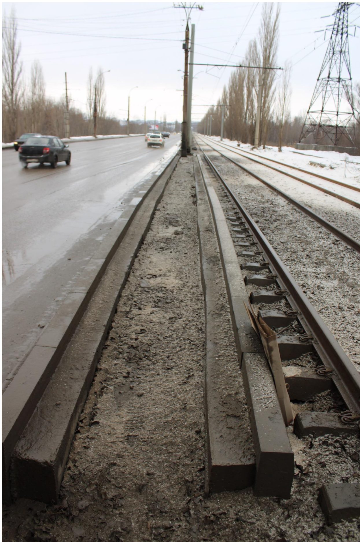
Рис. 81. Обустройство посадочной площадки на остановке «ул. Речная».
