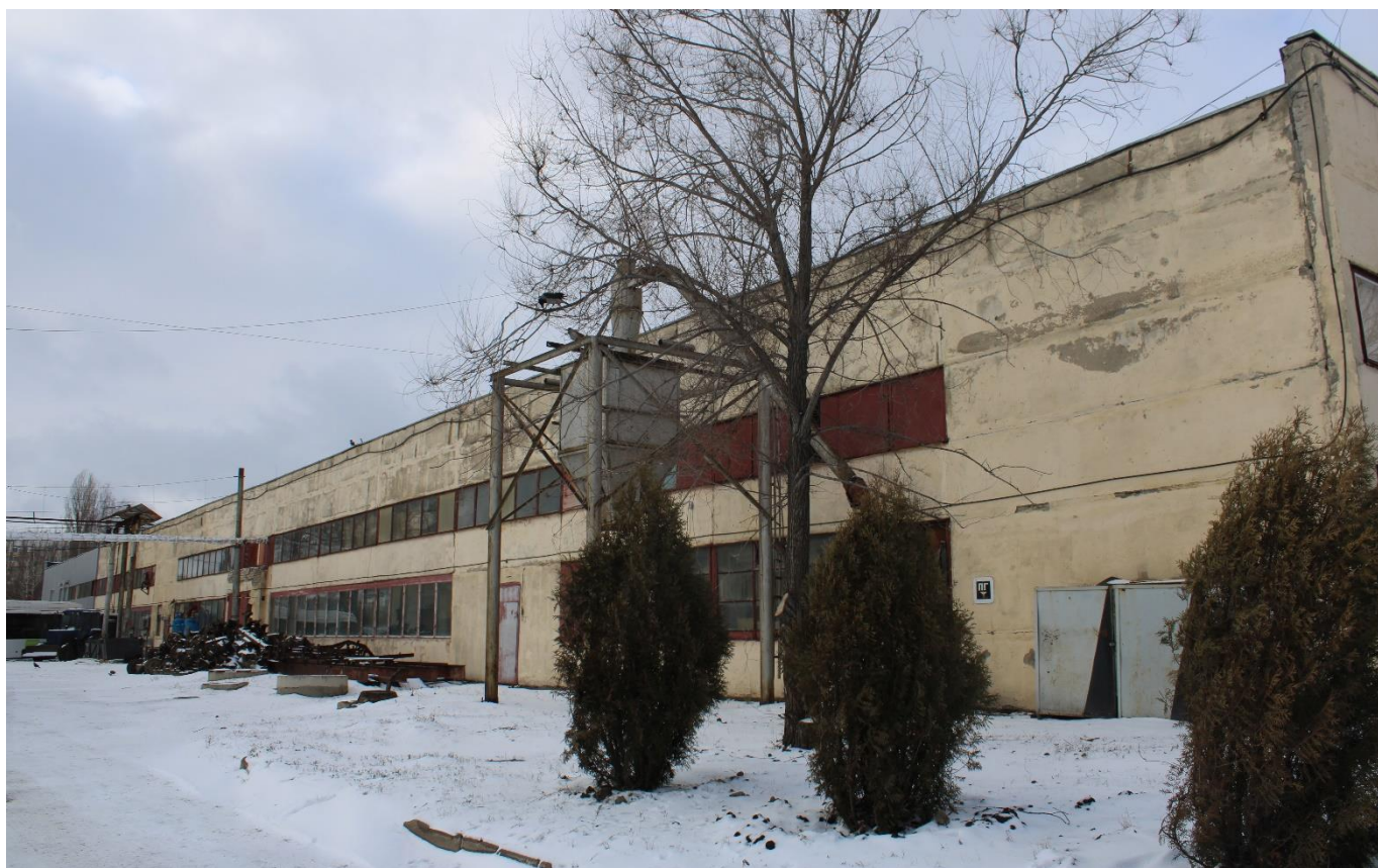
Рис. 89. Общий вид трамвайного депо на момент проведения Проверки.
