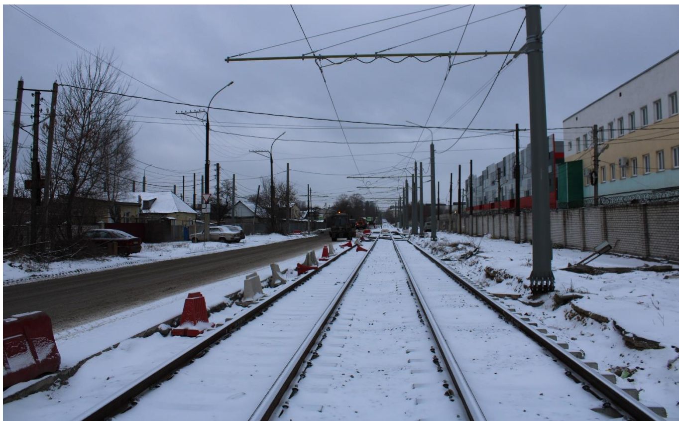
Рис. 14. Реконструкция трамвайных путей по ул. 3 Сентября
