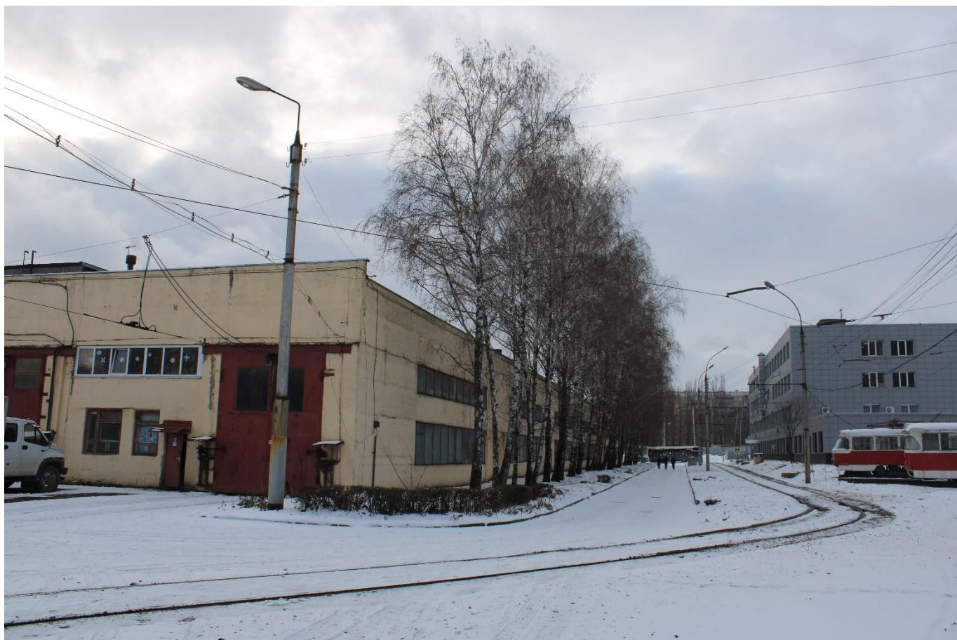
Рис. 88. Общий вид трамвайного депо на момент проведения Проверки.
