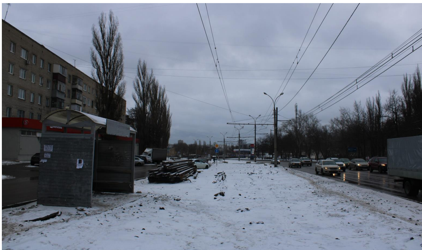
Рис. 58. Ул. Циолковского. Осуществлён демонтаж существующих путей за исключением переездов
