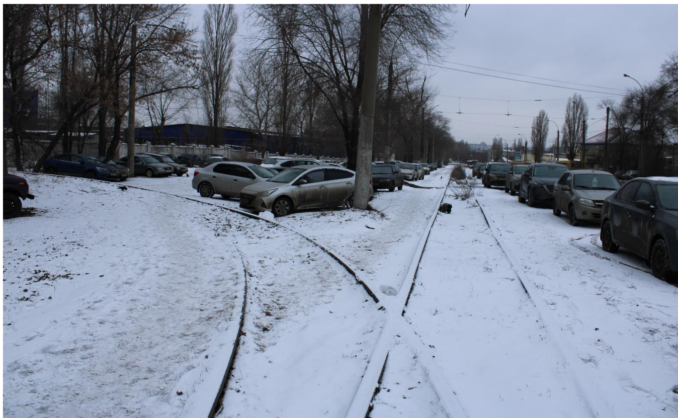
Рис. 74. Разворотный круг по ул. 9 Мая. Демонтажные работы на момент проведения Проверки не начаты.
