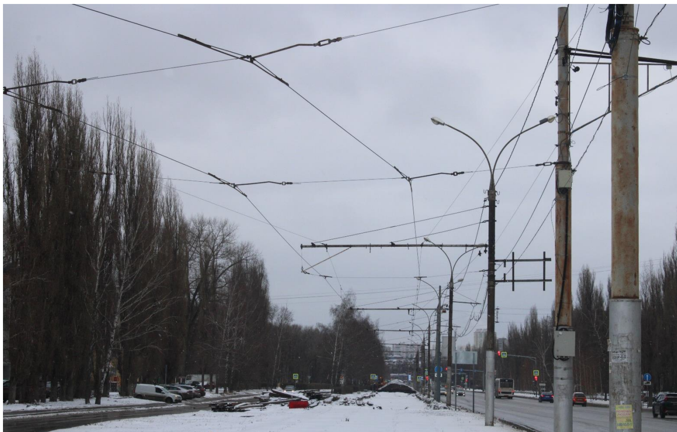
Рис. 57. Ул. Циолковского. Осуществлён демонтаж существующих путей за исключением переездов
