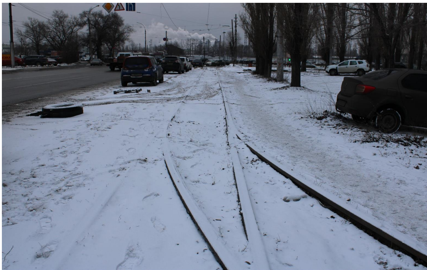
Рис. 73. Ул. 9 Мая. Демонтажные работы на момент проведения Проверки не начаты.
