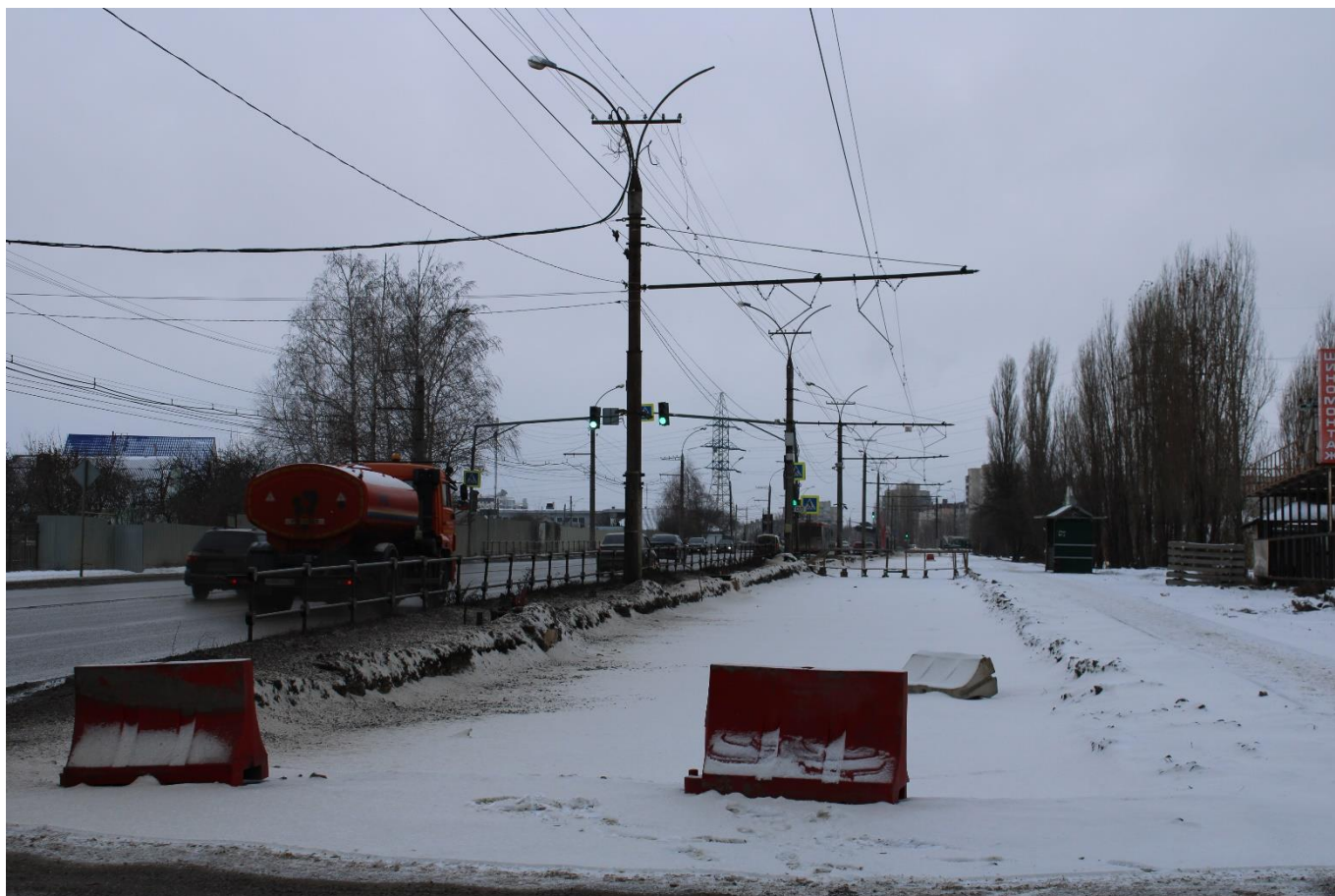
Рис. 84. Подходы к Октябрьскому мосту со стороны пр. Победы
