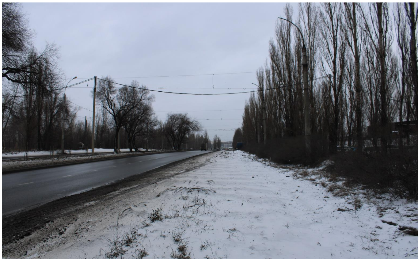
Рис. 72. Вид на ул. Metallургов в сторону кольцевого пересечения с ул. 9 Мая. Демонтаж путей выполнен, укладка новой РШР не начата.
