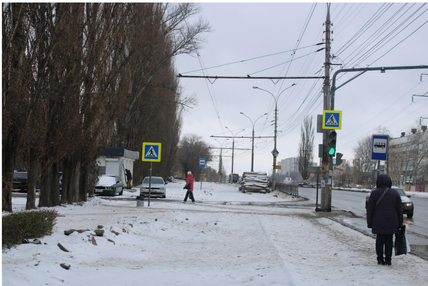
Рис. 55. Ул. Московская. Осуществлѐн демонтаж существующих путей за исключением переездов
