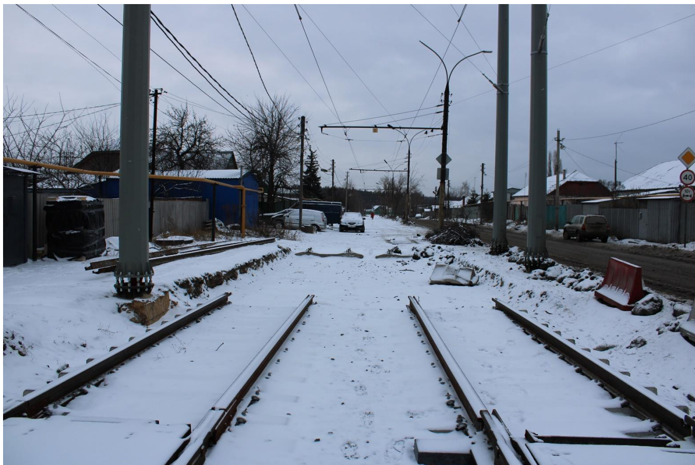
Рис. 15. Реконструкция трамвайных путей по ул. 1-я Воронежская
