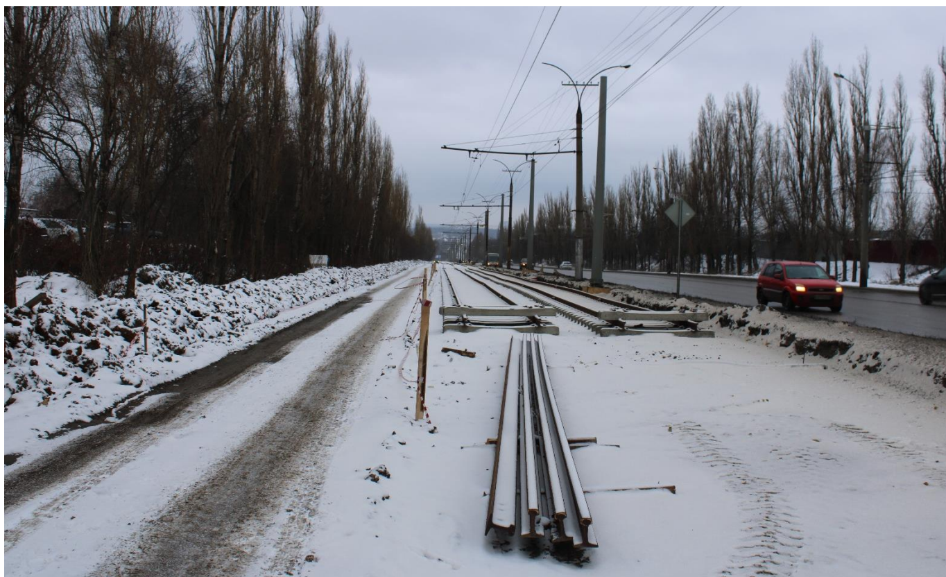
Рис. 83. Подходы к Октябрьскому мосту со стороны пр. Победы
