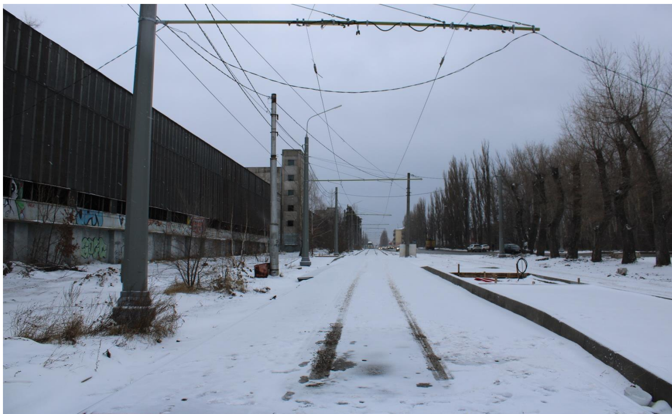
Рис. 25. Общий вид трамвайной инфраструктуры по ул. Краснозаводская
