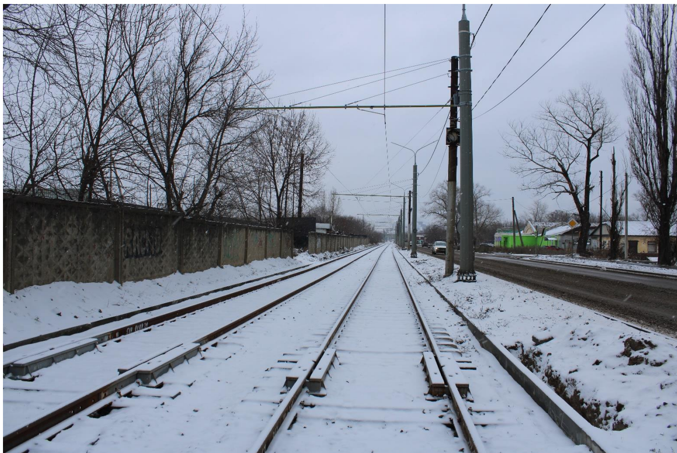
Рис. 19. Общий вид трамвайной инфраструктуры по ул. 3-е Сентября
