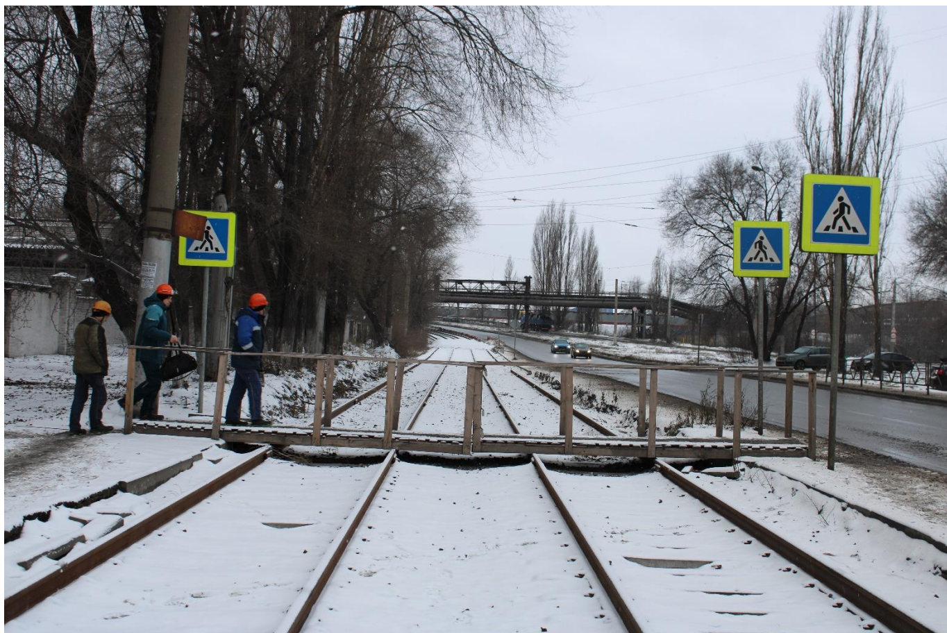
Рис. 68. Общий вид новой уложенной РШР по ул. Metallургов
