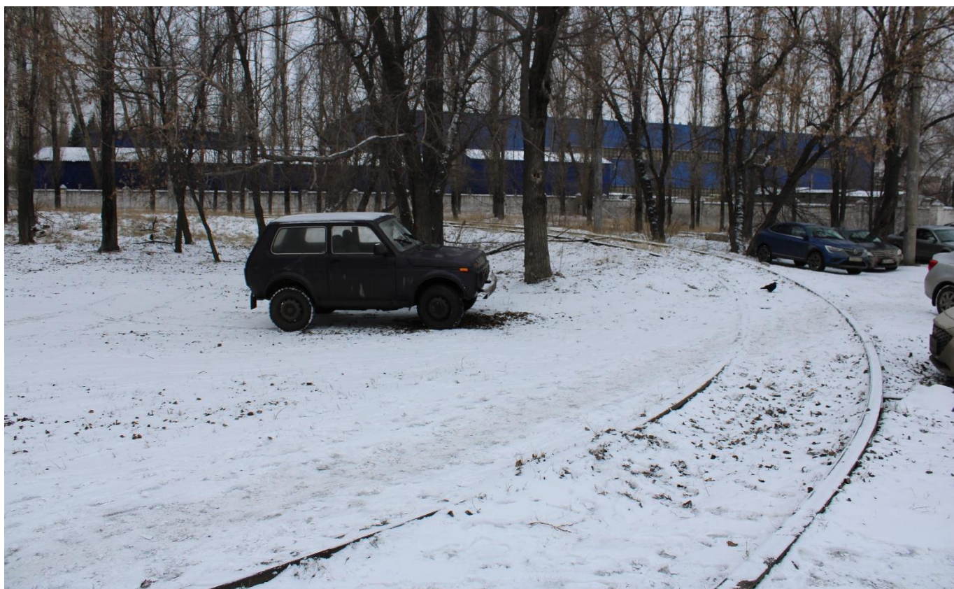
Рис. 75. Разворотный круг по ул. 9 Мая. Демонтажные работы на момент проведения Проверки не начаты.
