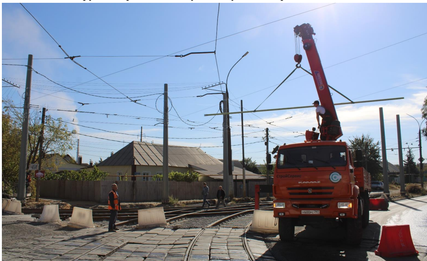
Рис. 15. Установка кронштейна на опору контактной сети в районе пересечения ул. 3-е Сентября и ул. 1-я Воронежская
