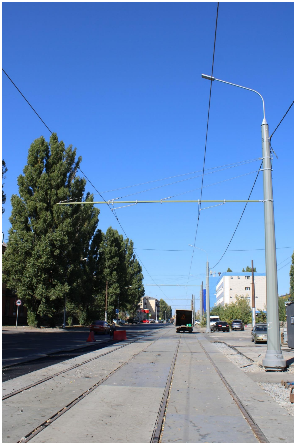
Рис. 24. Общий вид трамвайной инфраструктуры по ул. Краснозаводская
