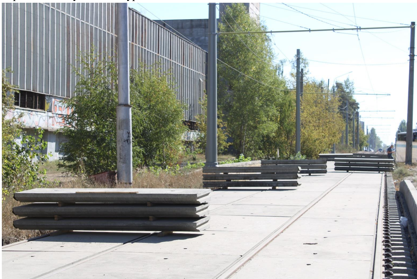
Рис. 26. Общий вид трамвайной инфраструктуры по ул. Краснозаводская
