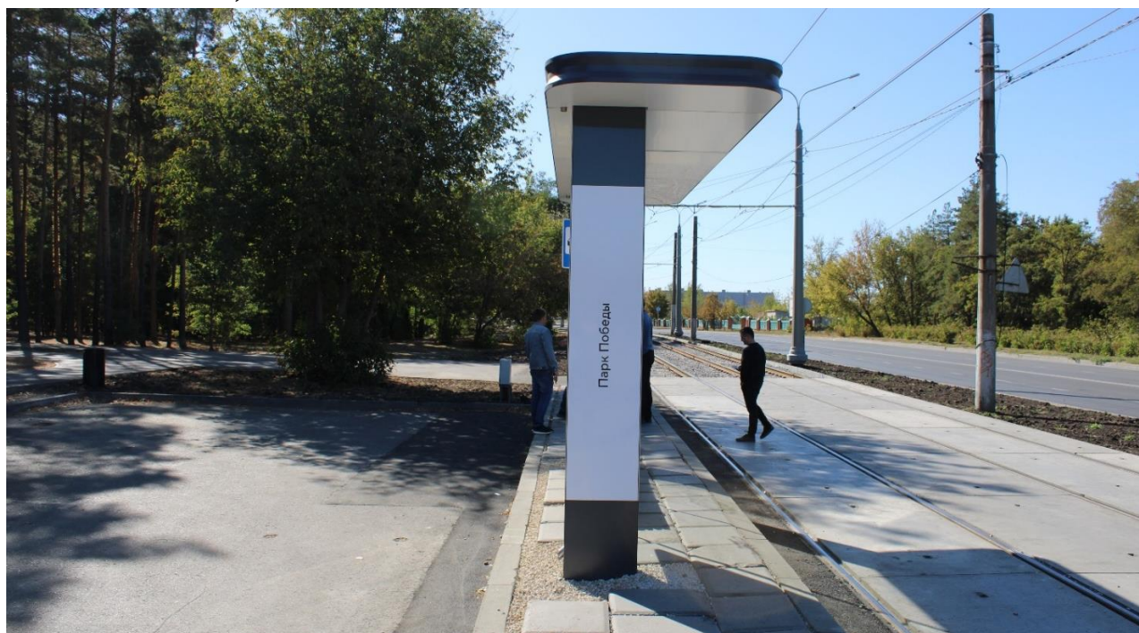
Рис. 45. Остановочный пункт «Парк Победы» в сторону ул. Полиграфическая. Павильон размещён на ненормативном расстоянии от края посадочной площадки. Требуется переустройство со смещением на территорию парковки.
