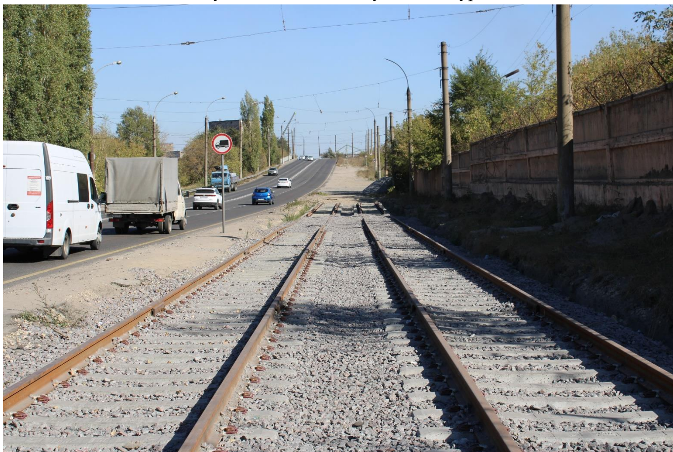
Рис. 66. Общий вид новой уложенной РШР по ул. Metallургов
