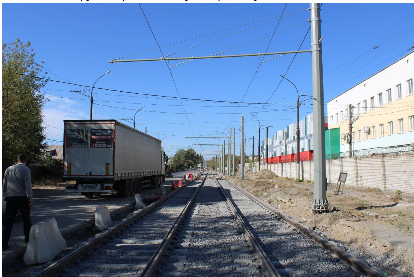
Рис. 13. Реконструкция трамвайных путей по ул. 3 Сентября
