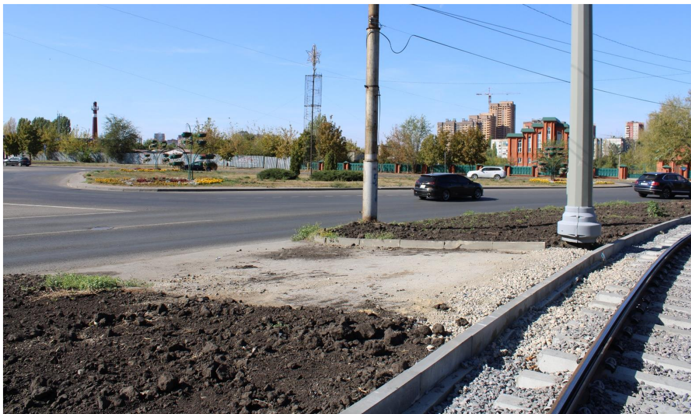
Рис. 45. Участок путей в районе пересечения ул. Полиграфическая и пр. 60 лет СССР. Наиболее целесообразно завершить работы по благоустройству с озеленением вдоль трамвайных путей
