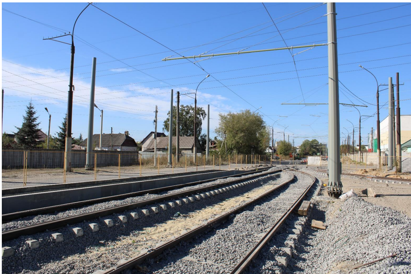
Рис. 12. Реконструкция трамвайных путей в районе ул. Чехова
