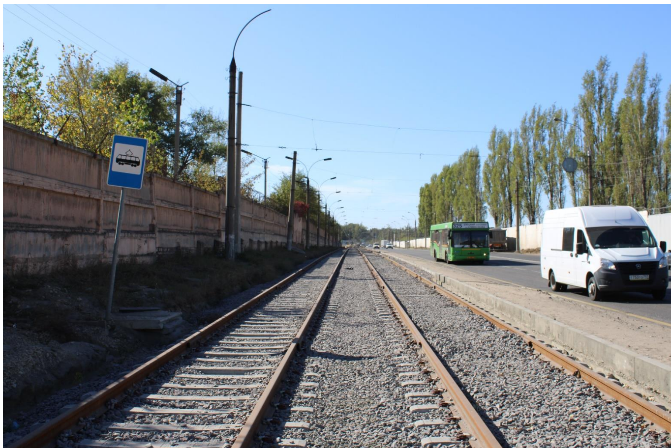
Рис. 65. Общий вид новой уложенной РШР по ул. Metallургов
