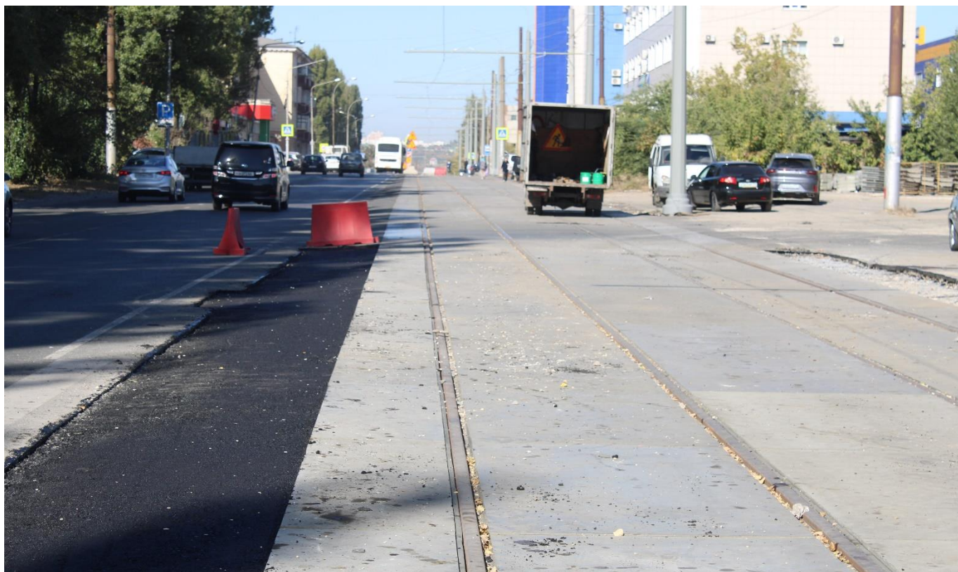
Рис. 22. Общий вид трамвайной инфраструктуры по ул. Краснозаводская
