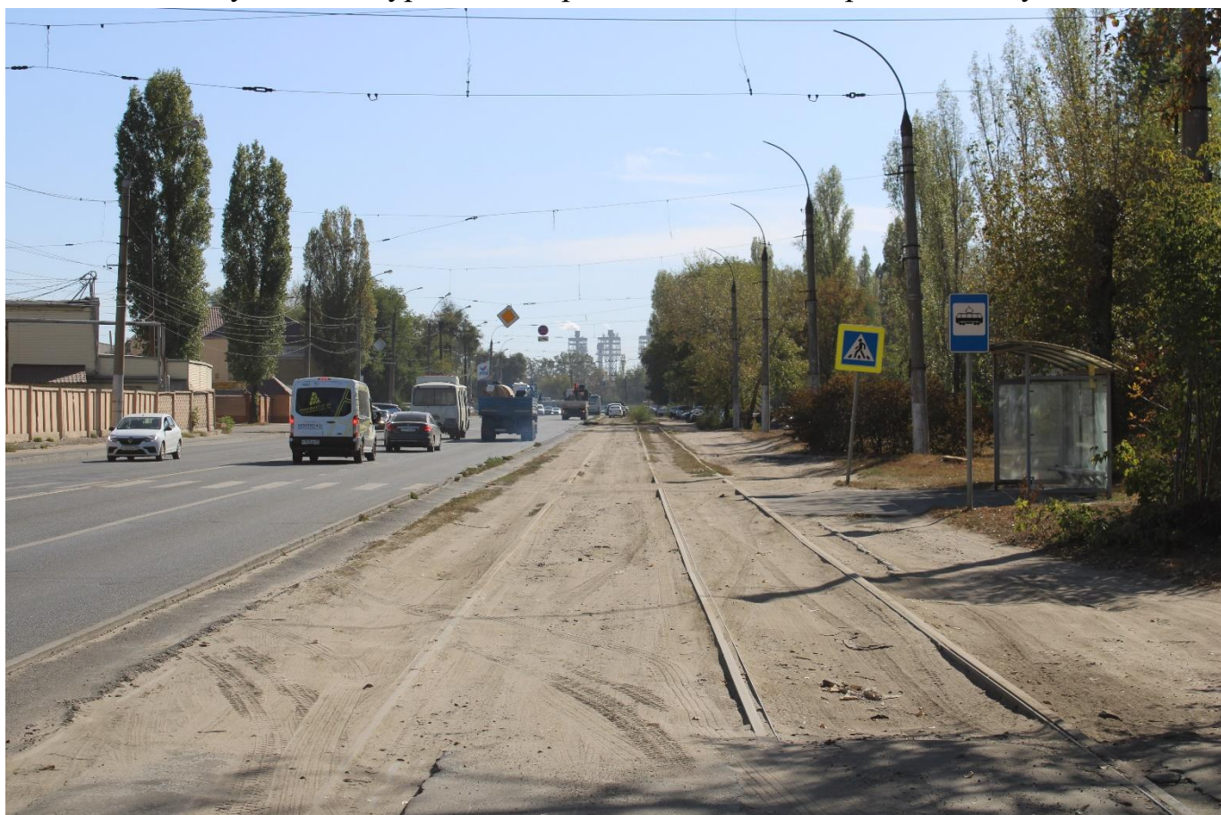
Рис. 68. Ул. 9 Мая. Демонтажные работы на момент проведения Проверки не начаты.
