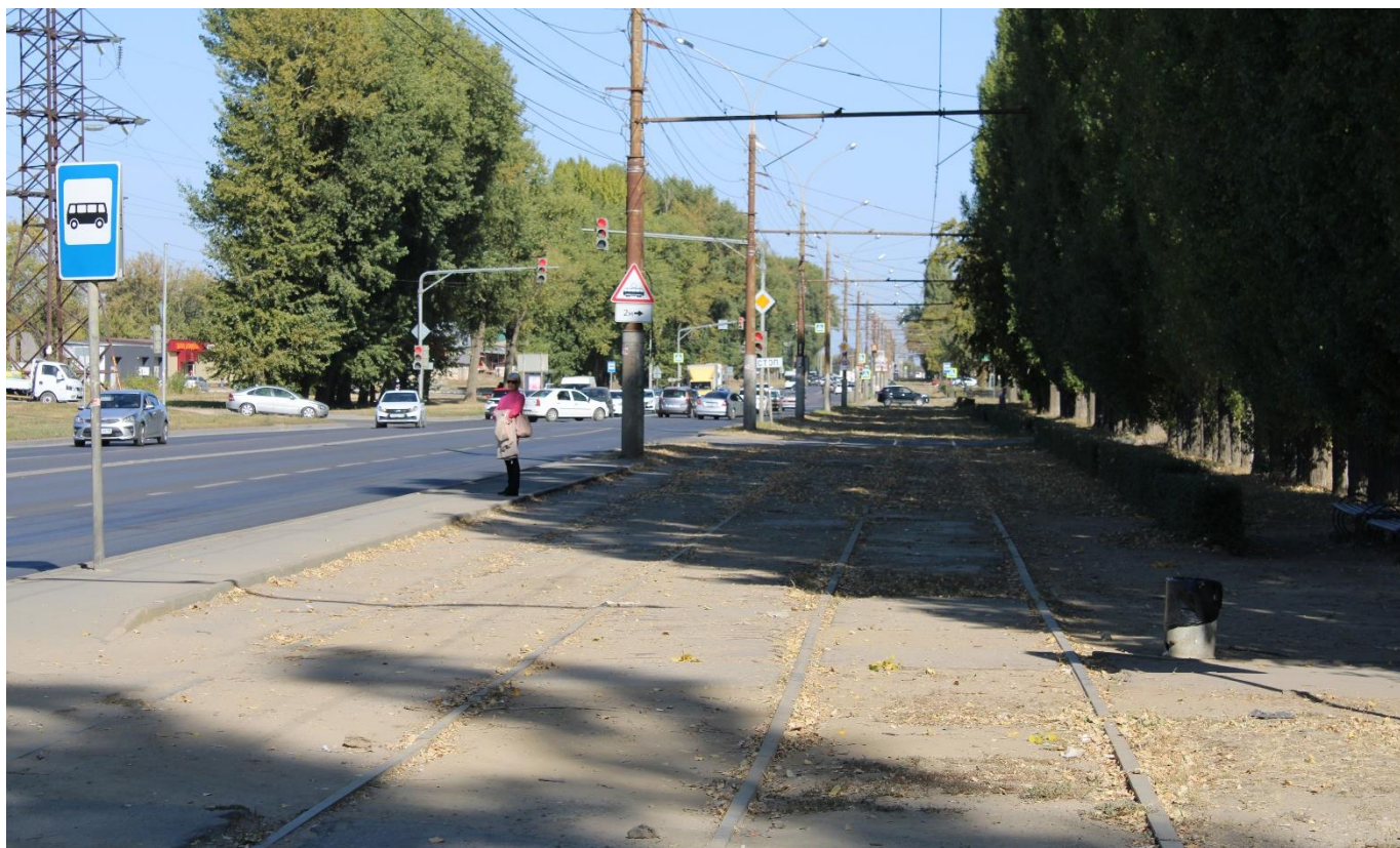
Рис. 59. Ул. Московская. Демонтаж существующих путей на момент проведения Проверки не начат
