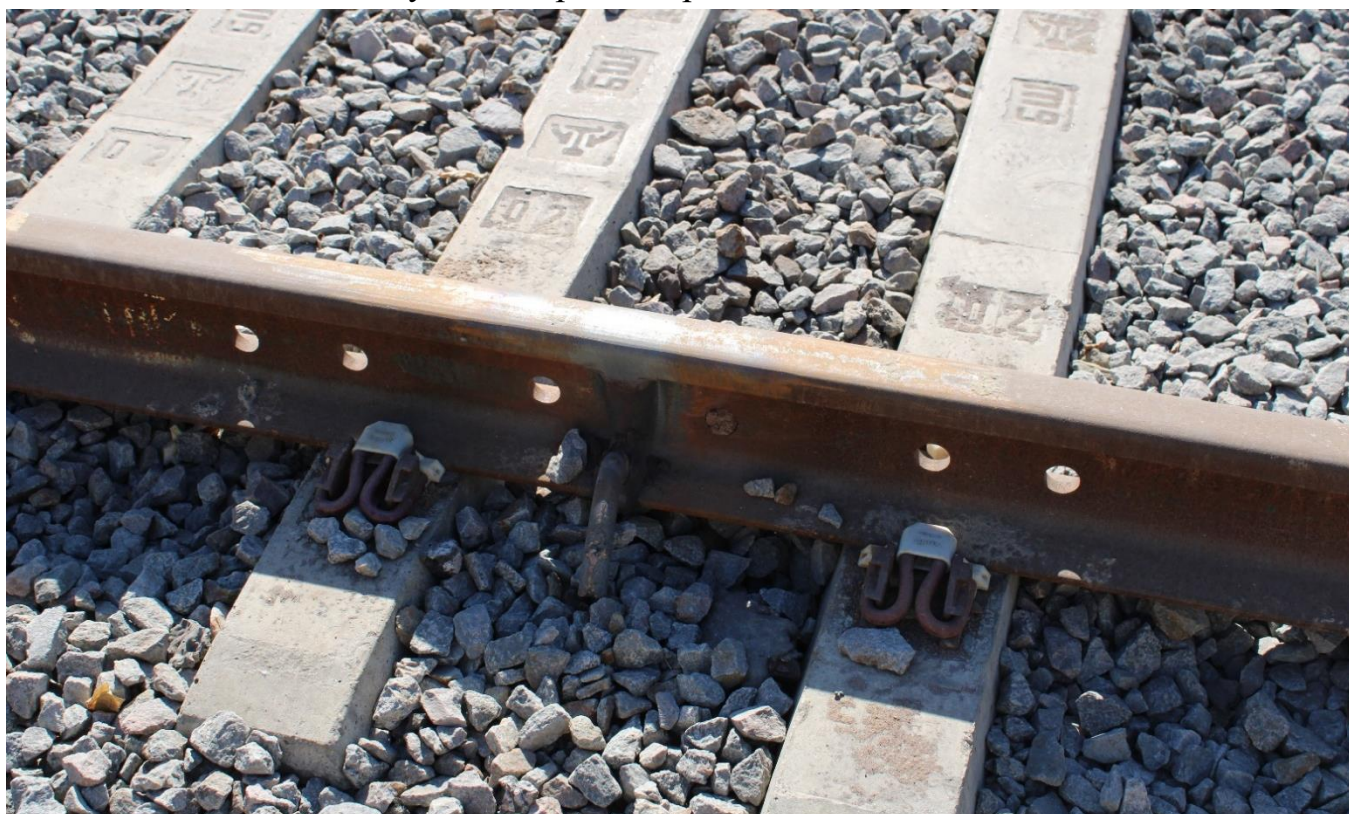
Рис. 19. Сварка стыка по ул. 3-е Сентября.
