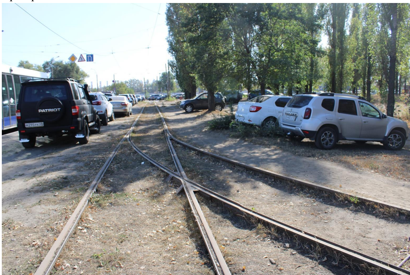
Рис. 70. Разворотный круг по ул. 9 Мая. Демонтажные работы на момент проведения Проверки не начаты.
