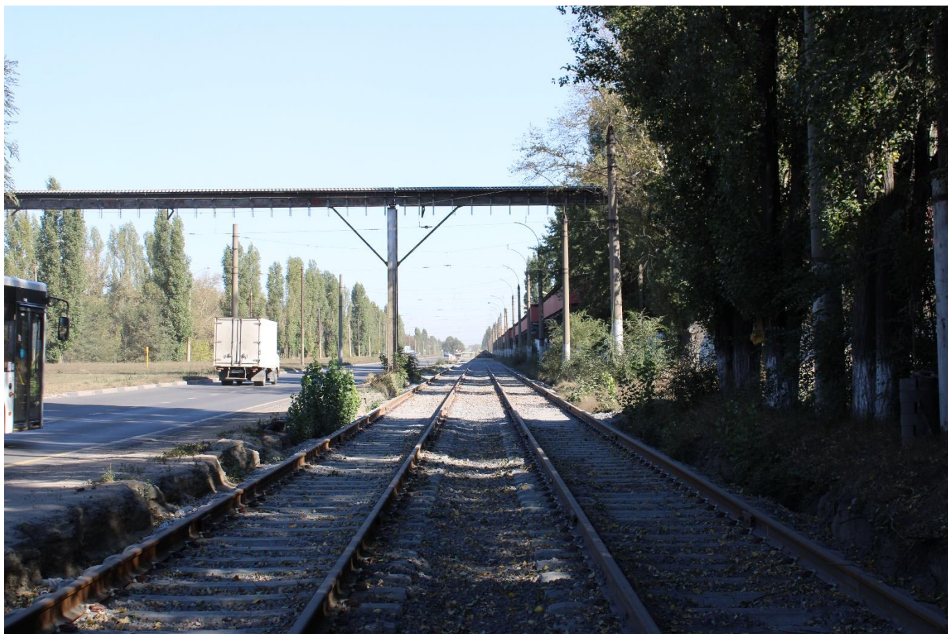
Рис. 63. Общий вид новой уложенной РШР по ул. Metallургов
