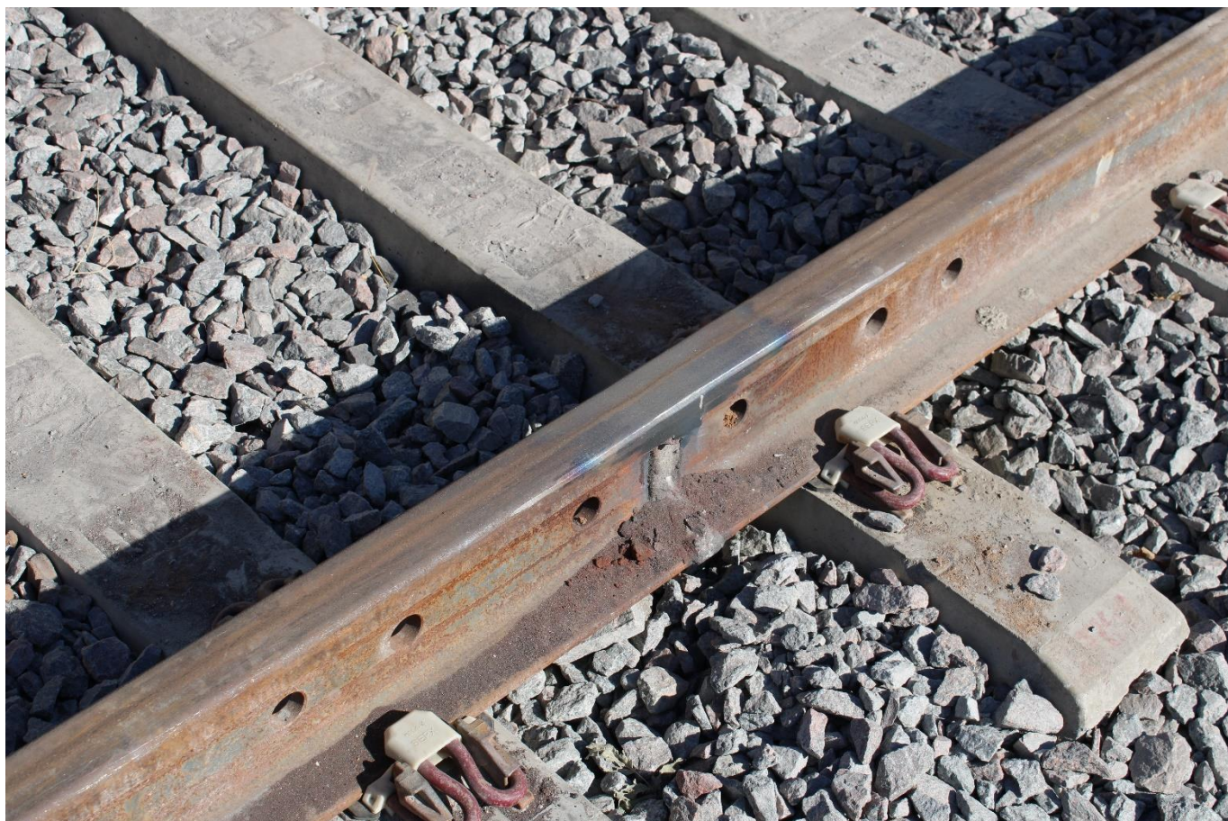
Рис. 18. Сварка стыка по ул. 3-е Сентября. Концессионеру указано на необходимость своевременной маркировки и нумерации стыков масляной краской по ГОСТ 10503 светлого тона для последующей Приёмки работ
