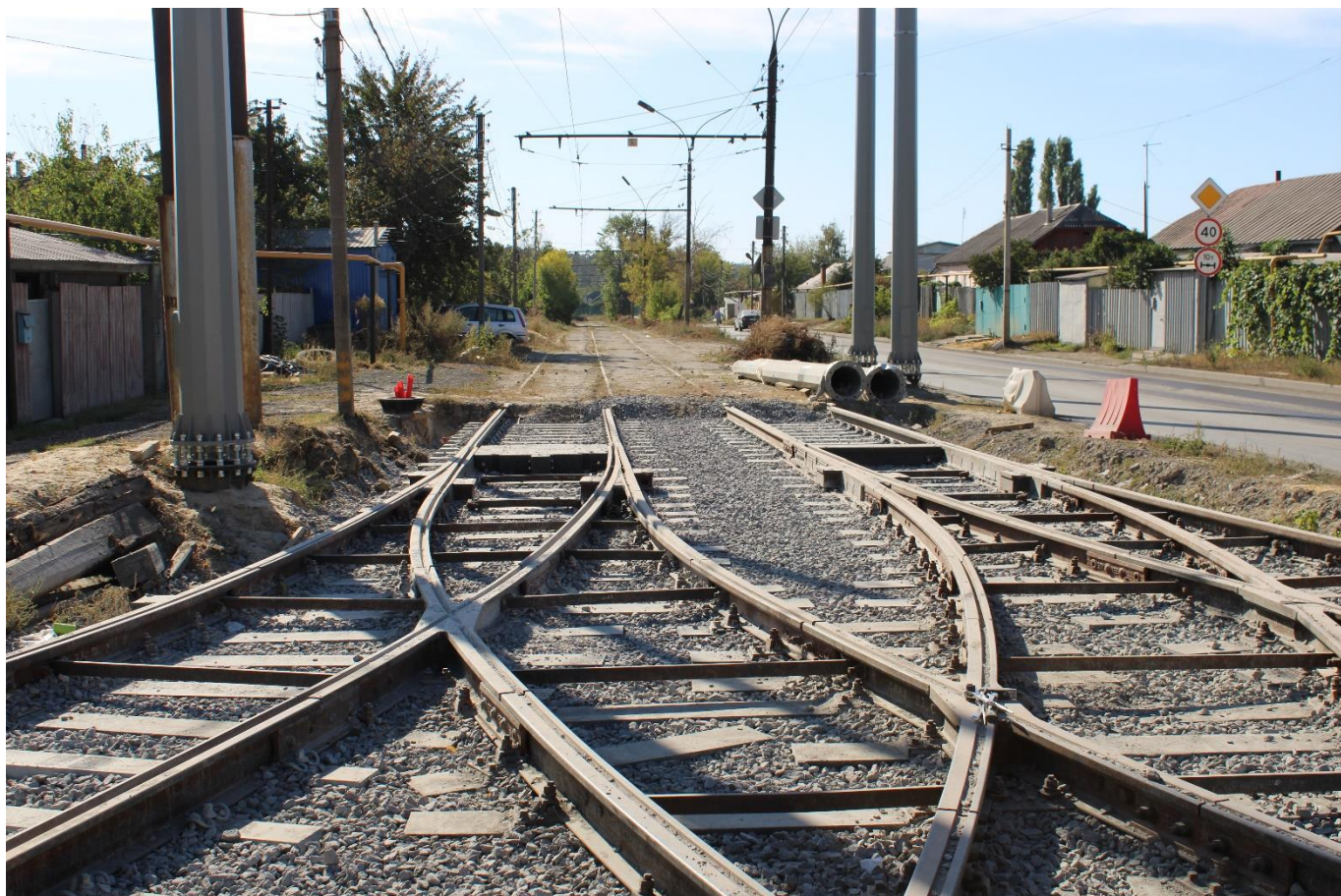
Рис. 14. Реконструкция трамвайных путей по ул. 1-я Воронежская
