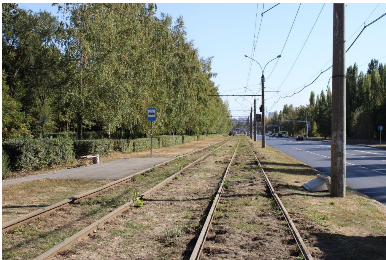
Рис. 60. Ул. Циолковского. Начата разборка верхнего строения пути
