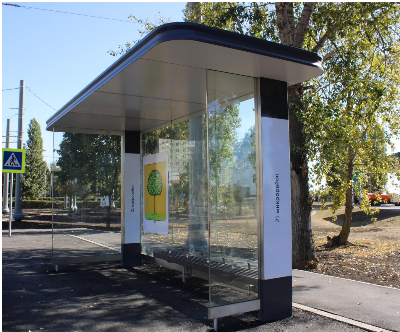
Рис. 83. Остановочный павильон, установленный на остановочном пункте «21 микрорайон».
