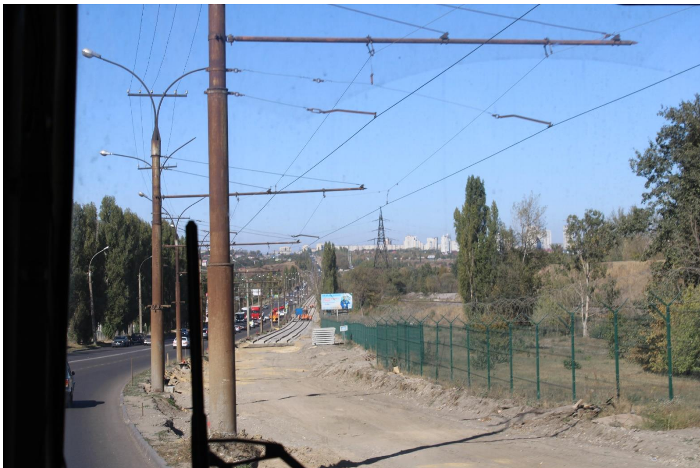
Рис. 72. Подходы к Октябрьскому мосту со стороны ЛТЗ
