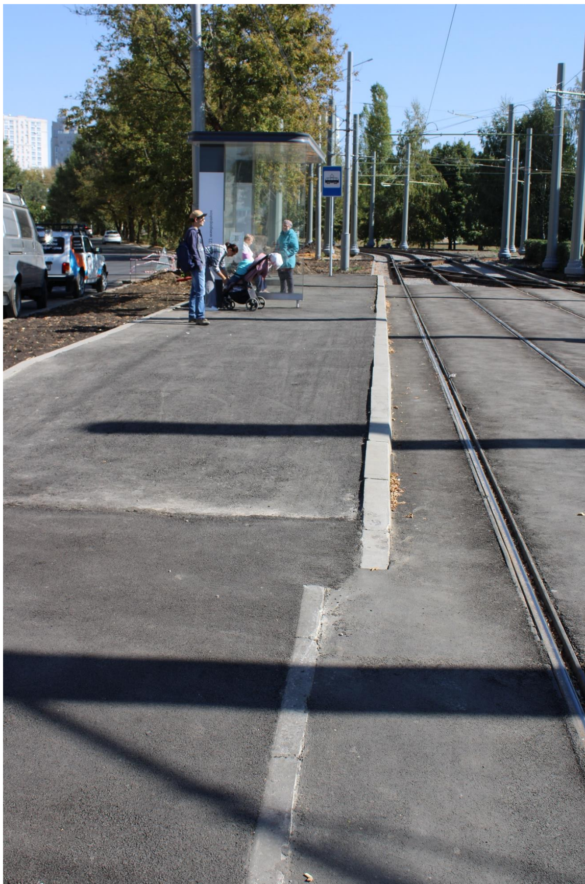
Рис. 30. Остановочный пункт «21 микрорайон». До момента начала Приёмки работ по данному этапу Концессионеру указано на целесообразность соосного расположения бортовых камней
