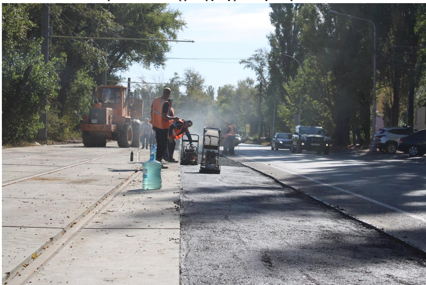
Рис. 23 Асфальтирование участка между трамвайными путями и проезжей частью автомобильной дороги по ул. Краснозаводская
