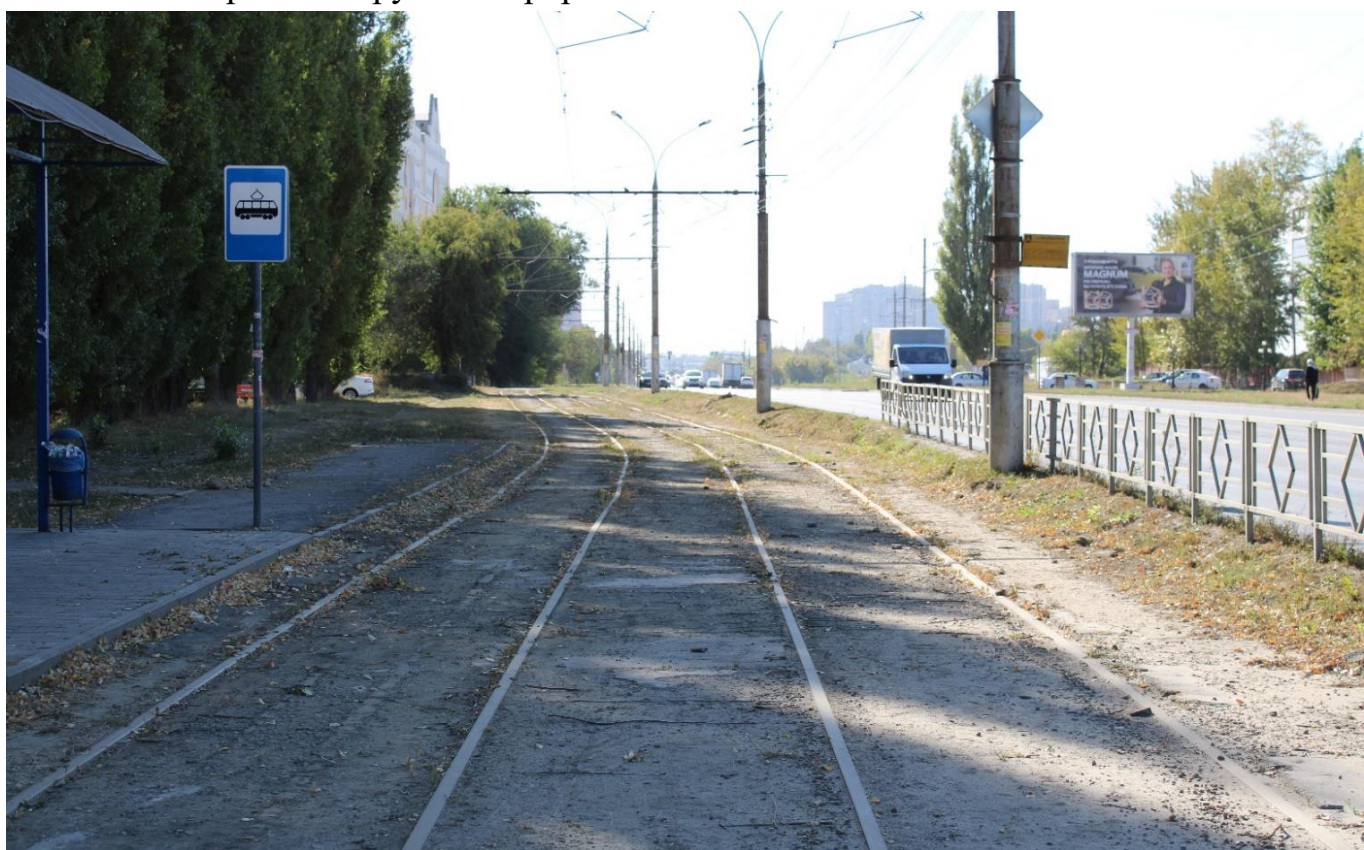
Рис. 58. Ул. Московская. Демонтаж существующих путей на момент проведения Проверки не начат
