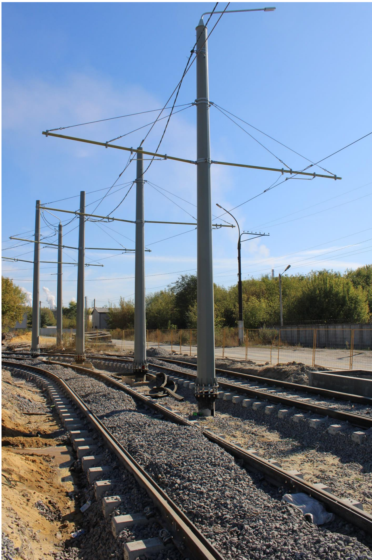
Рис. 11. Реконструкция трамвайных путей в районе ул. Чехова
