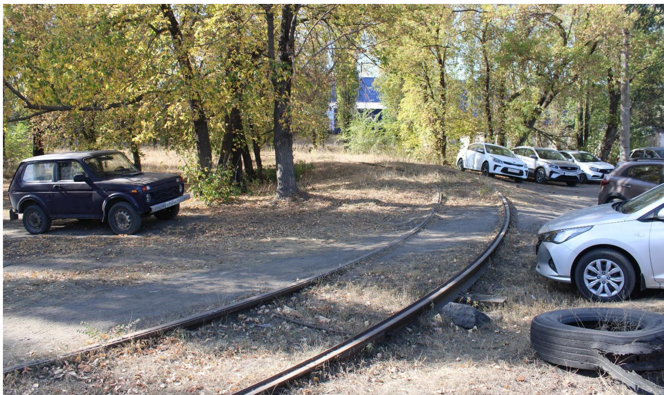
Рис. 69. Разворотный круг по ул. 9 Мая. Демонтажные работы на момент проведения Проверки не начаты.
