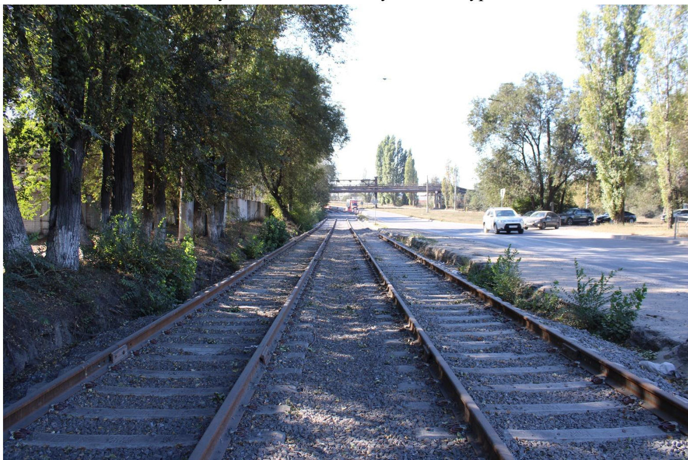
Рис. 64. Общий вид новой уложенной РШР по ул. Metallургов
