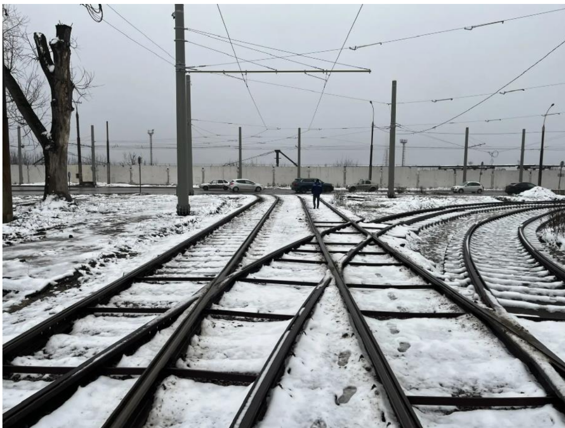
Рис. 32. Общий вид стрелочного перевода ул. Краснозаводская
