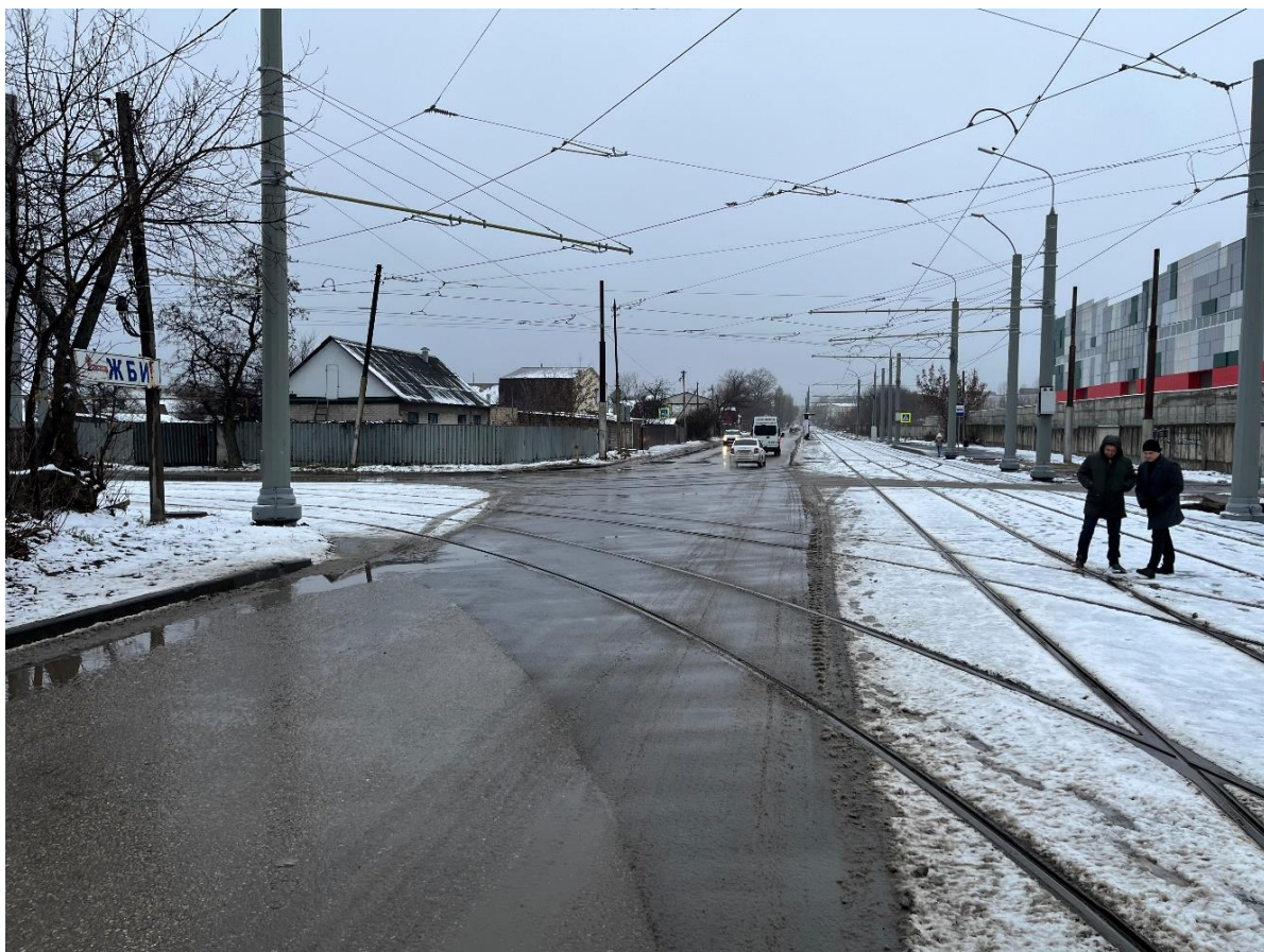
Рис. 13. Текущее состояние переезда по ул. 3 Сентября
