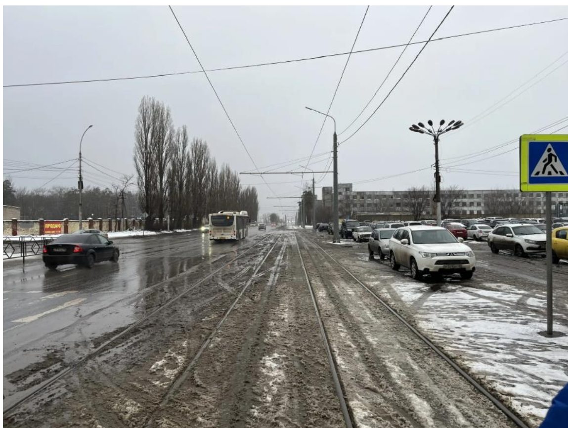
Рис. 28. Общий вид трамвайной инфраструктуры по ул. Краснозаводская в районе проходных ЛТЗ
