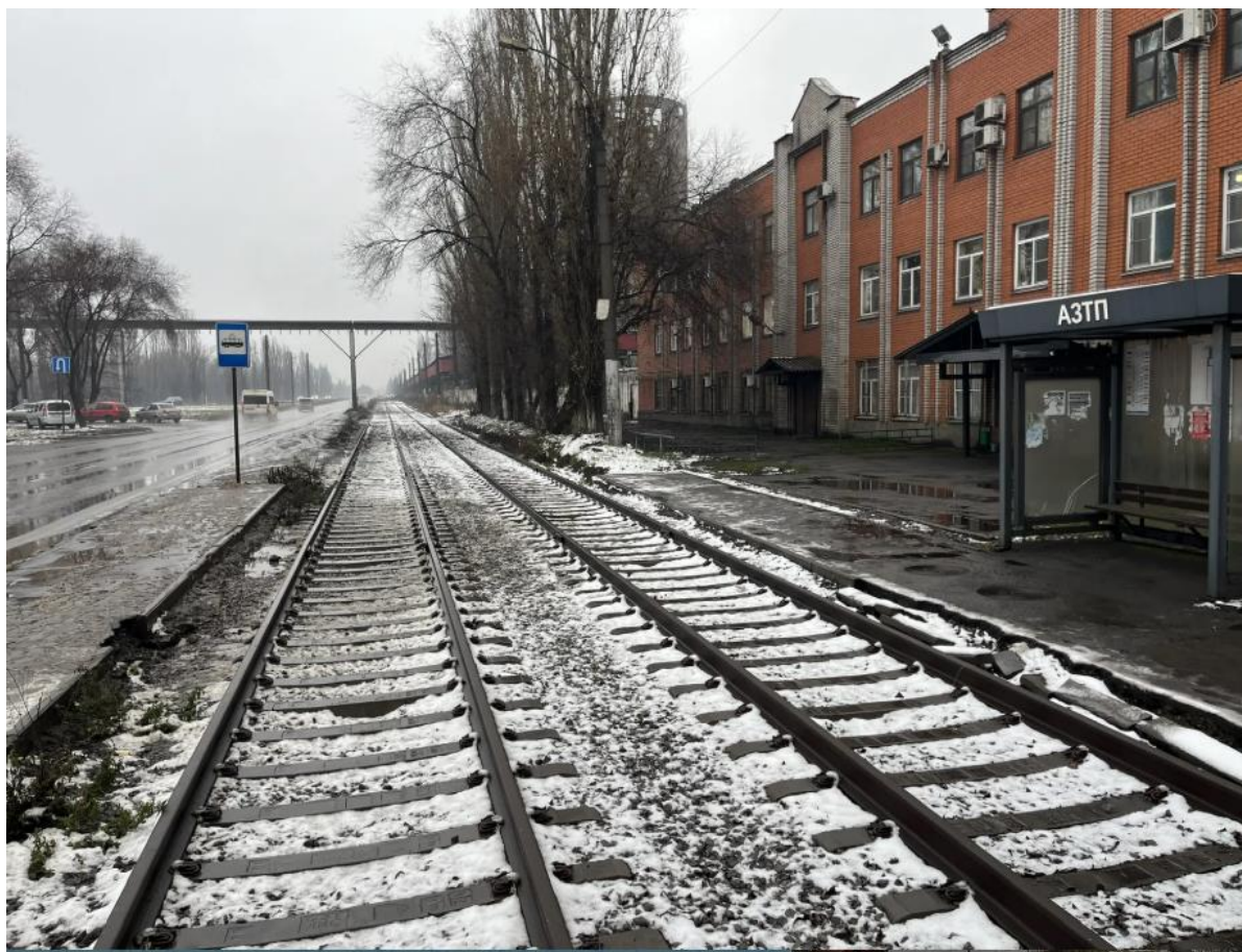
Рис. 80. Общий вид новой уложенной РШР по ул. Metallургов
