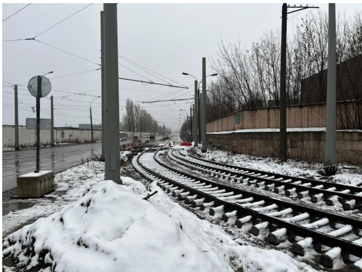
Рис. 34. Участок работ в районе пересечения ул. Краснозаводская с ул. Metallургов
