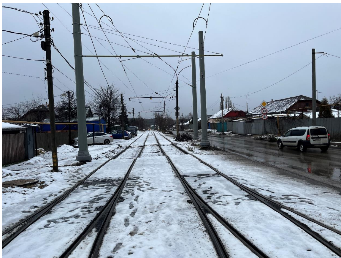
Рис. 12. Реконструкция трамвайных путей по ул. 1-я Воронежская. Выполнено сопряжение с существующими путями
