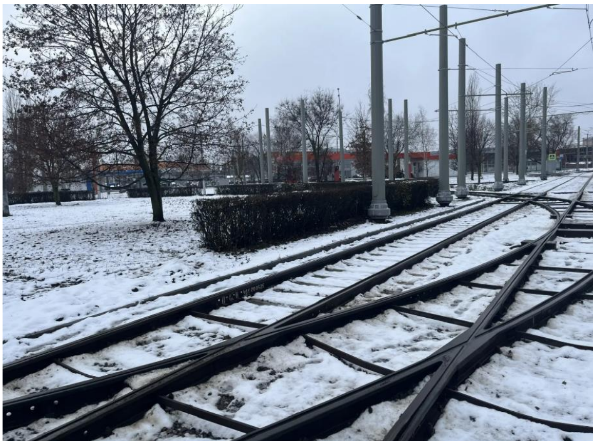
Рис. 40. Разворотный круг на 21 микрорайоне. Стрелочный перевод не работает в автоматическом режиме.
