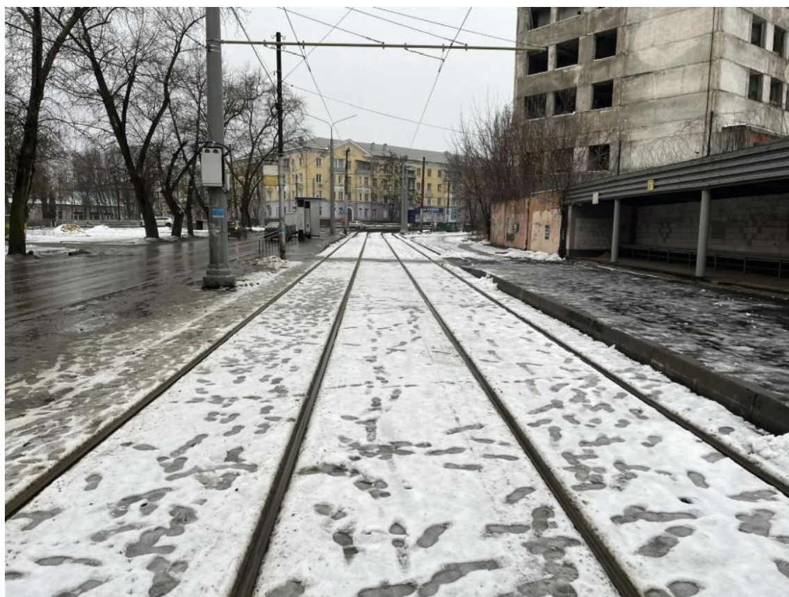
Рис. 22 Текущее состояние остановочного пункта «Площадь Клименкова»
