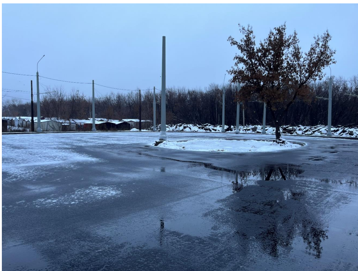
Рис. 8. Реконструкция трамвайных путей в районе ул. Чехова
