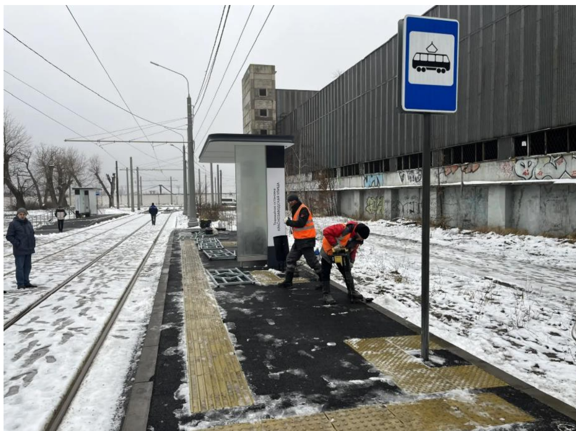
Рис. 30. Установка ограждения на остановочном пункте «Улица Краснозаводская»
