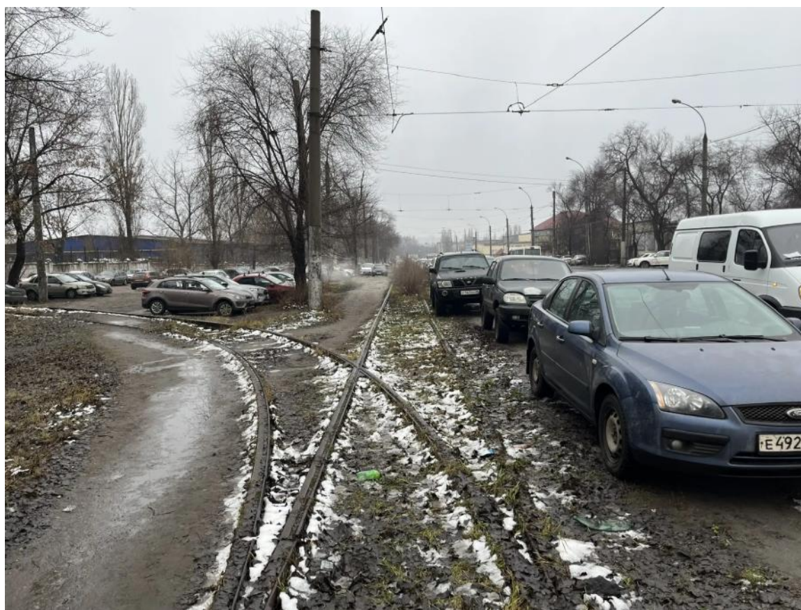
Рис. 83. Ул. 9 Мая. Демонтажные работы на момент проведения Проверки не начаты.
