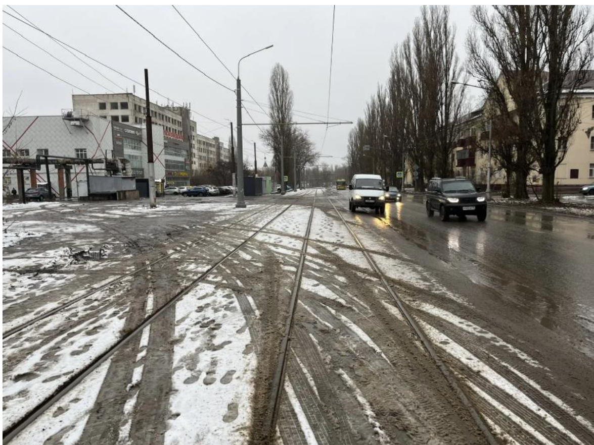
Рис. 26. Общий вид трамвайной инфраструктуры по ул. Краснозаводская
