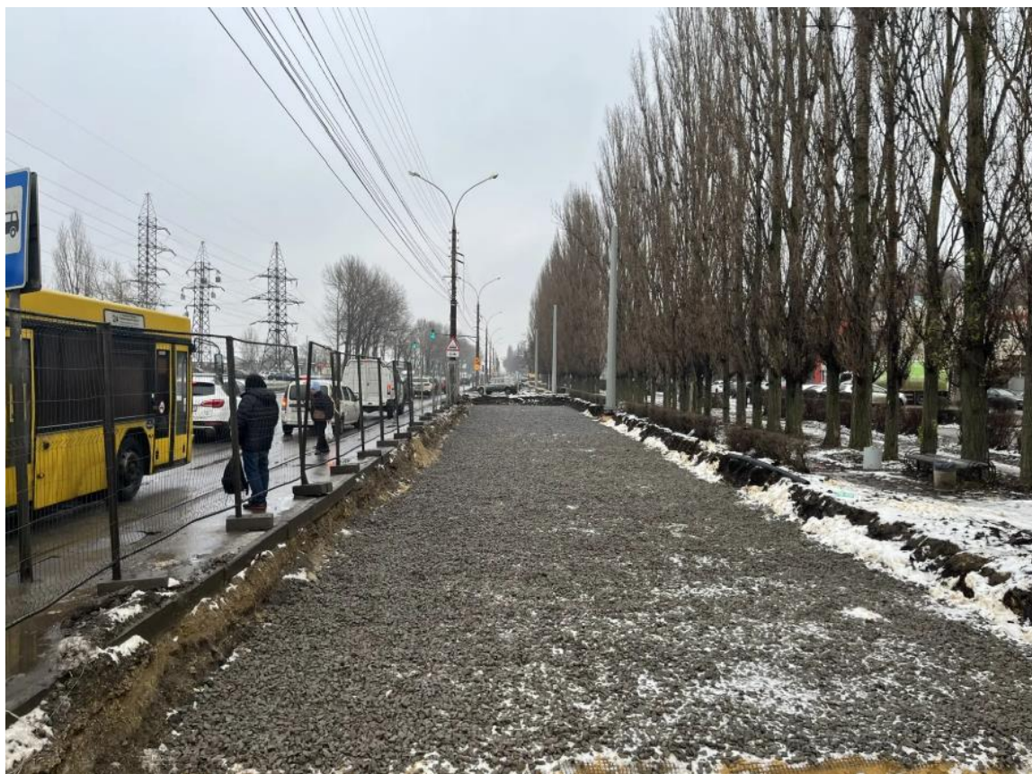
Рис. 67. Ул. Московская. Устройство балластного слоя трамвайных путей
