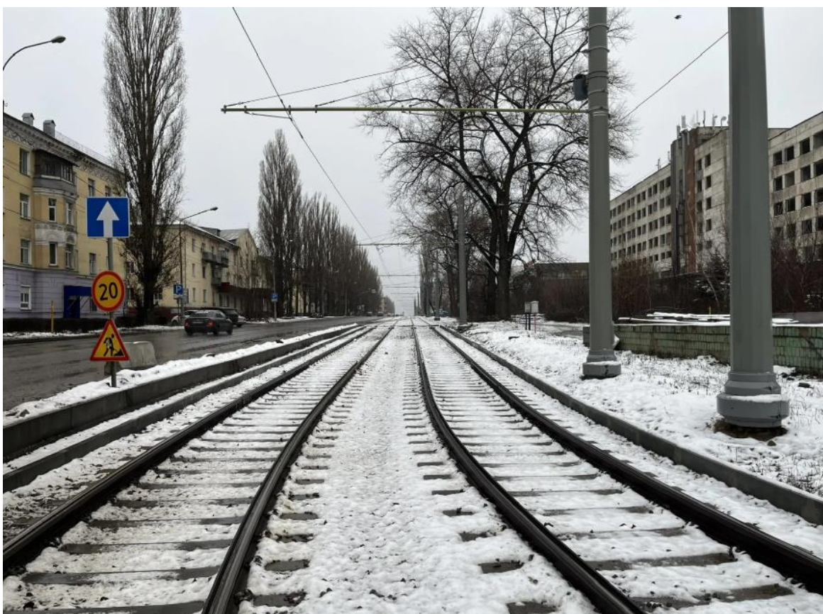
Рис. 24. Кривой участок трамвайного пути на ул. Краснозаводская
