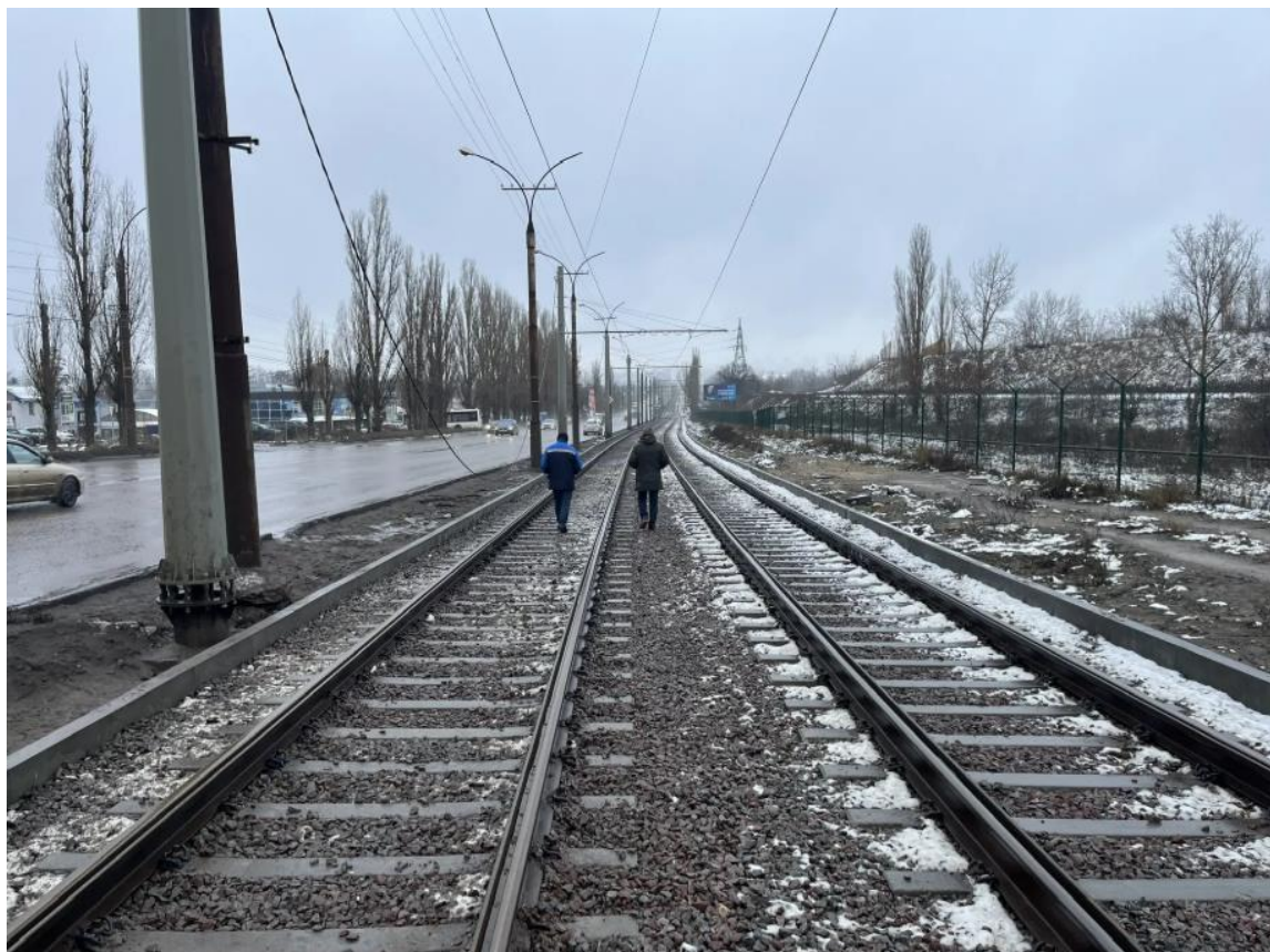
Рис. 90. Кривой участок трамвайного пути подход к Октябрьскому мосту со стороны ЛТЗ. Выполнены работы по рихтовки пути (смещена ось пути).
