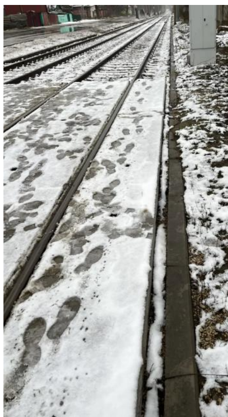
Рис. 37. Фактически примыкание выполнено с установкой бортового камня (остановочный пункт «РСУ»).
