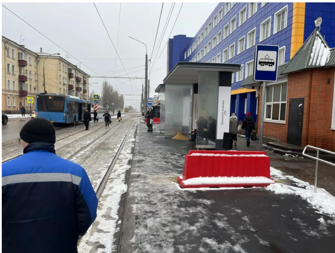
Рис. 27 Текущее состояние остановочного пункта «ЛТЗ»
