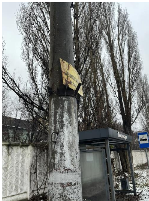
Рис. 81. Ул. Metallургов не в полном объеме демонтированы элементы старой контактной сети
