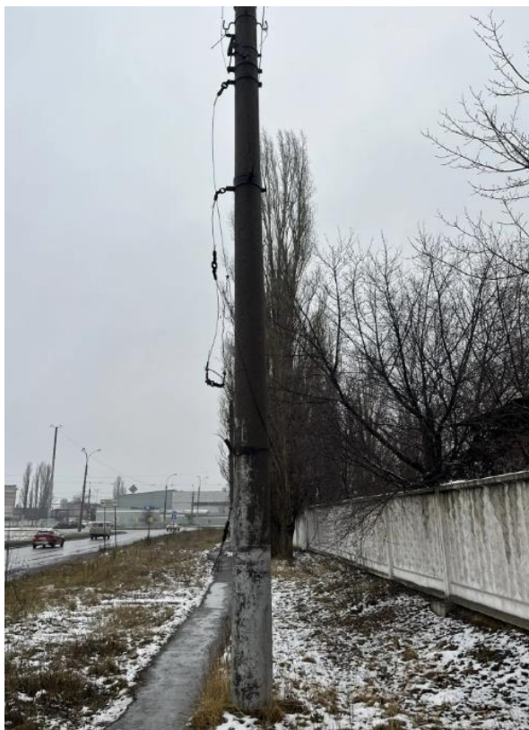
Рис. 81. Ул. Metallургов не в полном объеме демонтированы элементы старой контактной сети
