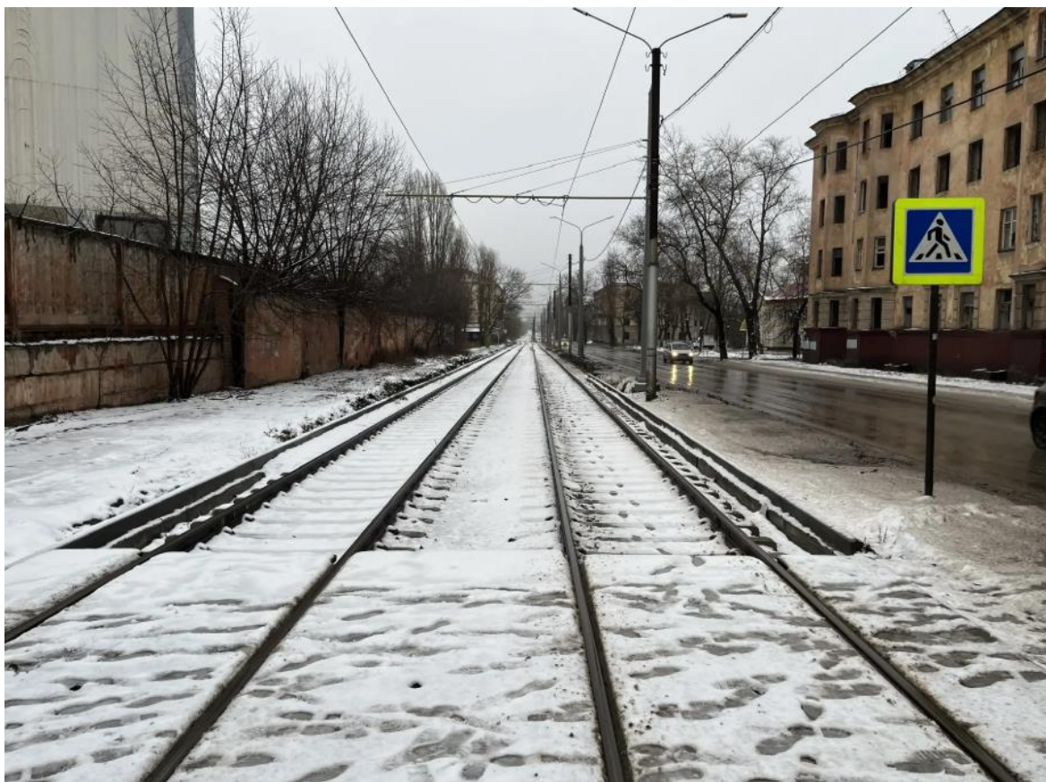
Рис. 23. Текущее состояние остановочного пункта «Площадь Клименкова»
