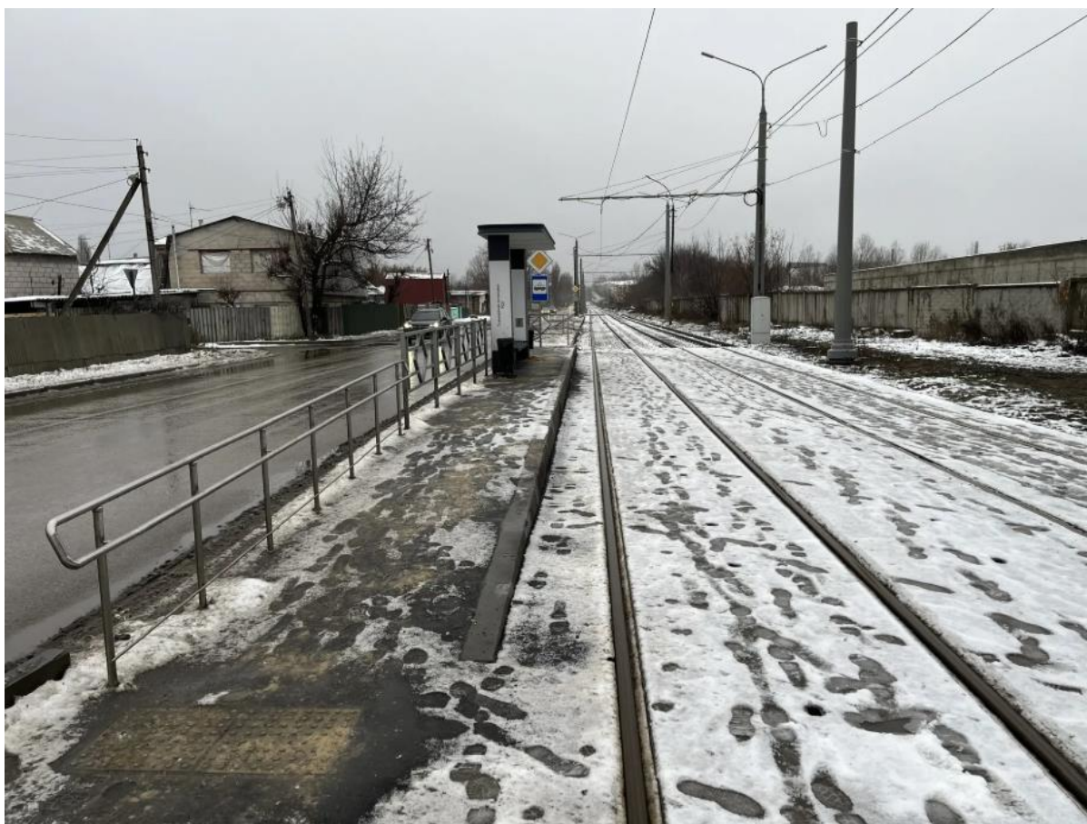
Рис. 16 Текущее состояние остановочного пункта «РСУ»
