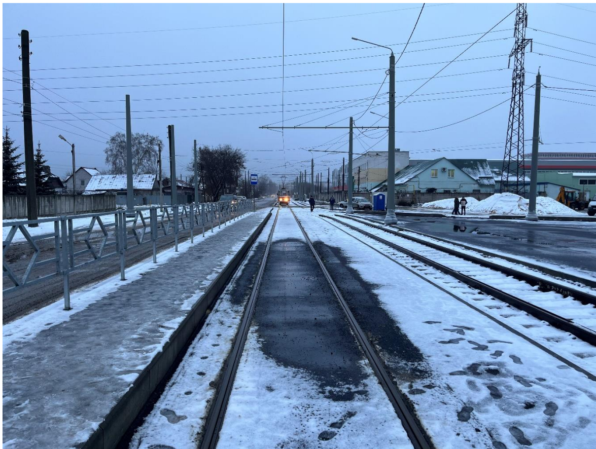
Рис. 9. Обустройство посадочной платформы в районе ул. Чехова
