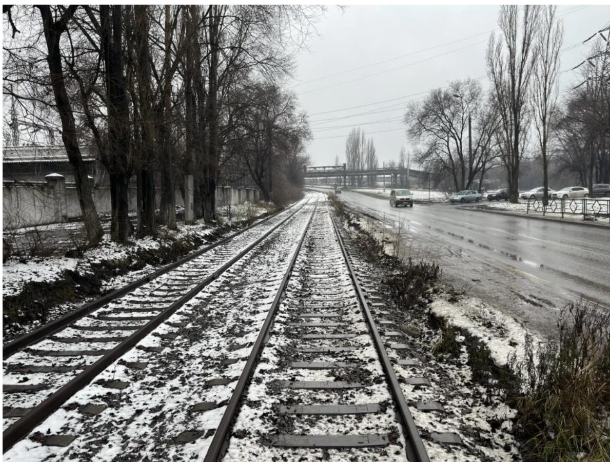
Рис. 79. Общий вид новой уложенной РШР по ул. Metallургов
