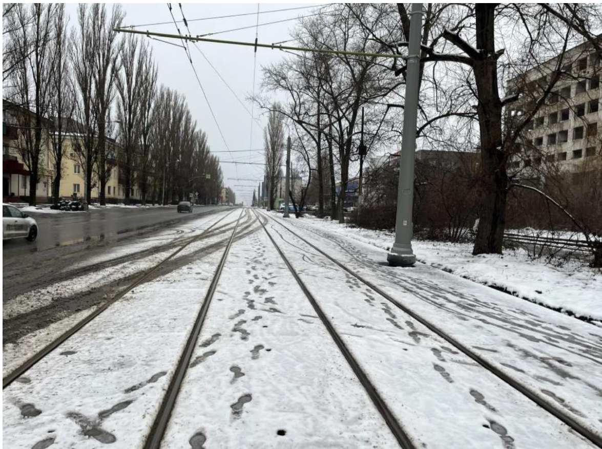
Рис. 25. Общий вид трамвайной инфраструктуры по ул. Краснозаводская
