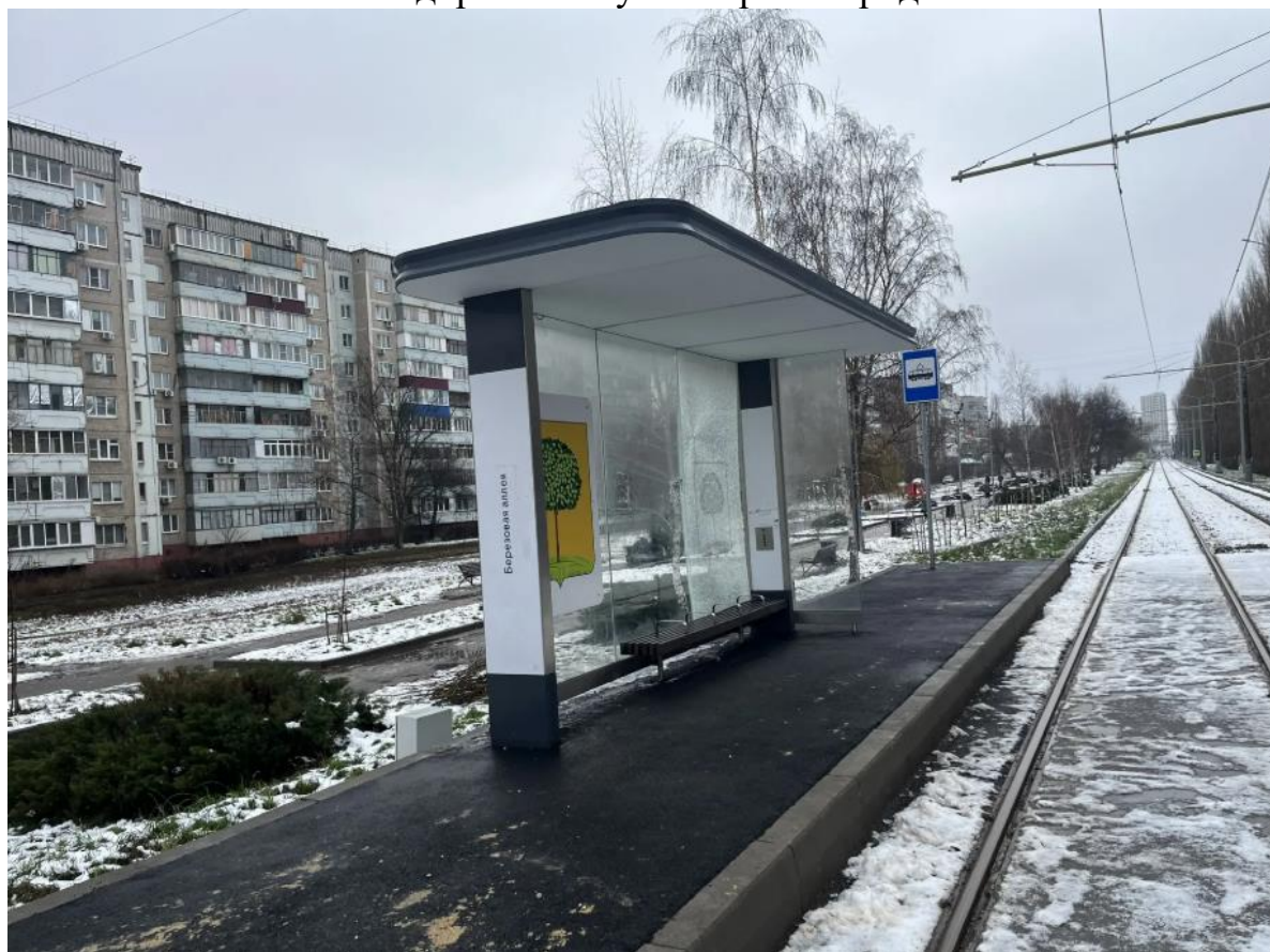
Рис. 49. Стеклопанель остановочного павильона «Березовая Аллея» в сетке трещин
