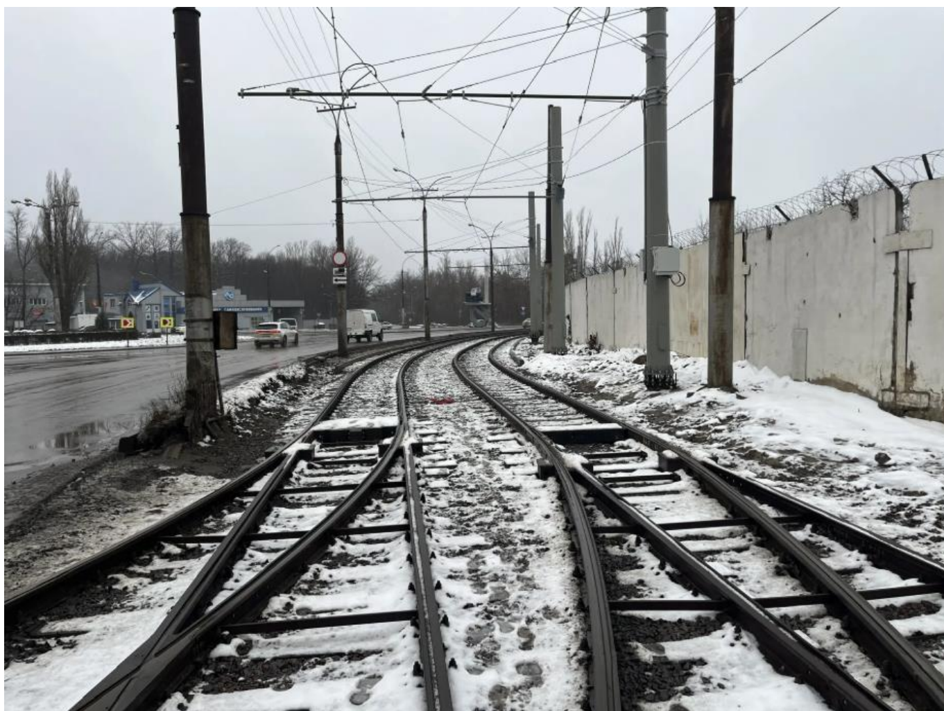
Рис. 86. Улица Metallургов. Стрелочный перевод.
