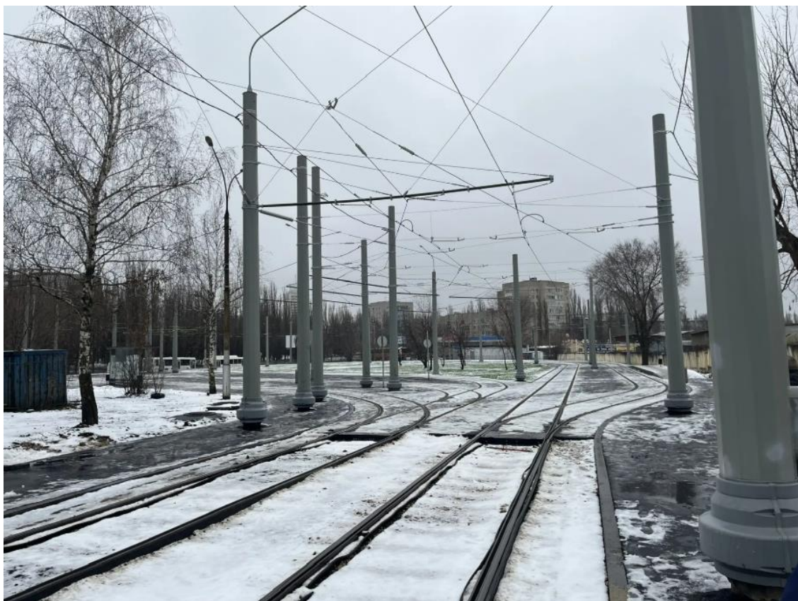
Рис. 65. Разворотный петля 9 микрорайона стрелочный перевод не работает в автоматическом режиме
