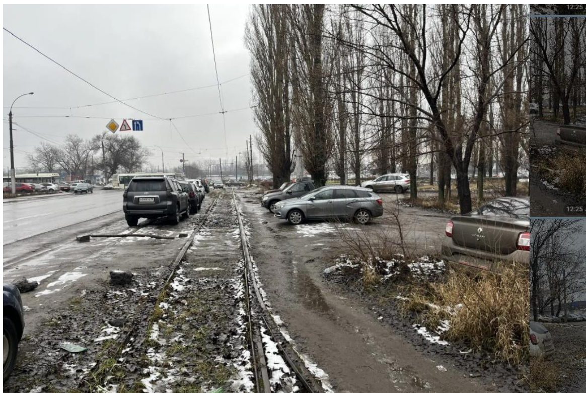
Рис. 84. Разворотный круг по ул. 9 Мая. Демонтажные работы на момент проведения Проверки не начаты.
