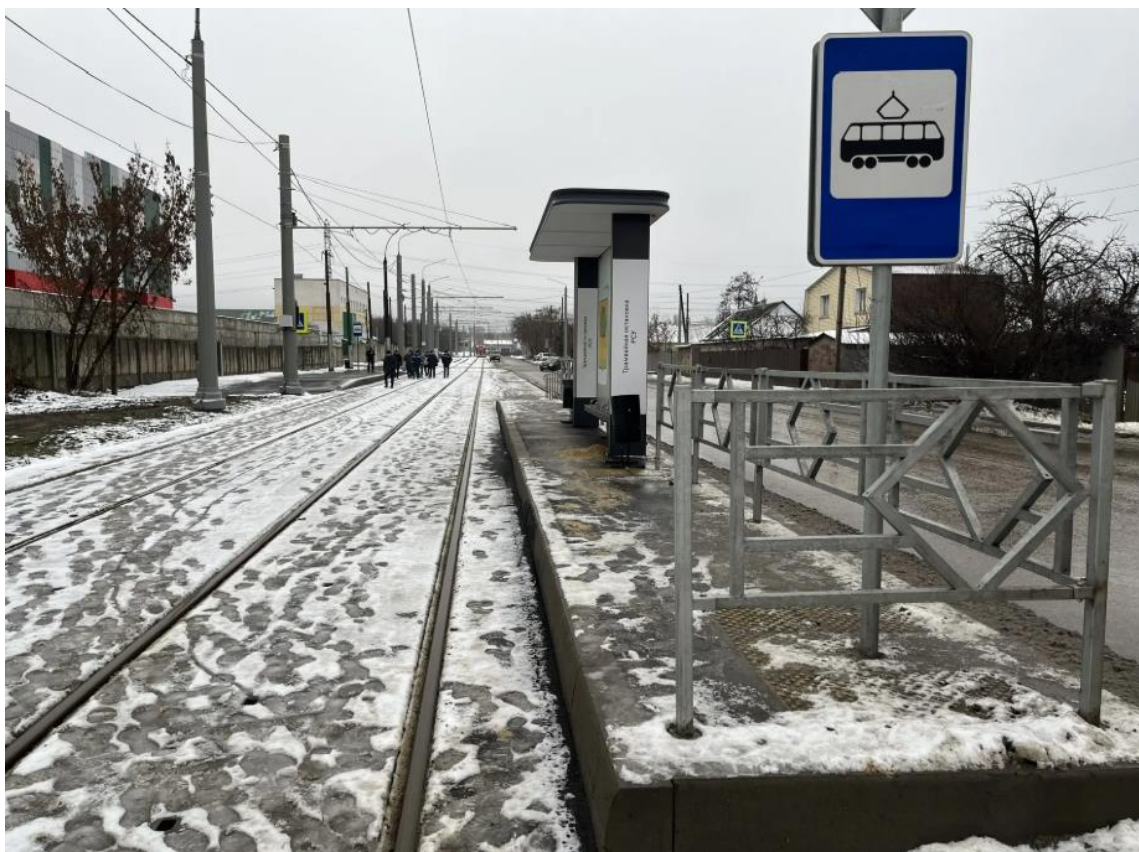
Рис. 17. Текущее состояние остановочного пункта «РСУ»
