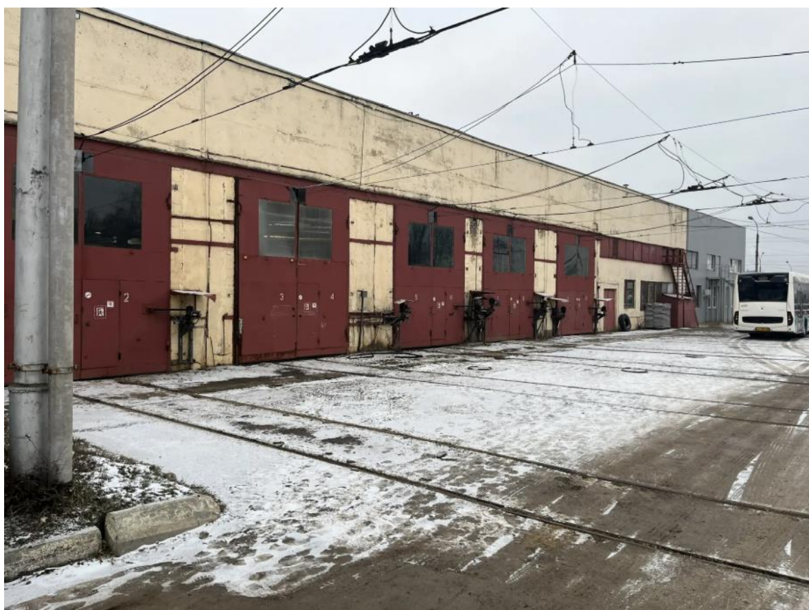
Рис. 102. Общий вид трамвайного депо на момент проведения Проверки.
