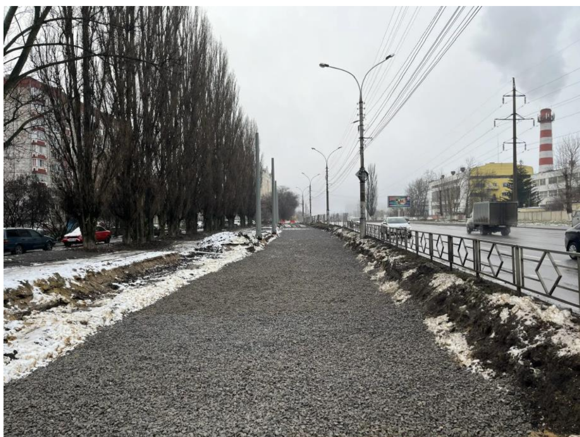
Рис. 68. Ул. Московская. Устройство балластного слоя трамвайных путей
