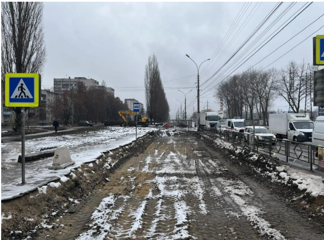
Рис. 69. Ул. Московская. Остановочный пункт «Швейная фирма». Разработка котлована
