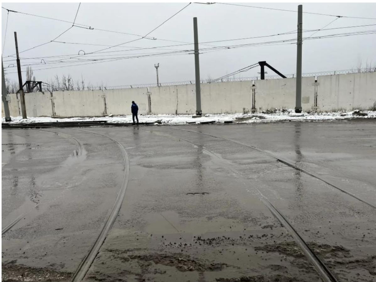
Рис. 33. Переезд в районе пересечения ул. Краснозаводская с ул. Metallургов
