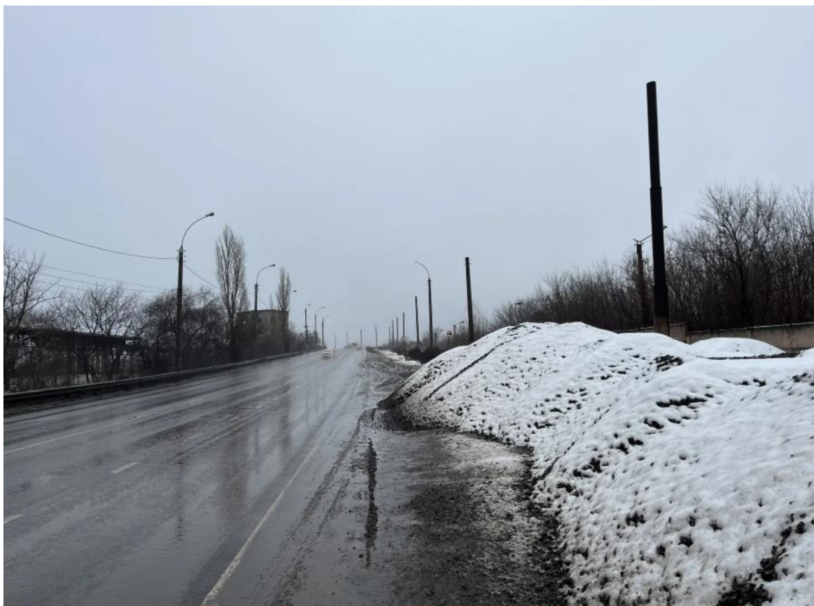
Рис. 78. Трамвайные пути ул. Metallургов. Подход к путепроводу «Западный»
