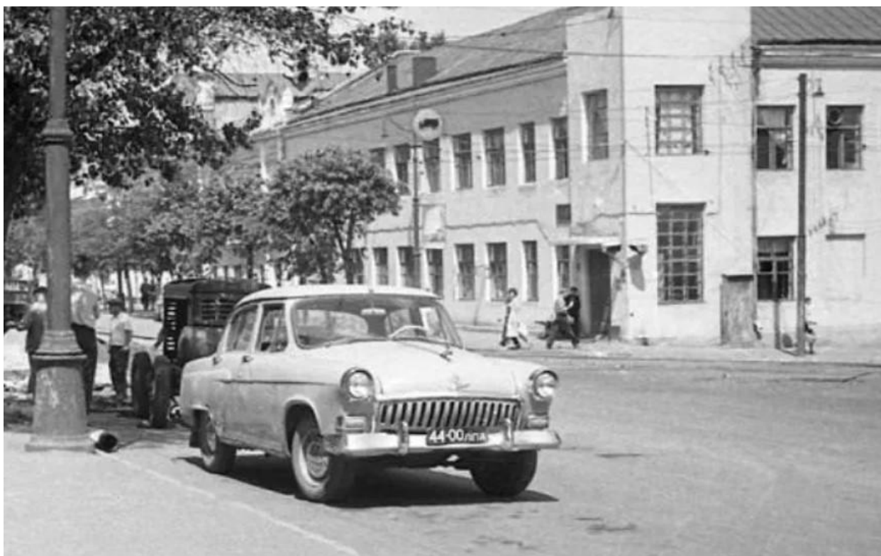
Рисунок 22 - Фотография 1973 г. вид на современное здание Фрунзе 1.
