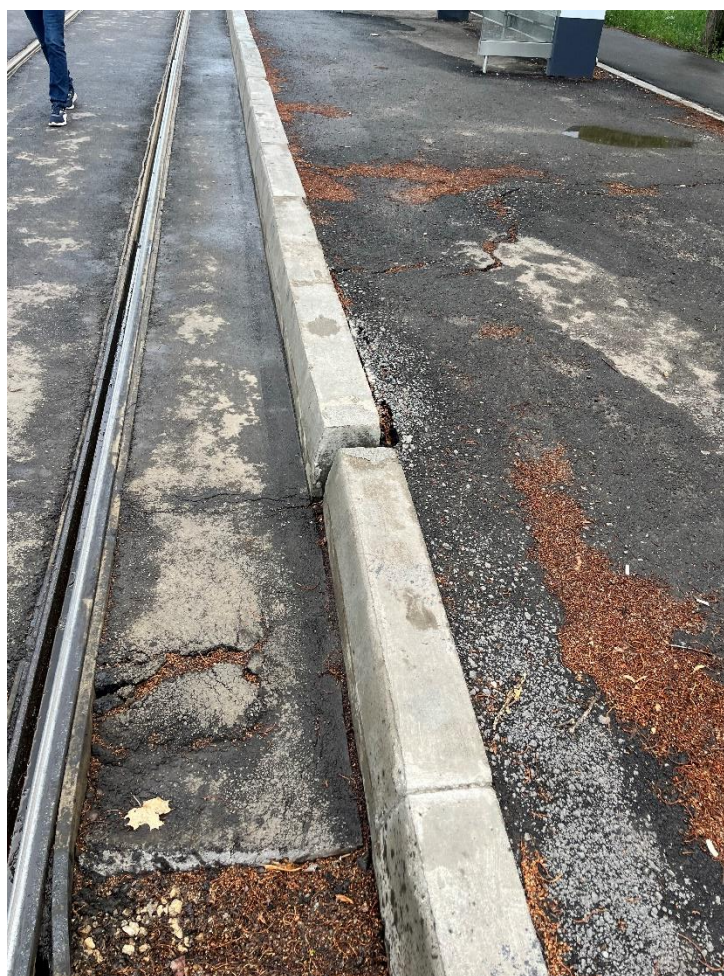
Рис. 49. Просадка грунта в районе посадочной площадки остановочного пункта «21 микрорайон»
