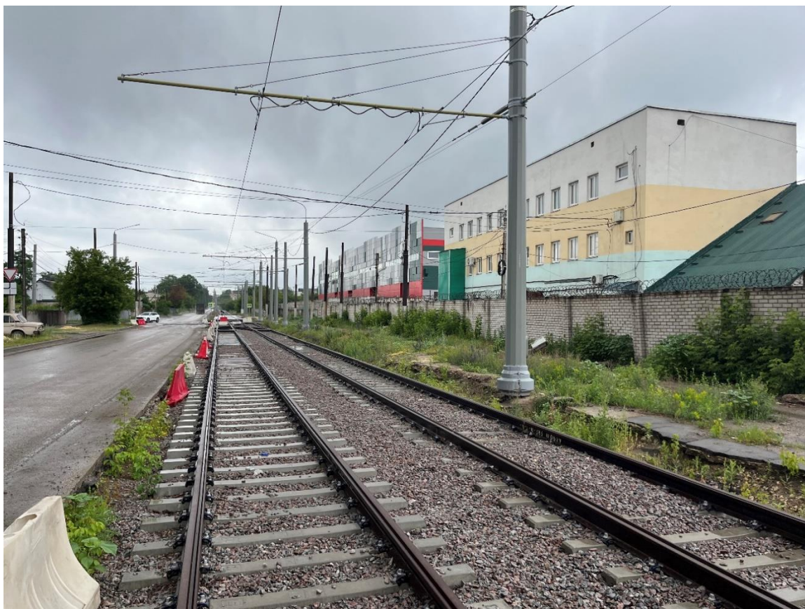
Рис. 22. Трамвайные пути по ул. 3 Сентября
