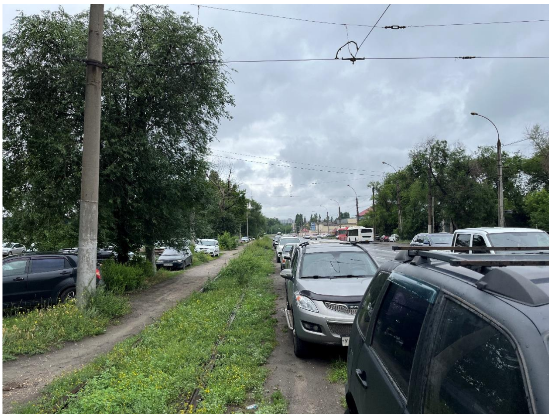
Рис. 91. Ул. 9 Мая. Демонтажные работы на момент проведения Проверки не начаты.
