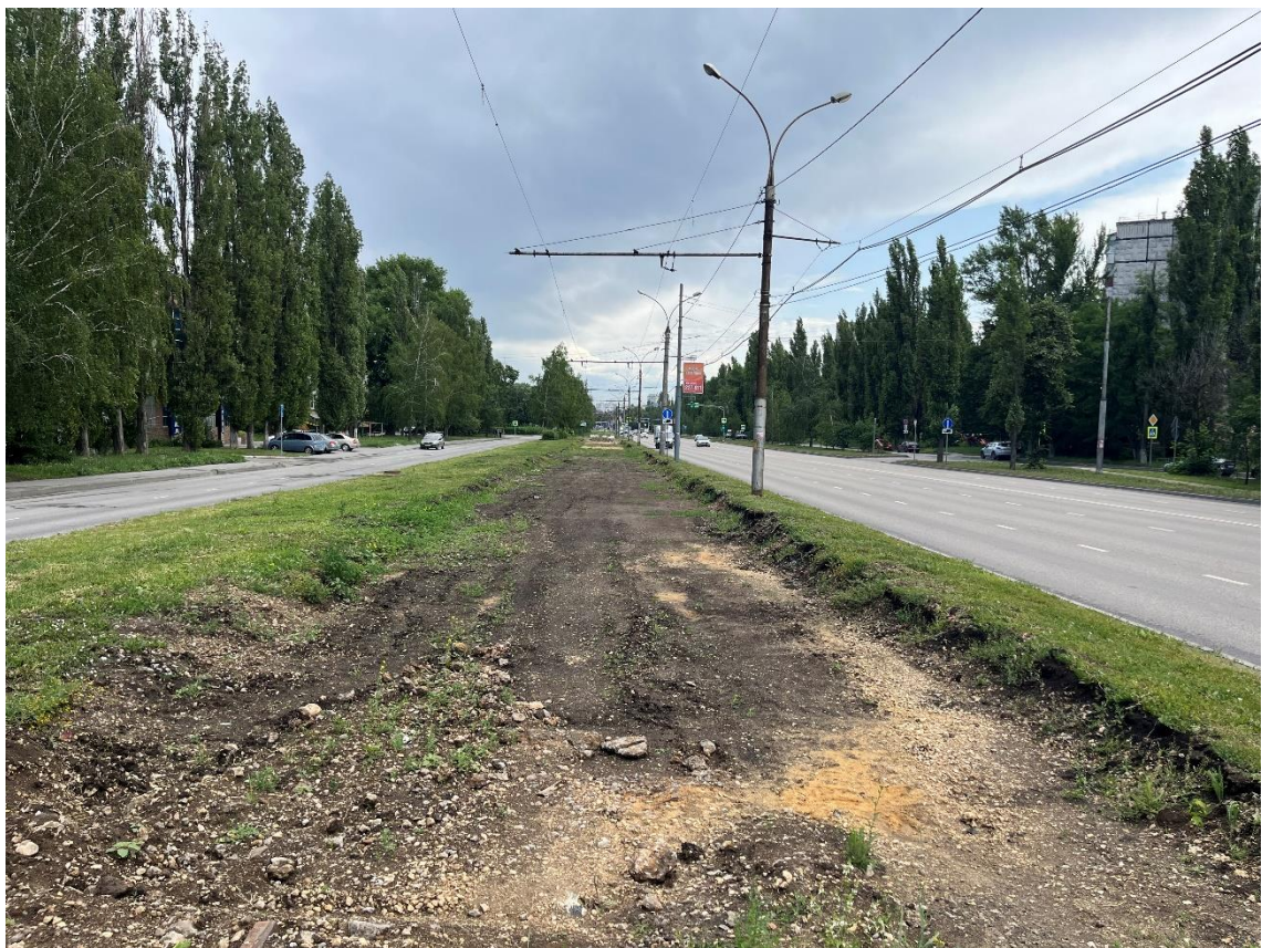
Рис. 77. Ул. Циолковского. Осуществлён демонтаж существующих путей за исключением переездов
