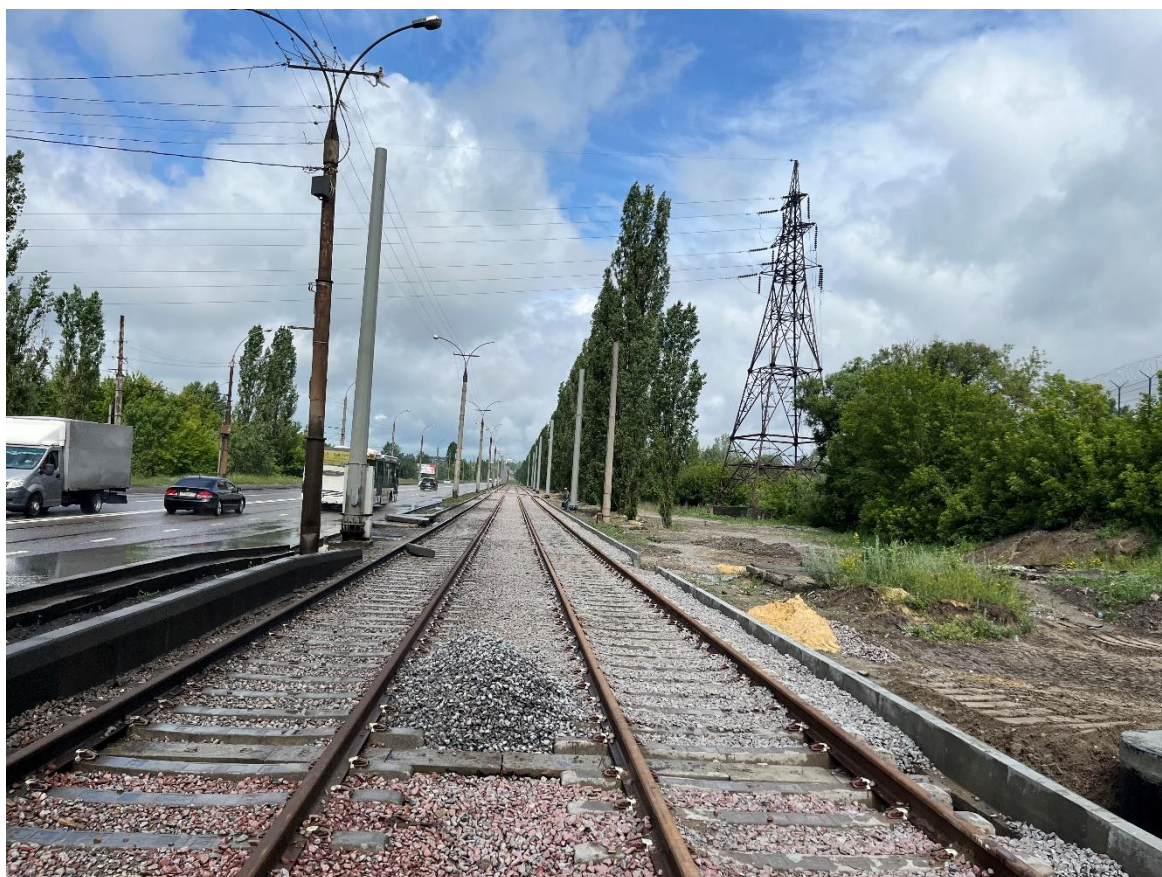
Рис. 98. Обустройство посадочной площадки на остановке «ул. Речная».
