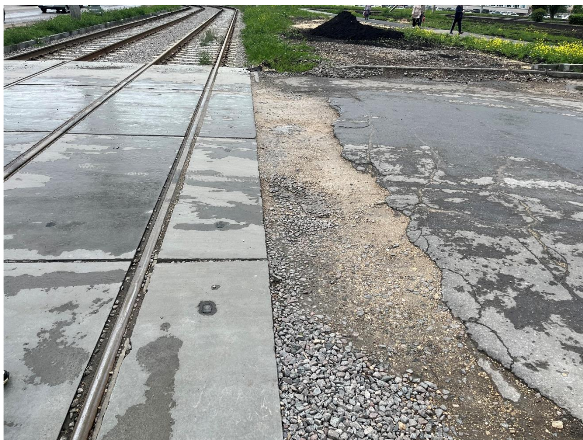
Рис. 51. Переезд через трамвайные пути по ул. Меркулова
