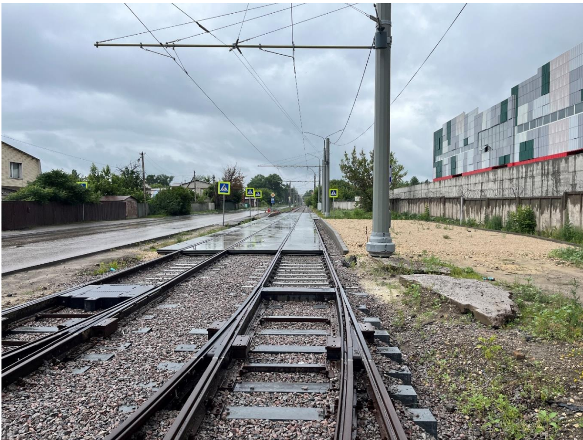
Рис. 26 Текущее состояние остановочного пункта «РСУ»
