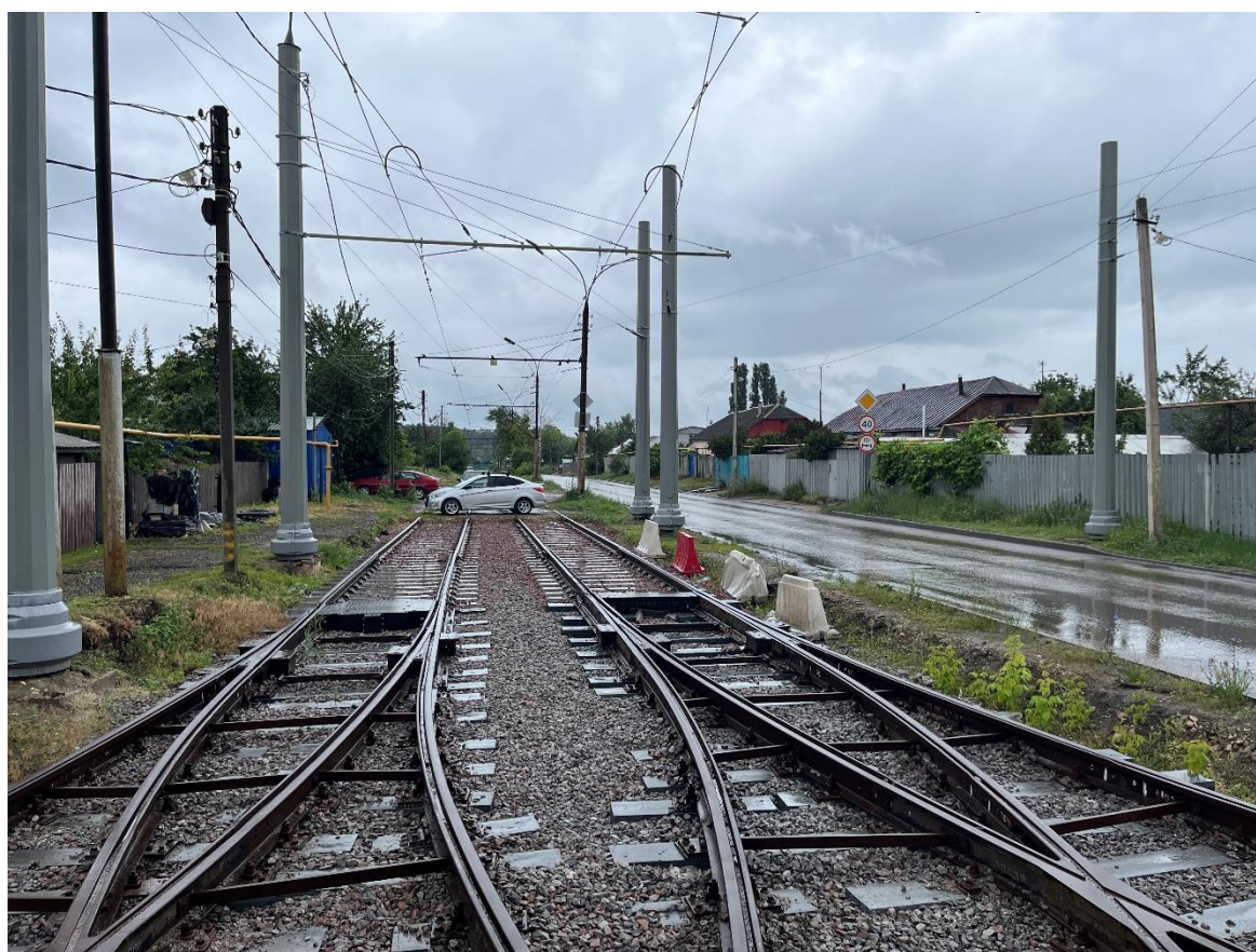
Рис. 23. Реконструкция трамвайных путей по ул. 1-я Воронежская. Выполнено сопряжение с существующими путями
