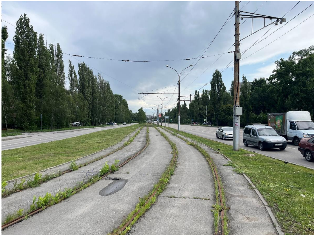
Рис.76. Трамвайные пути в районе остановочного пункта «Кольцо трубного завода»
