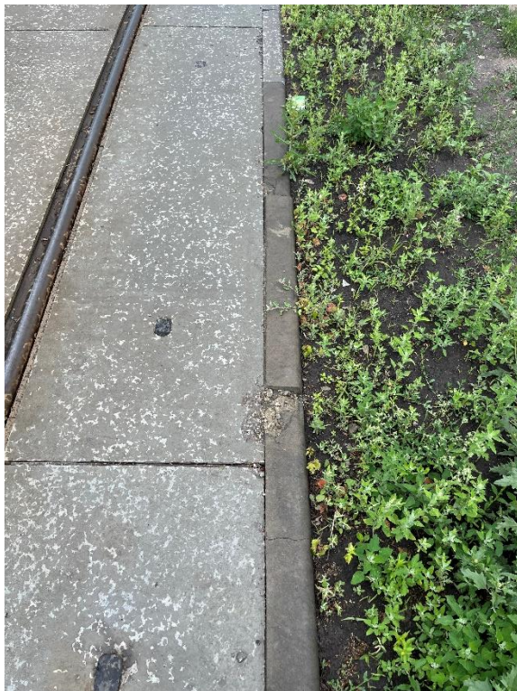
Рис. 65. Повреждение бортового камня на остановочном пункте «Улица Полиграфическая»
