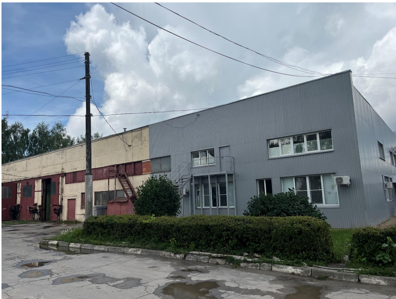
Рис. 108. Общий вид трамвайного депо на момент проведения Проверки. Серая облицовка части производственного корпуса выполнялась МУП «Горэлектротранс» ещё до заключения Соглашения
