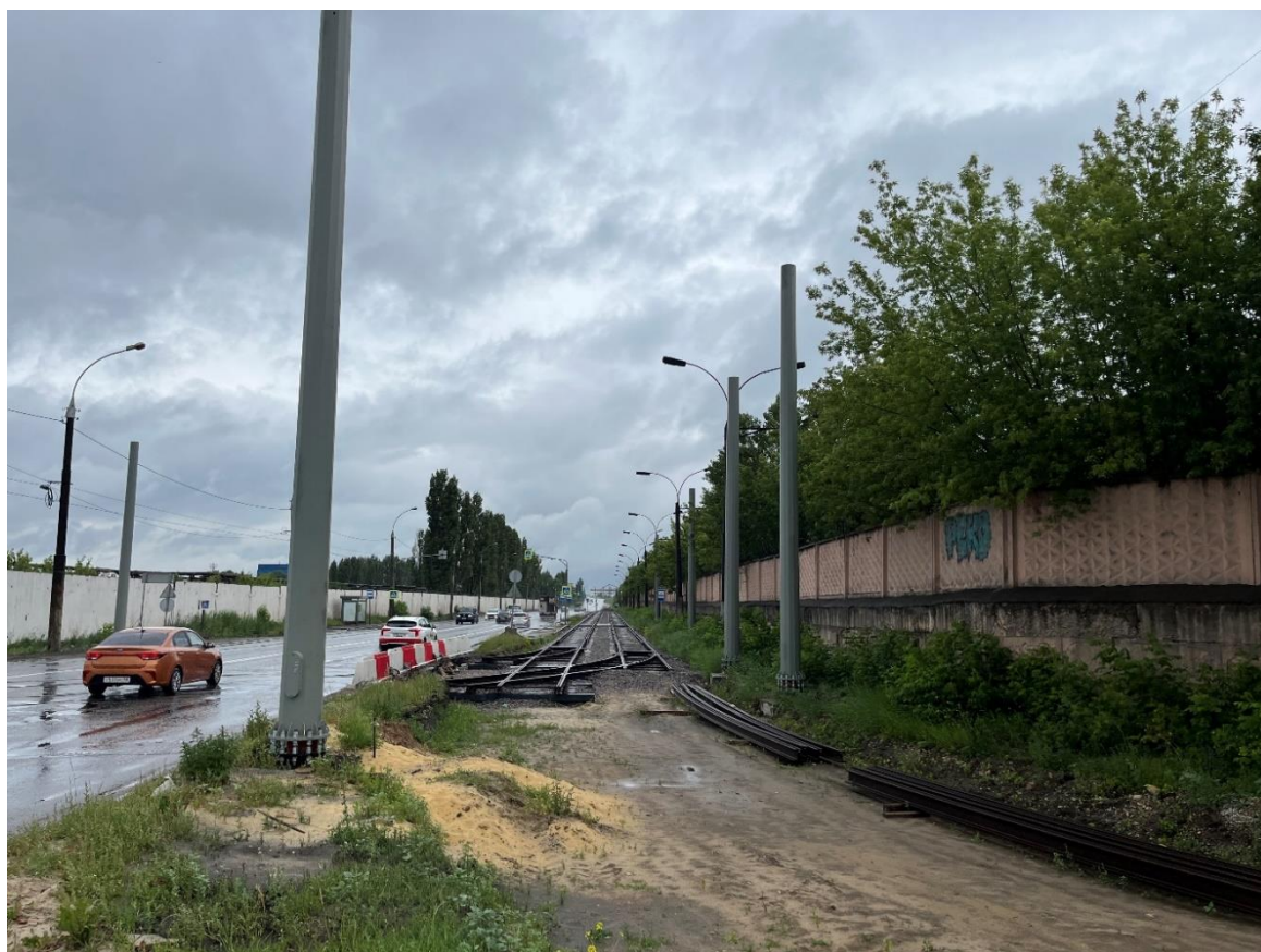
Рис. 41. Участок работ в районе пересечения ул. Краснозаводская с ул. Metallургов
