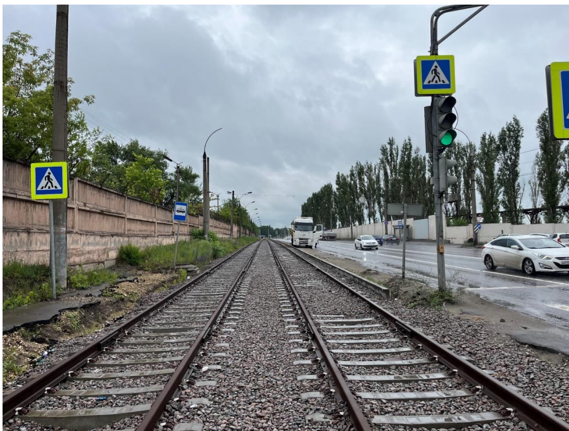
Рис. 84. Общий вид новой уложенной РШР по ул. Metallургов. Растяжки старой контактной сети демонтированы
