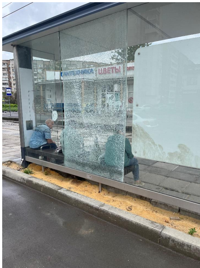
Рис. 55. Стекло́нные стенки остано́вочных па́вильонов «Октя́брьский рынок» в сетке трещин
