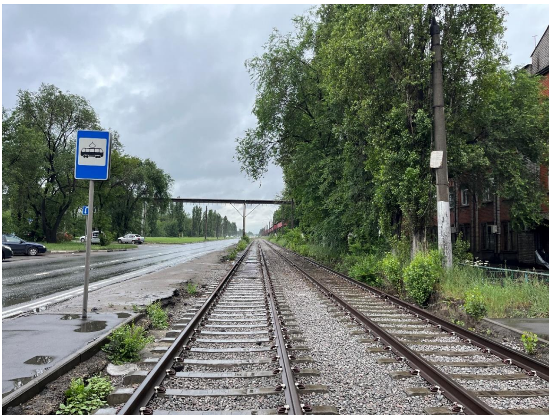
Рис. 87. Общий вид новой уложенной РШР по ул. Metallургов
