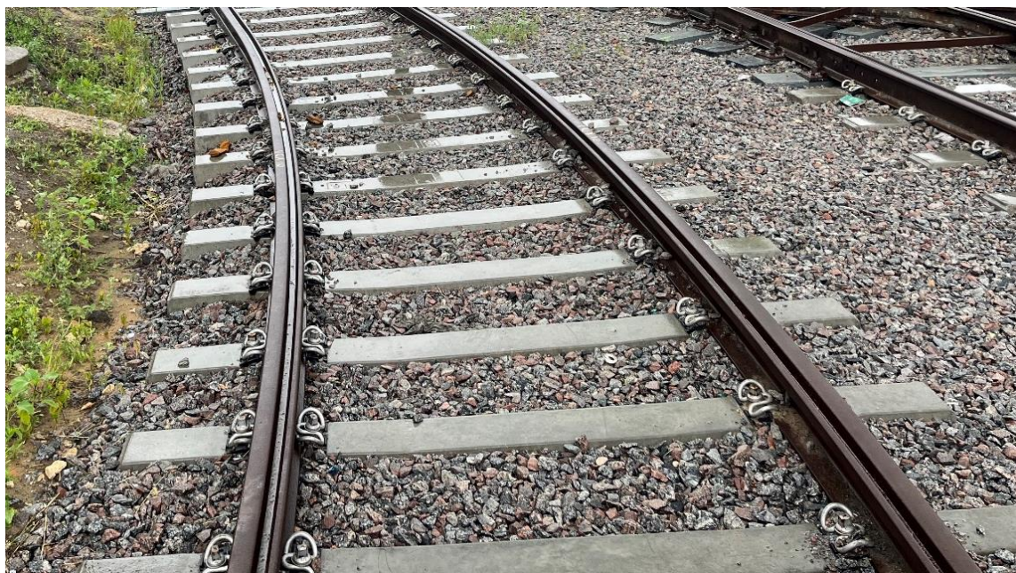
Рис. 25. Согласно мнению представителя эксплуатирующей организации, принимающего участие в Проверке, наиболее целесообразно избегать прямых вставок пути на кривых участках и привести в соответствие с ординатой оси разбивку трамвайного пути ул. 1-я Воронежская
