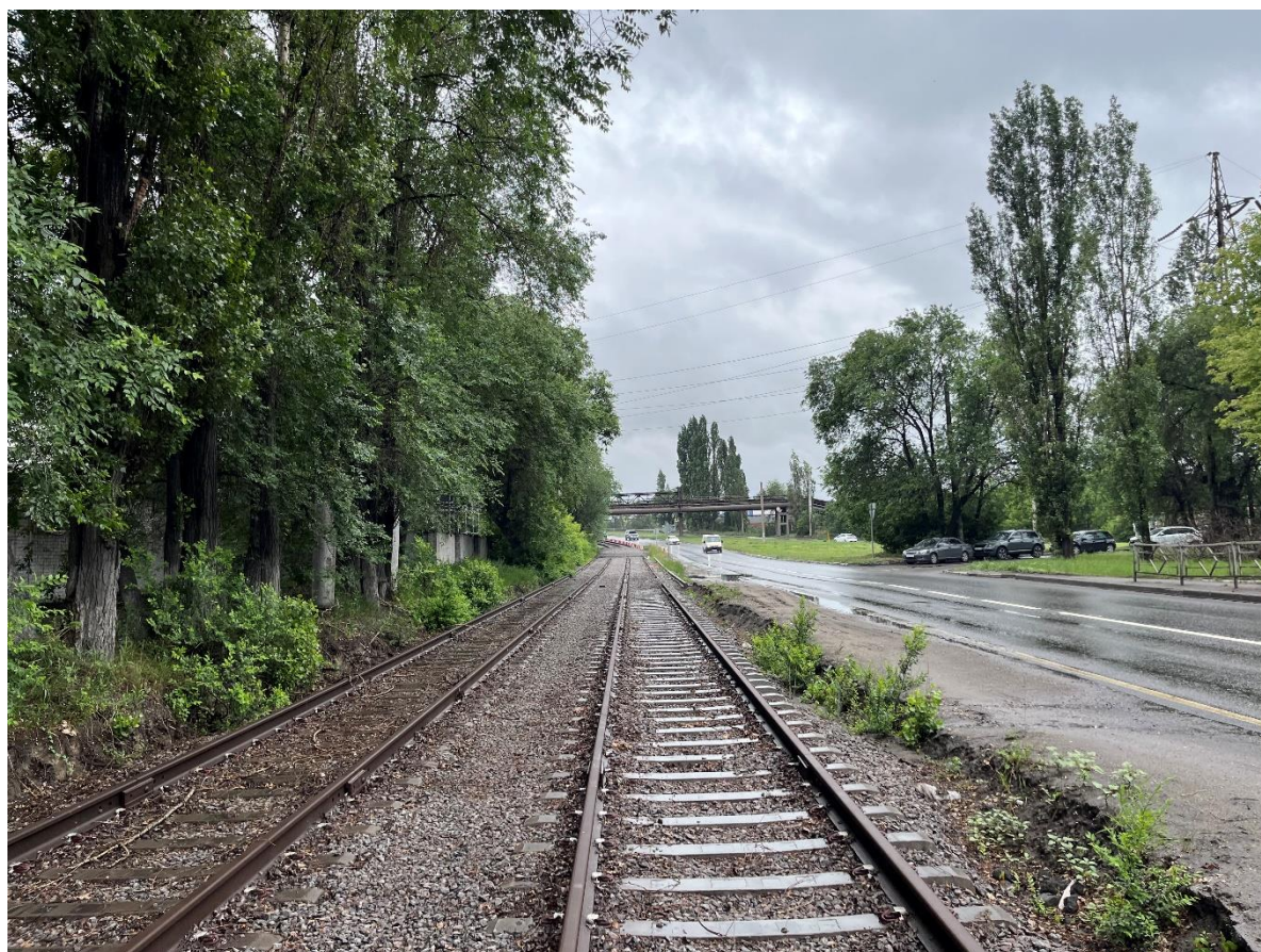
Рис. 86. Общий вид новой уложенной РШР по ул. Metallургов
