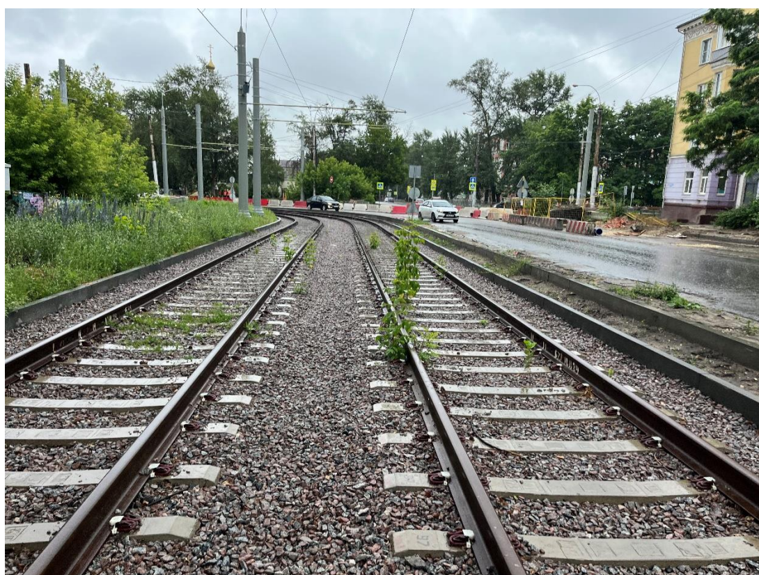
Рис. 33. Общий вид трамвайной инфраструктуры по ул. Краснозаводская
