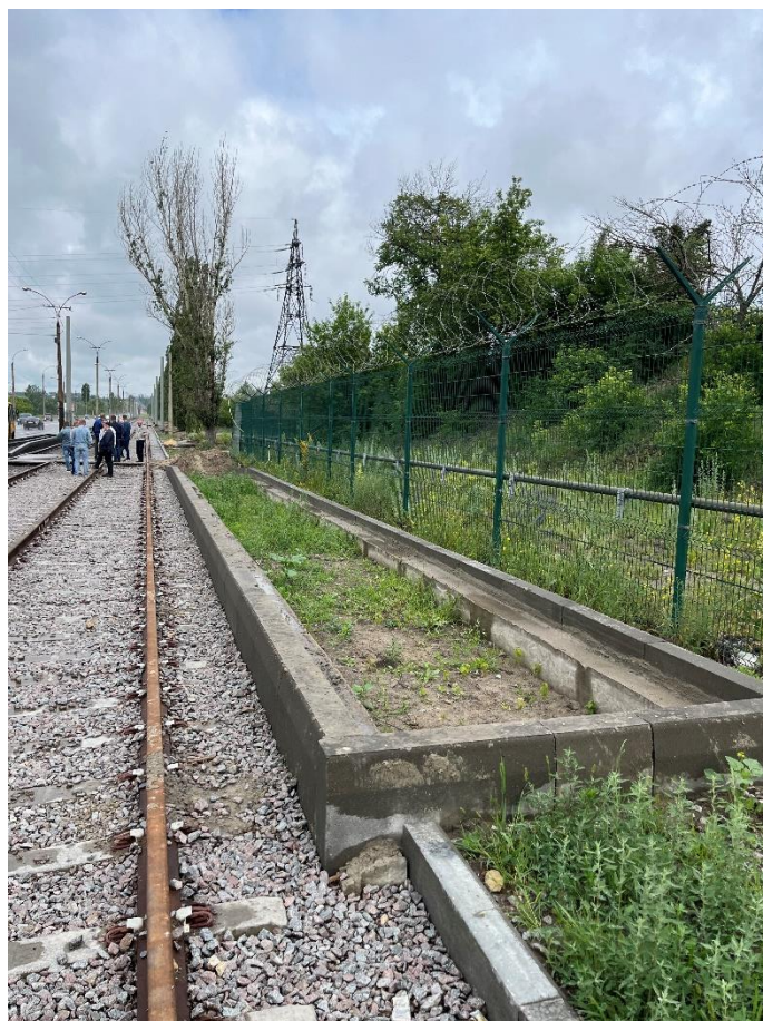
Рис. 97. Обустройство посадочной площадки на остановке «ул. Речная».
