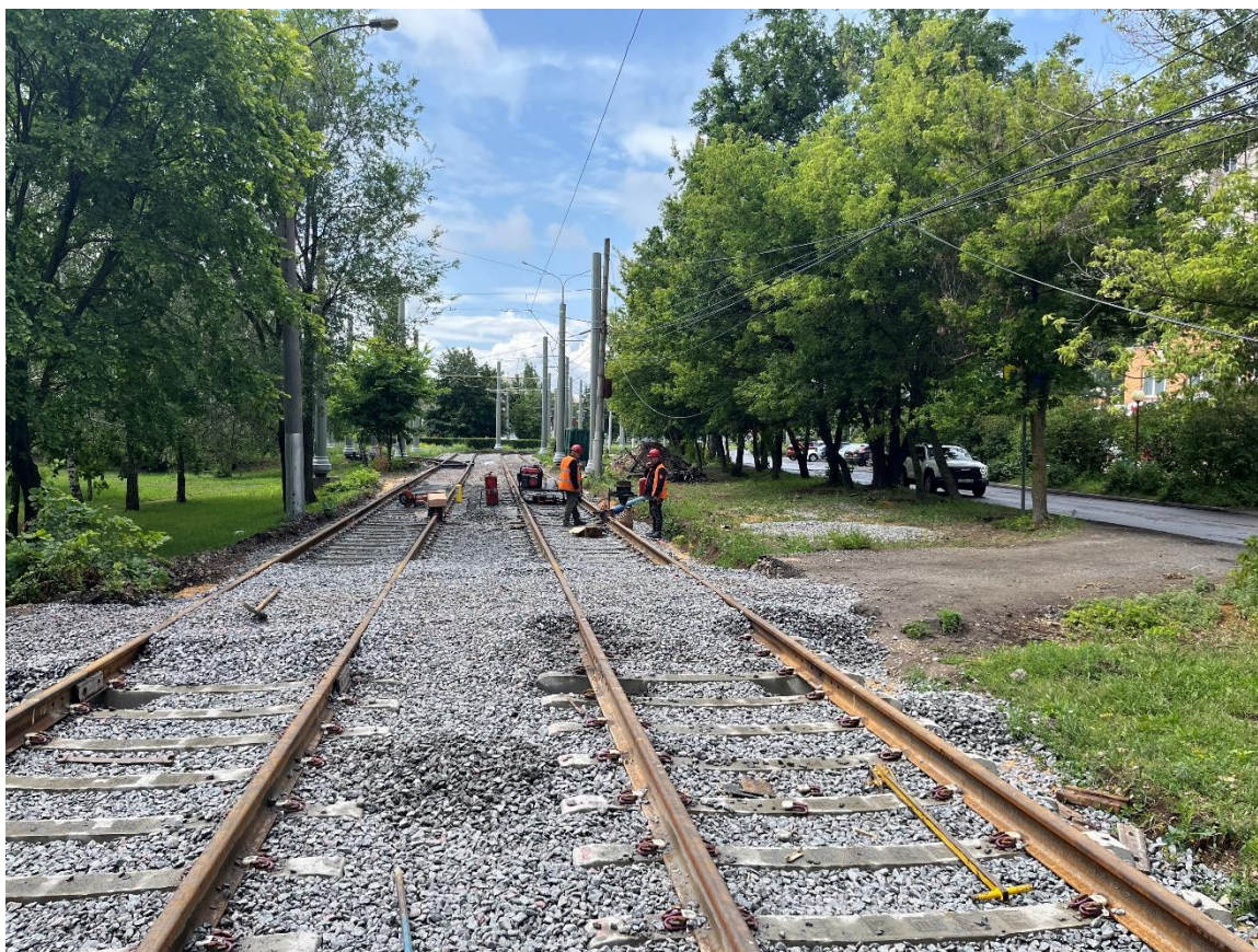
Рис. 105. Новая РШР при подходе к Проспекту Победы со стороны ул. Катукова
