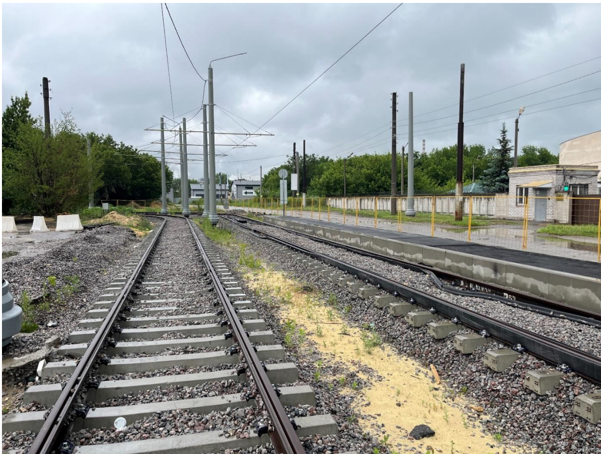
Рис. 18. Реконструкция трамвайных путей в районе ул. Чехова
