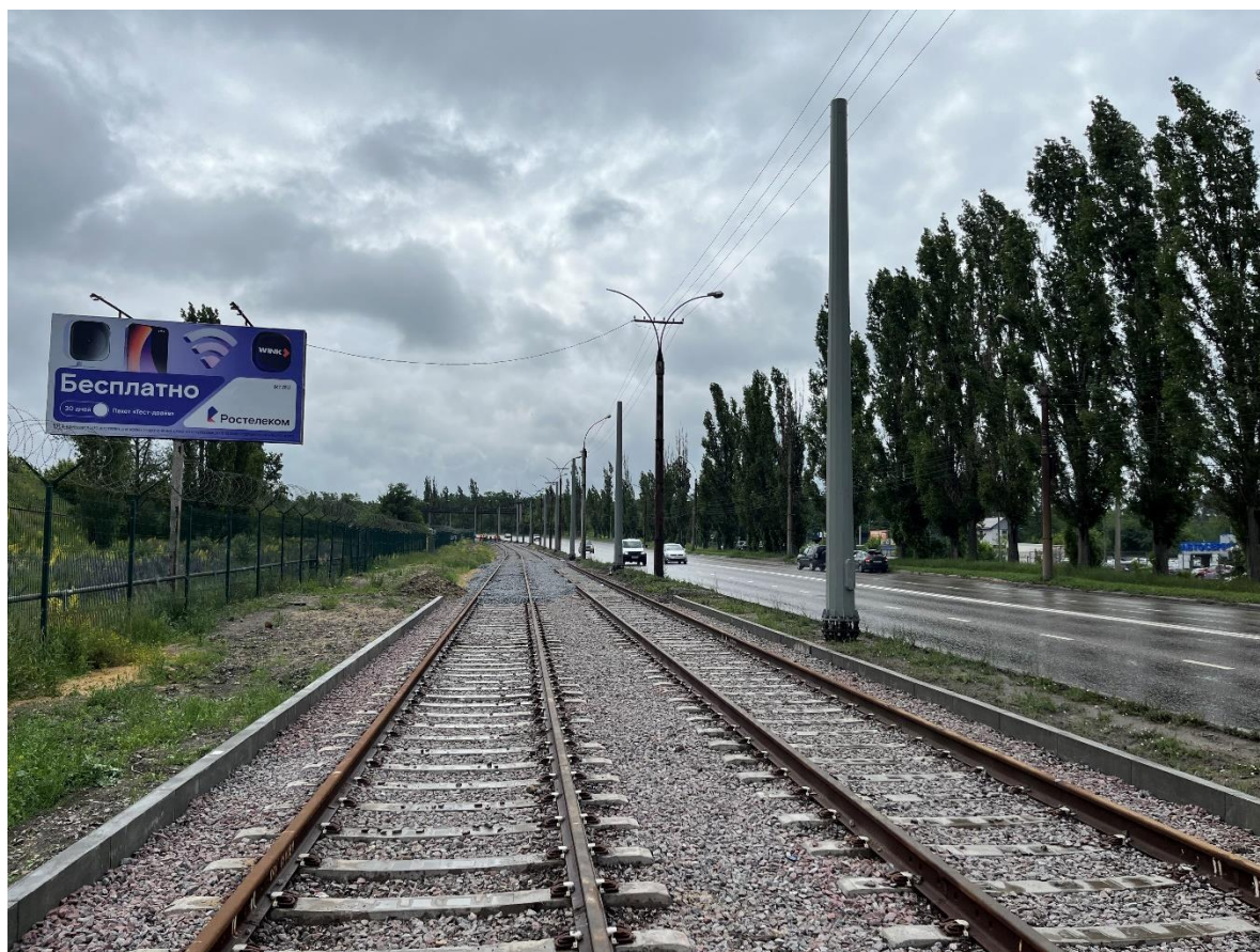
Рис. 96. Подходы к Октябрьскому мосту со стороны ЛТЗ
