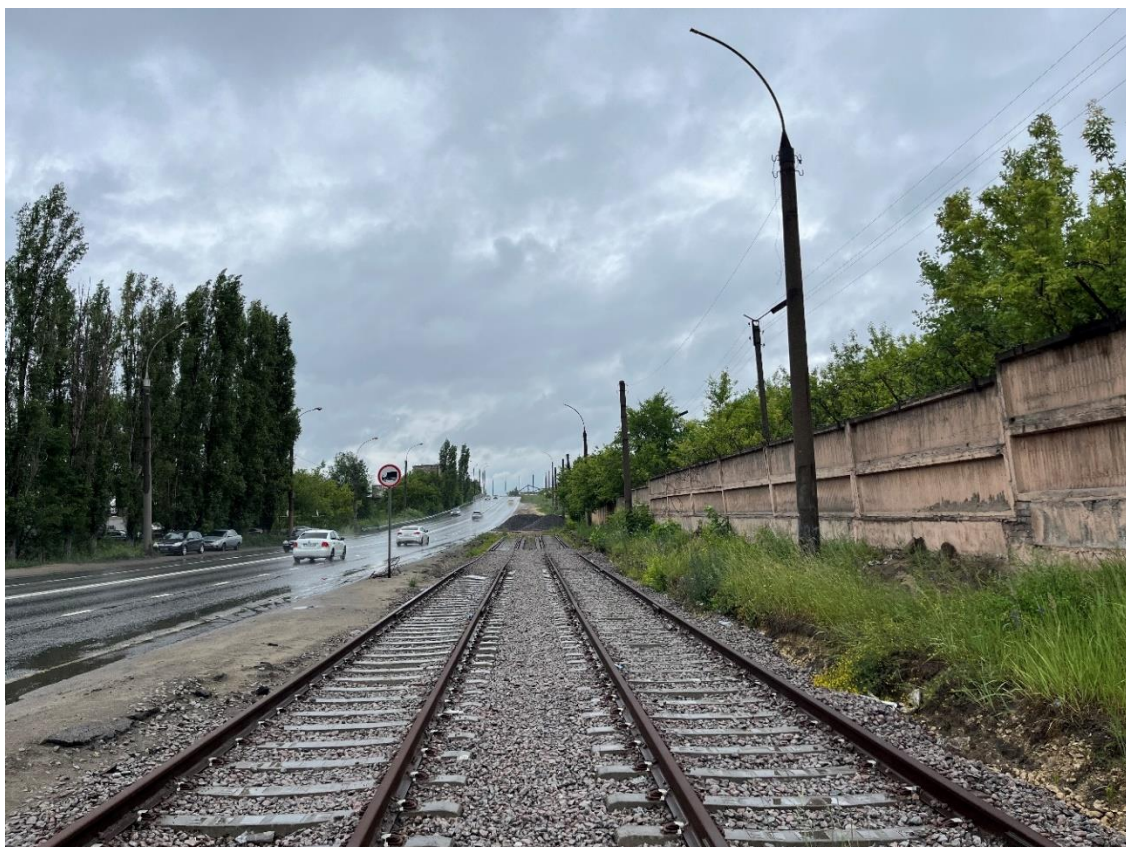
Рис. 85. Общий вид новой уложенной РШР по ул. Metallургов
