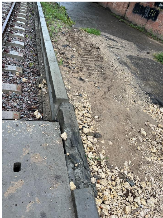
Рис. 31. Повреждение бортового камня посадочной площадки на остановочном пункте «Площадь Клименкова»
