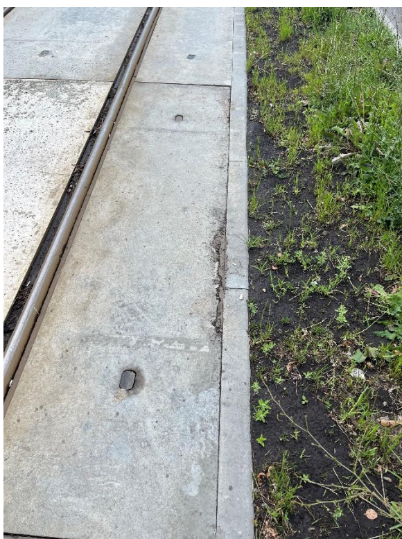
Рис. 62. Повреждение плит и бортовых камней, уложенных в районе остановочного пункта «Парк Победы»
