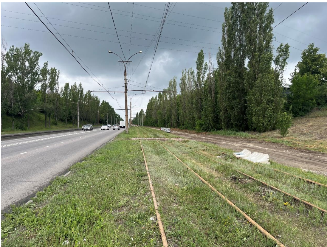
Рис. 101. Трамвайные пути в районе остановочного пункта «Мост».
