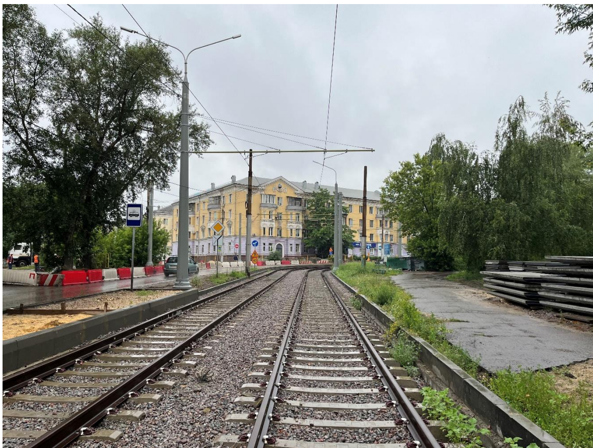
Рис. 32. Общий вид трамвайной инфраструктуры по ул. Краснозаводская
