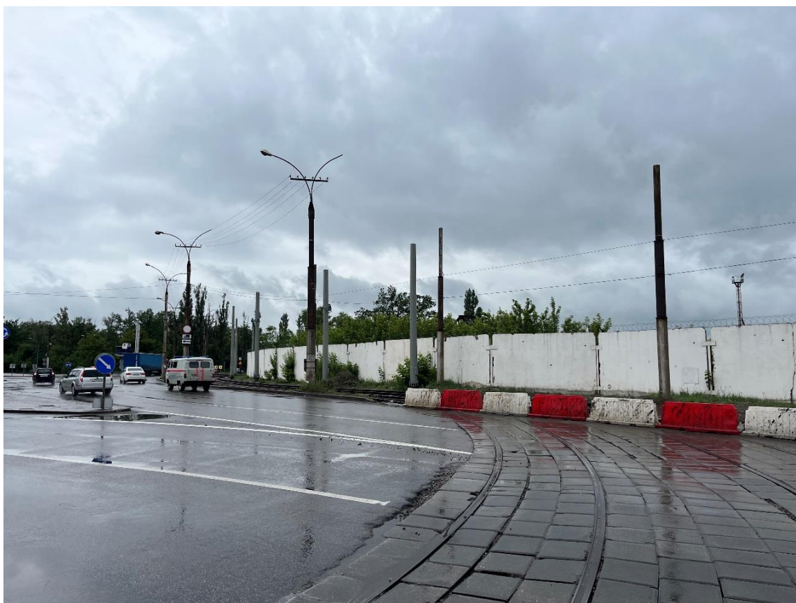
Рис. 42. Старые и новые опоры контактной сети в районе пересечения ул. Краснозаводская с ул. Metallургов
