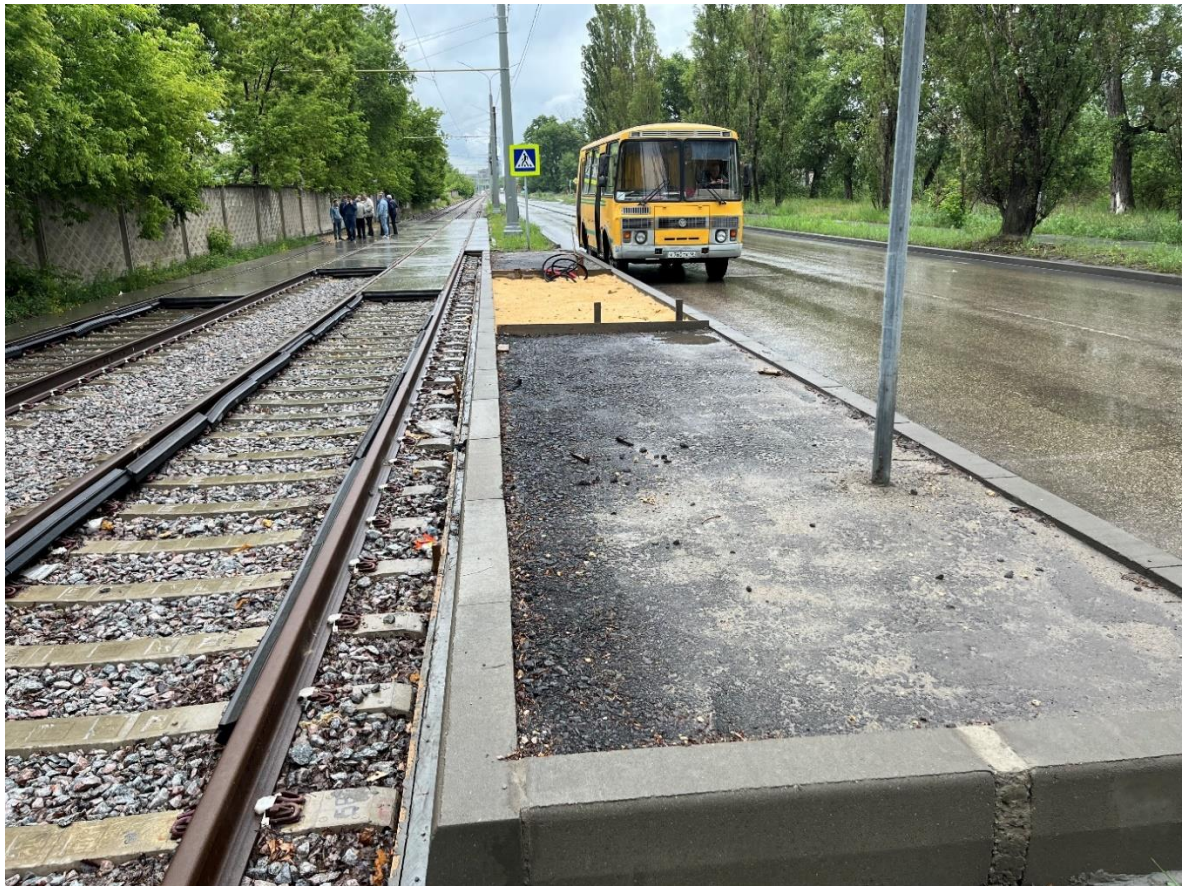
Рис. 28 Текущее состояние остановочного пункта «3-е Сентября»
