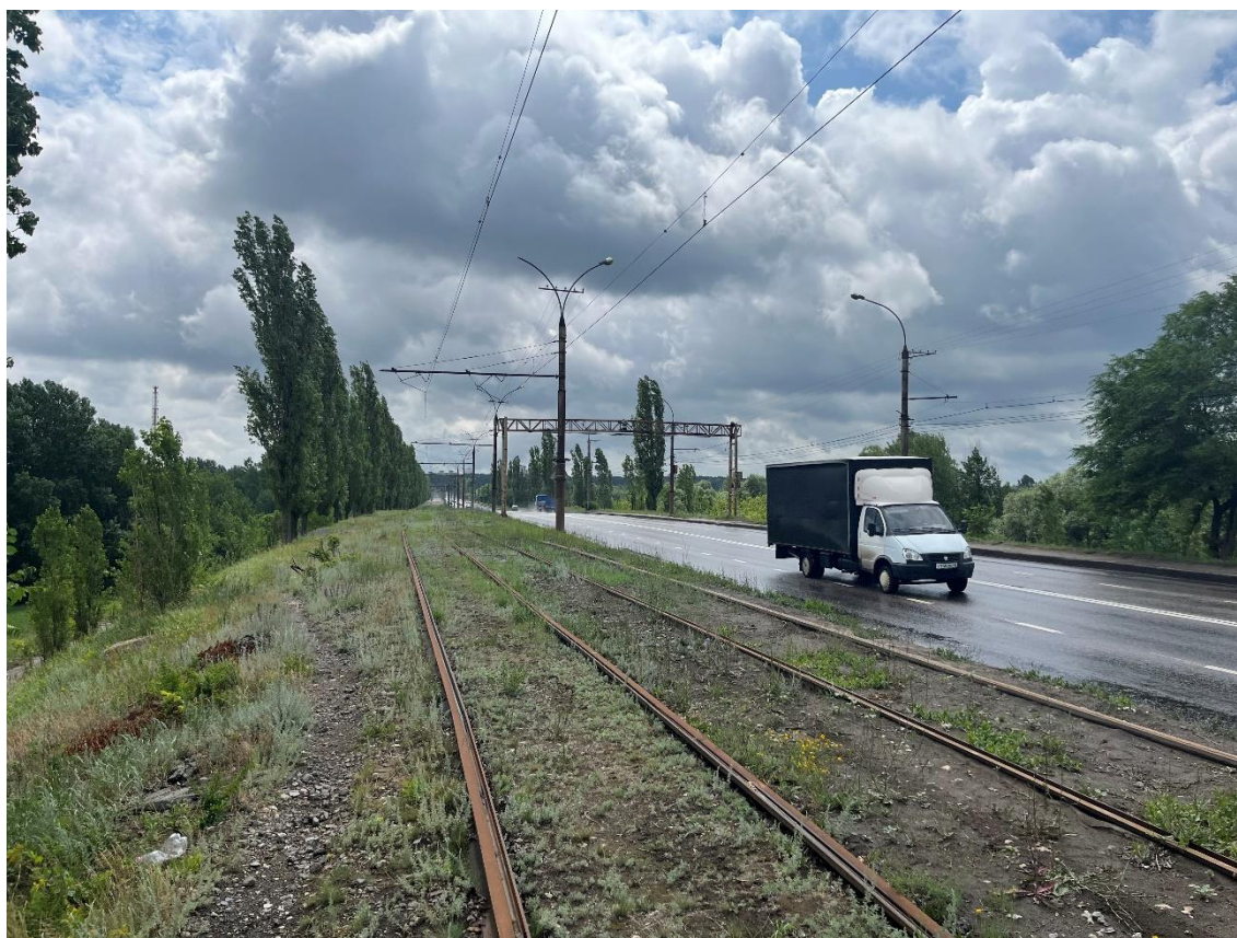
Рис. 100. Трамвайные пути на Октябрьском мосту.
