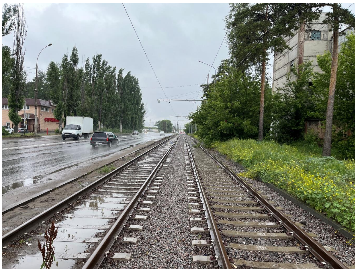
Рис. 37. Общий вид трамвайной инфраструктуры по ул. Краснозаводская
