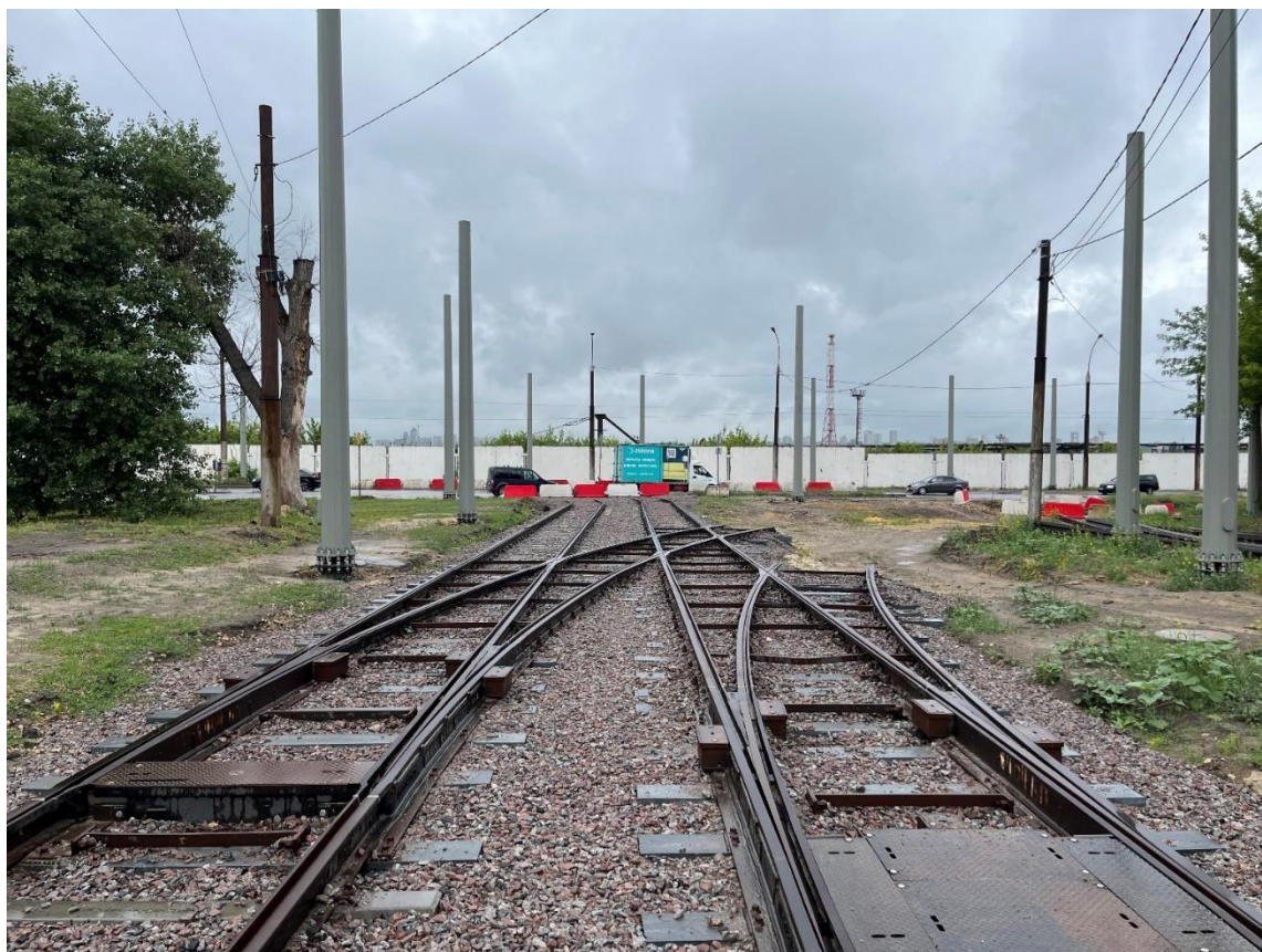
Рис. 40. Стрелочные переводы в районе пересечения ул. Краснозаводская с ул. Metallургов
