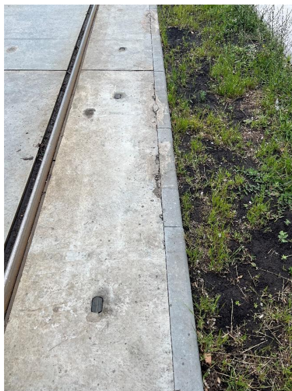
Рис. 62. Повреждение плит и бортовых камней, уложенных в районе остановочного пункта «Парк Победы»
