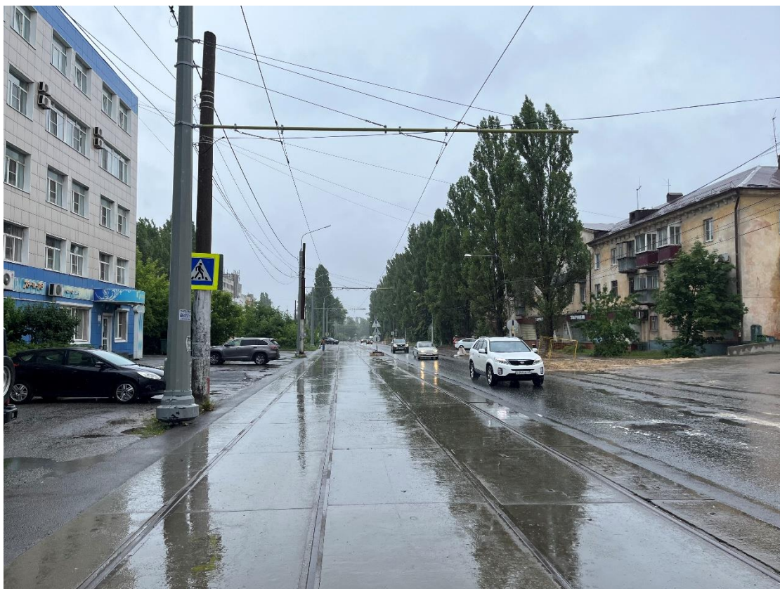
Рис. 34. Общий вид трамвайной инфраструктуры по ул. Краснозаводская
