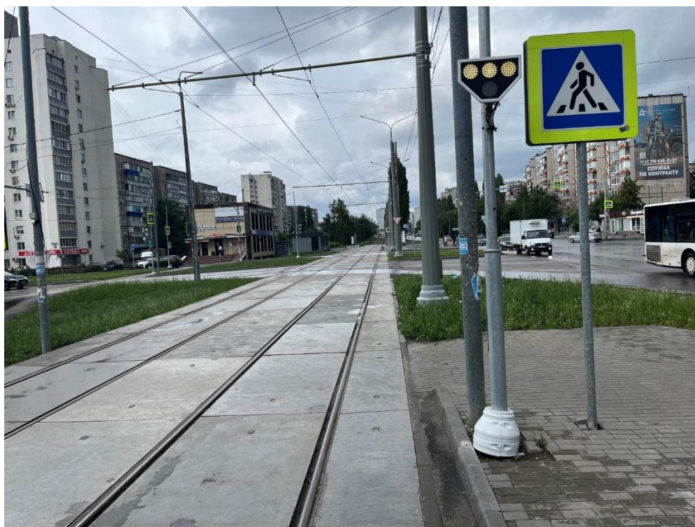
Рис. 59. Пересечение трамвайных путей ул. Стаханова
