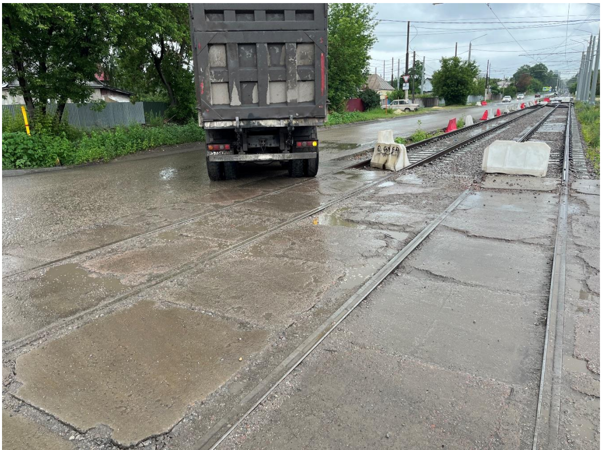
Рис. 21. Текущее состояние временного переезда в районе кольца ул. Чехова
