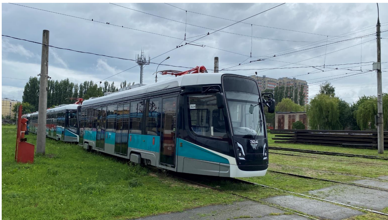
Рис. 15. Общий вид вагонов, размещённых на путевом веере трамвайного депо
