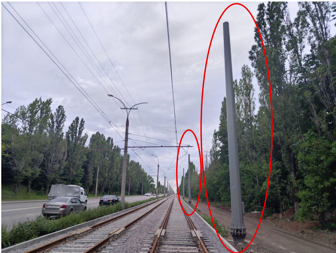
Рис. 94. Все опоры контактной сети ранее располагались со стороны проезжей части и только три опоры размещены Концессионером на противоположной стороне в опасной близости к канализационному коллектору ООО «РВК-Липецк».
