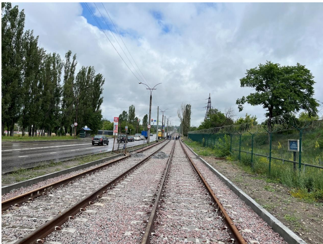
Рис. 95. Подходы к Октябрьскому мосту со стороны ЛТЗ
