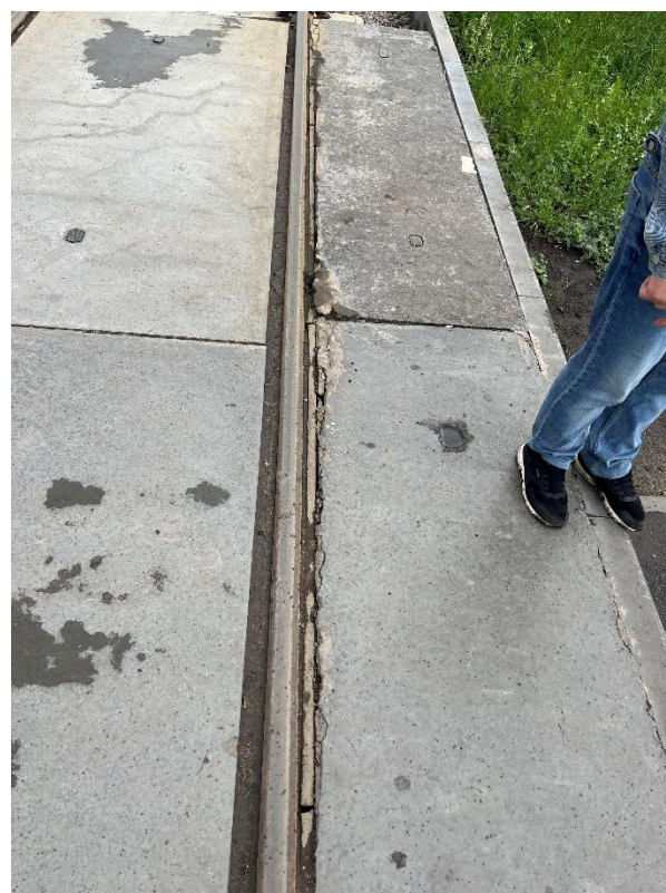
Рис.58. Повреждение плит, уложенных в районе остановочного пункта «Березовая Аллея»
