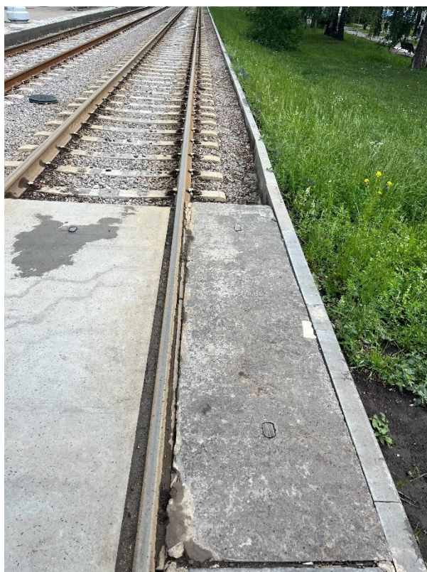
Рис.58. Повреждение плит, уложенных в районе остановочного пункта «Березовая Аллея»
