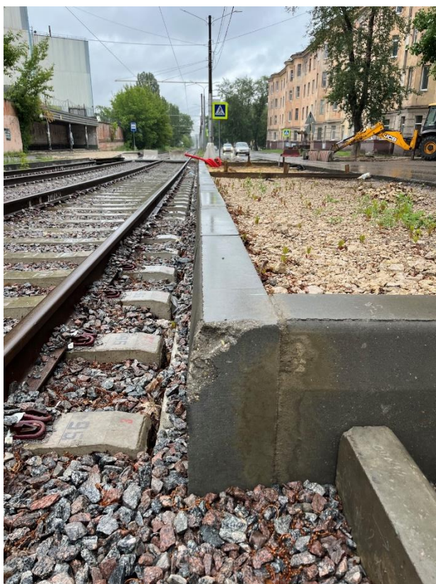
Рис. 31. Повреждение бортового камня посадочной площадки на остановочном пункте «Площадь Клименкова»
