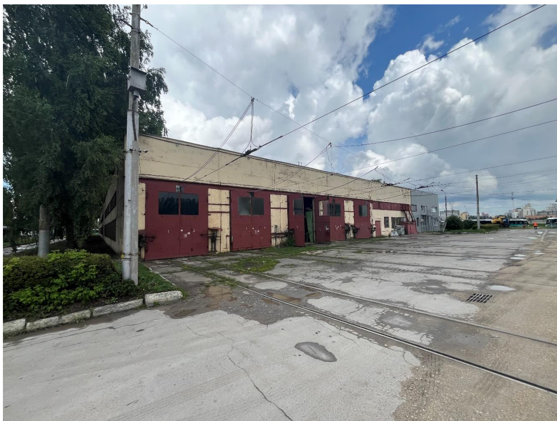
Рис. 107. Общий вид трамвайного депо на момент проведения Проверки.
