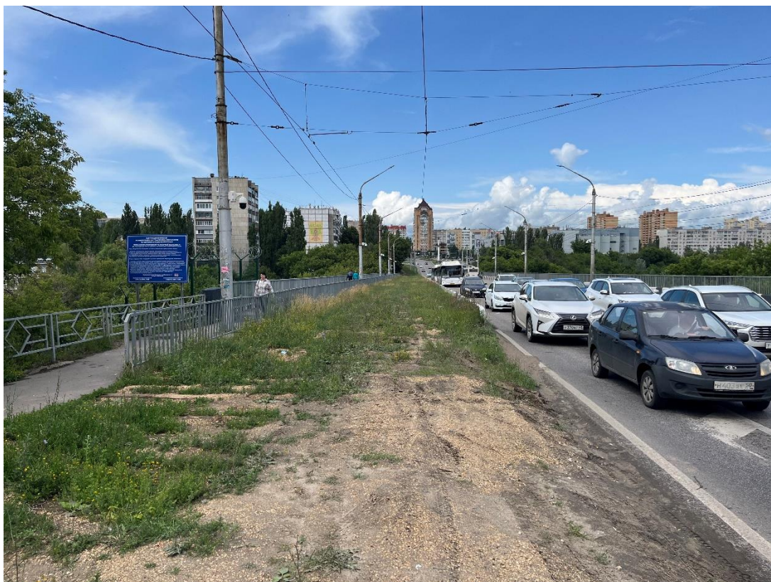
Рис. 80. Трамвайные пути на мосту по ул. Терешковой
