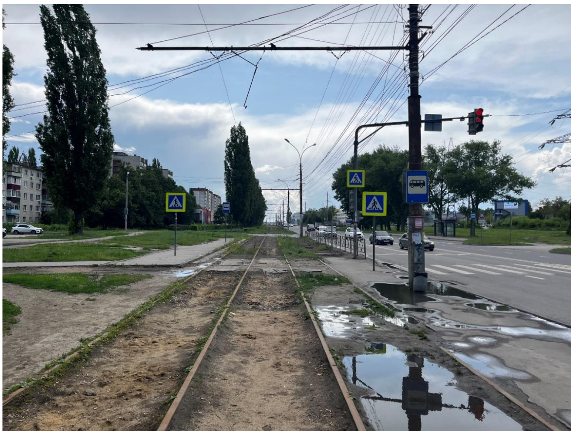
Рис. 74. Ул. Московская. Осуществлѐн демонтаж существующих путей за исключением переездов и подходов к ним
