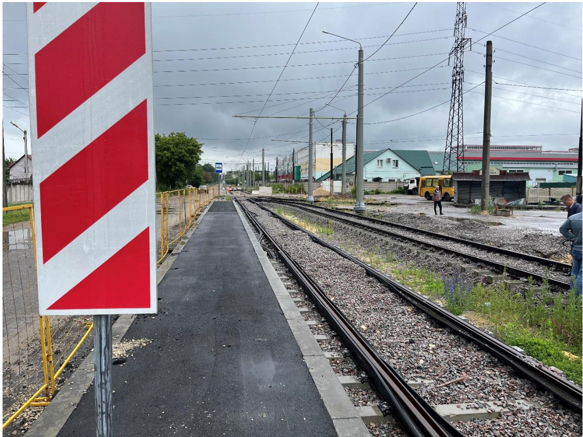
Рис. 20. Обустройство посадочной площадки в районе ул. Чехова
