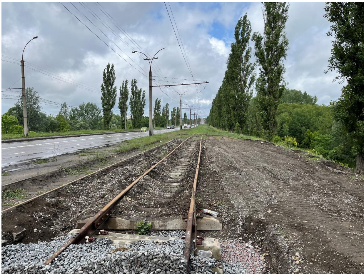
Рис. 99. Октябрьский мост примыкание нового участка РШР к старому участку
