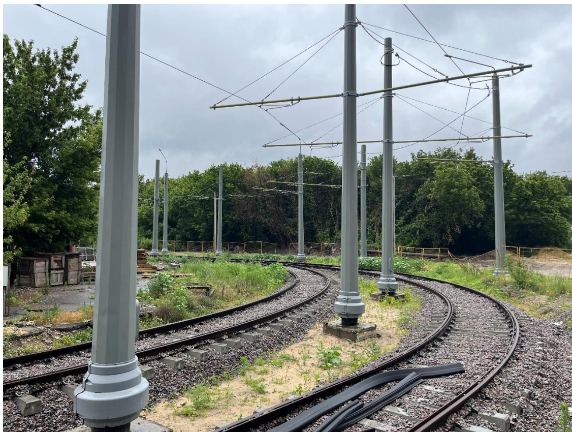
Рис. 19. Реконструкция трамвайных путей в районе ул. Чехова
