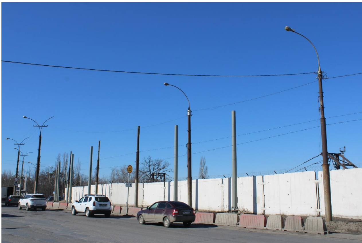
Рис. 44. Старые и новые опоры контактной сети в районе пересечения ул. Краснозаводская с ул. Metallургов
