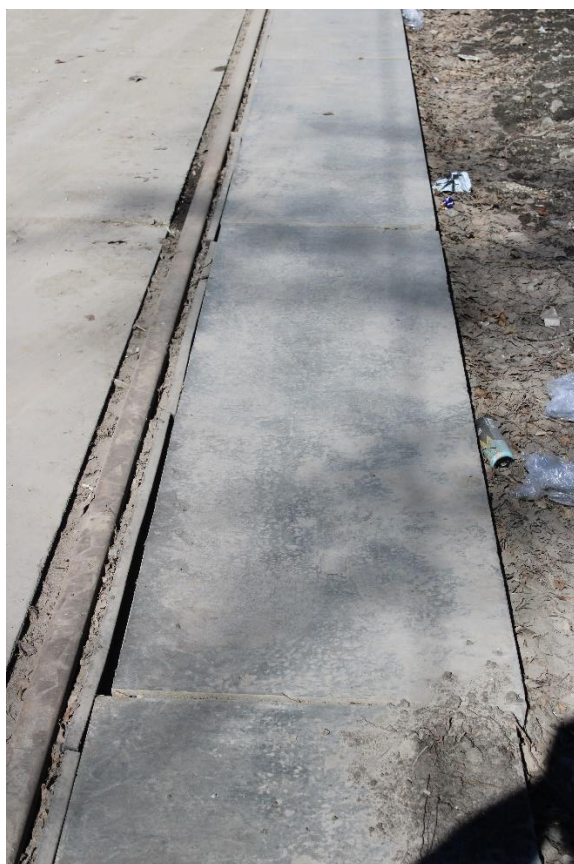
Рис. 35. При подготовке к запуску движения необходимо устранить засорение трамвайного пути и устранить смещение краевых плит по ул. Краснозаводская
