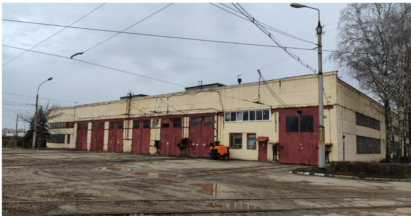
Рис. 105. Общий вид трамвайного депо на момент проведения Проверки.
