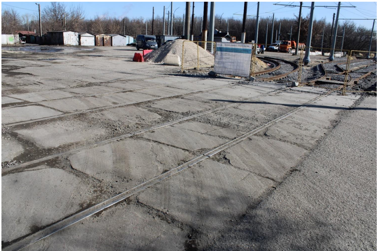
Рис. 20. Текущее состояние временного переезда в районе кольца ул. Чехова
