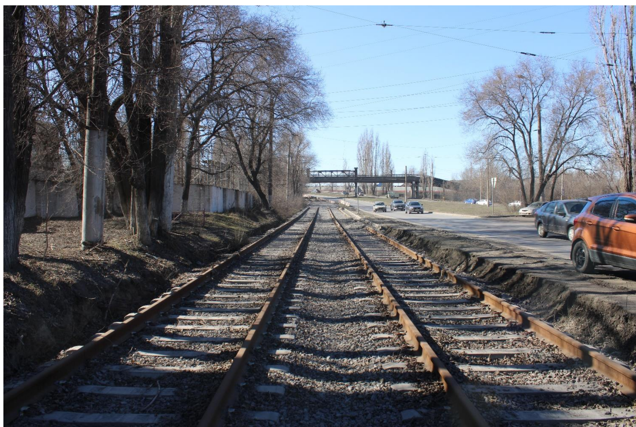
Рис. 89. Общий вид новой уложенной РШР по ул. Metallургов
