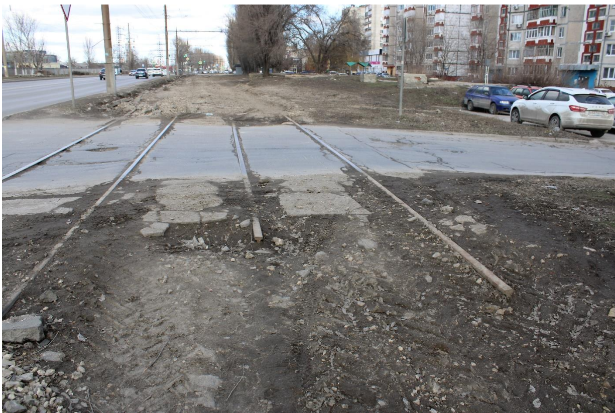
Рис. 76. Ул. Московская. Осуществлѐн демонтаж существующих путей за исключением переездов
