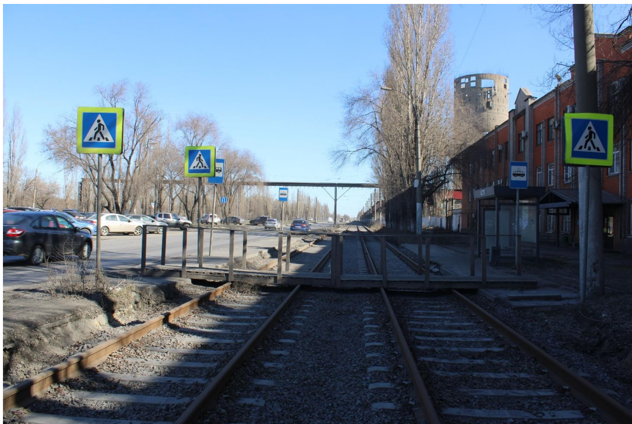
Рис. 90. Общий вид новой уложенной РШР по ул. Metallургов
