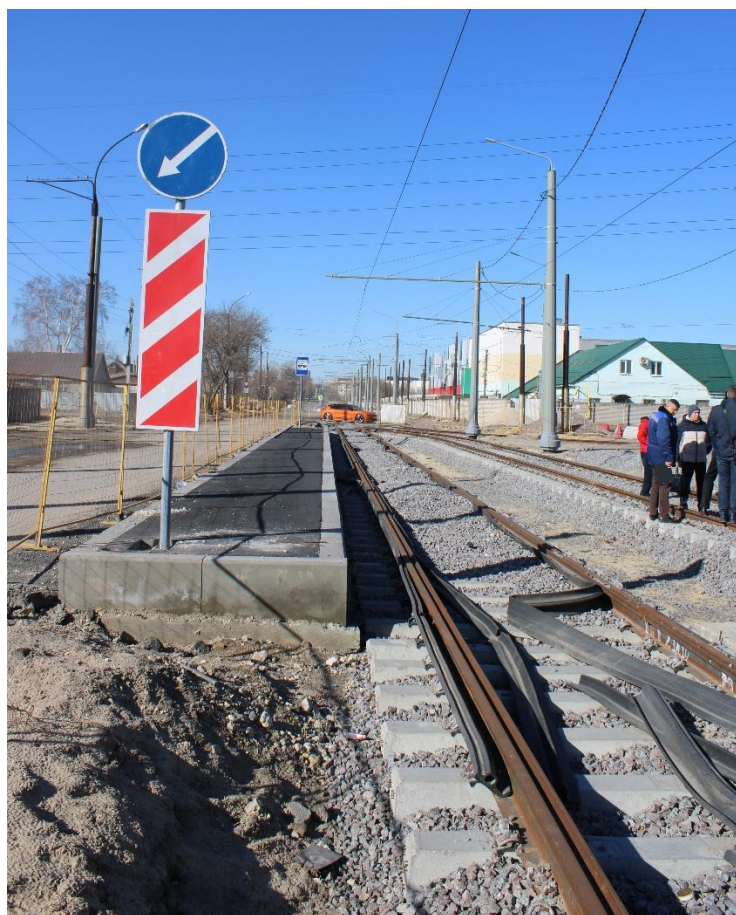
Рис. 19. Обустройство посадочной площадки в районе ул. Чехова
