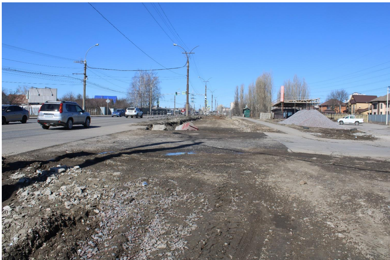
Рис. 104. Подходы к Октябрьскому мосту со стороны пр. Победы
