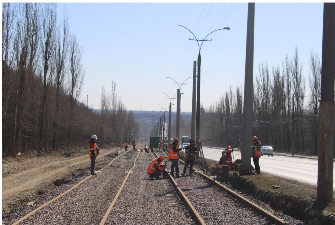
Рис. 101. Подходы к Октябрьскому мосту со стороны пр. Победы
