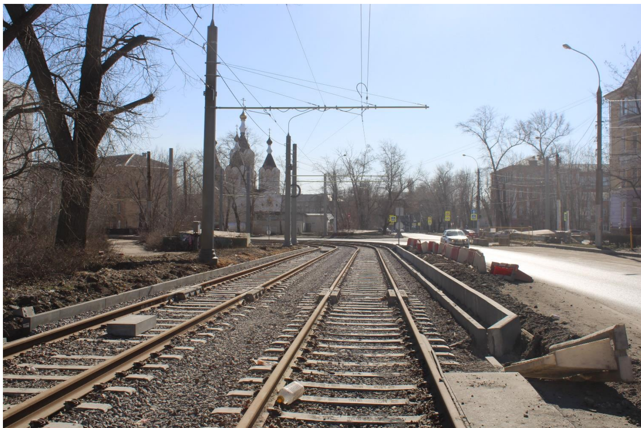
Рис. 32. Общий вид трамвайной инфраструктуры по ул. Краснозаводская
