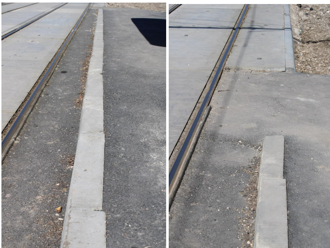
Рис. 69. Бортовые камни посадочной площадки на остановочном пункте «Улица Полиграфическая»
