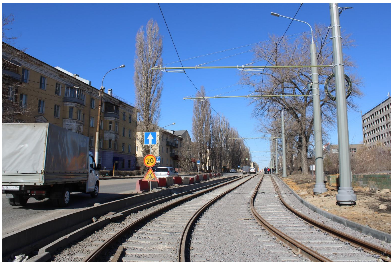
Рис. 33. Общий вид трамвайной инфраструктуры по ул. Краснозаводская
