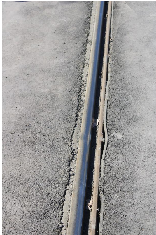
Рис. 51. Неплотное прилегание промежуточного уплотнения между рельсами и асфальтным покрытием остановочный пункт «21 микрорайон».
