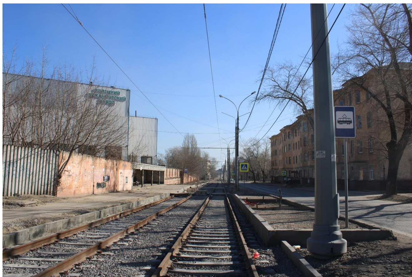
Рис. 31 Текущее состояние остановочного пункта «Площадь Клименкова»
