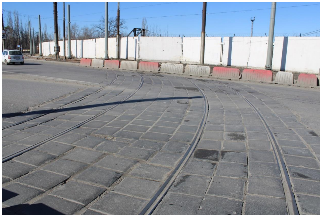
Рис. 41. Временный переезд в районе пересечения ул. Краснозаводская с ул. Metallургов
