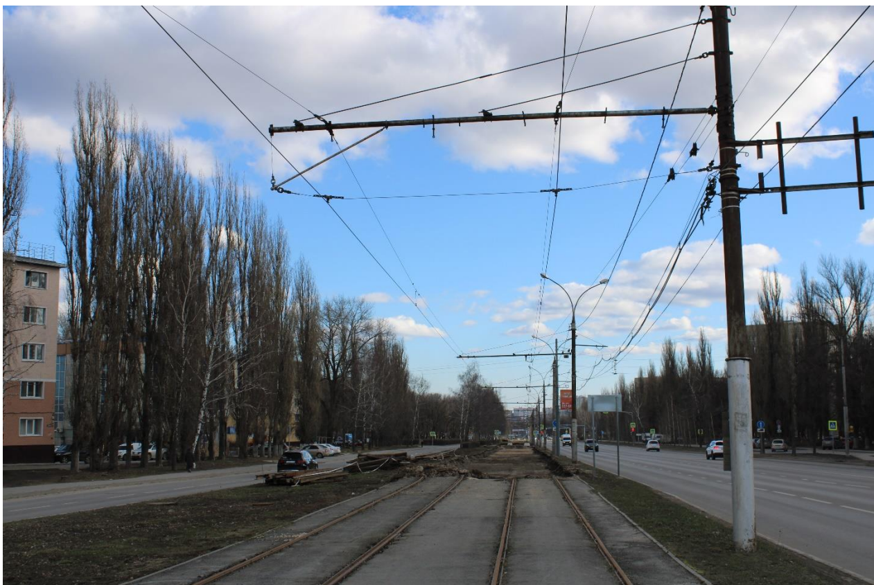
Рис. 80. Ул. Циолковского. Осуществлѐн демонтаж существующих путей за исключением переездов
