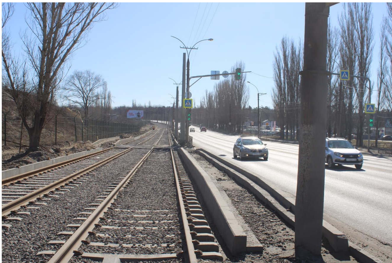
Рис. 98. Обустройство посадочной площадки на остановке «ул. Речная».
