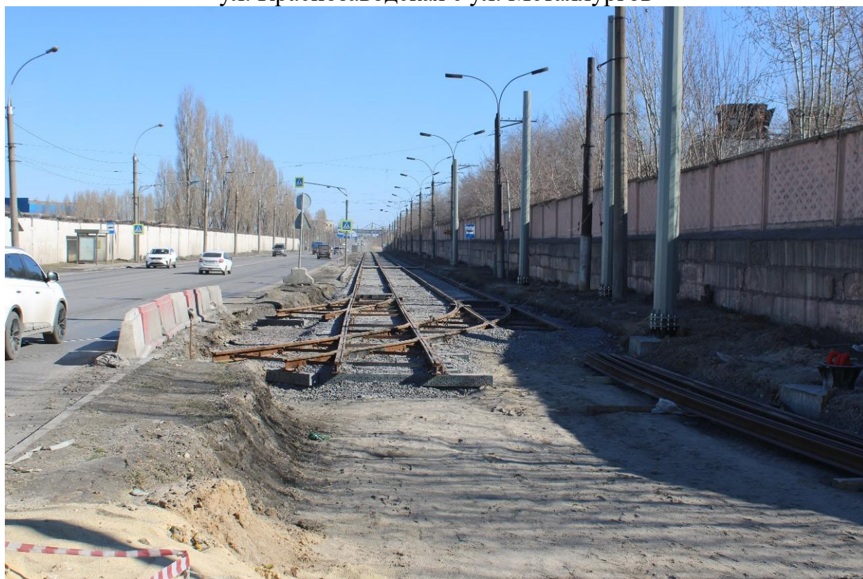
Рис. 43. Участок работ в районе пересечения ул. Краснозаводская с ул. Metallургов
