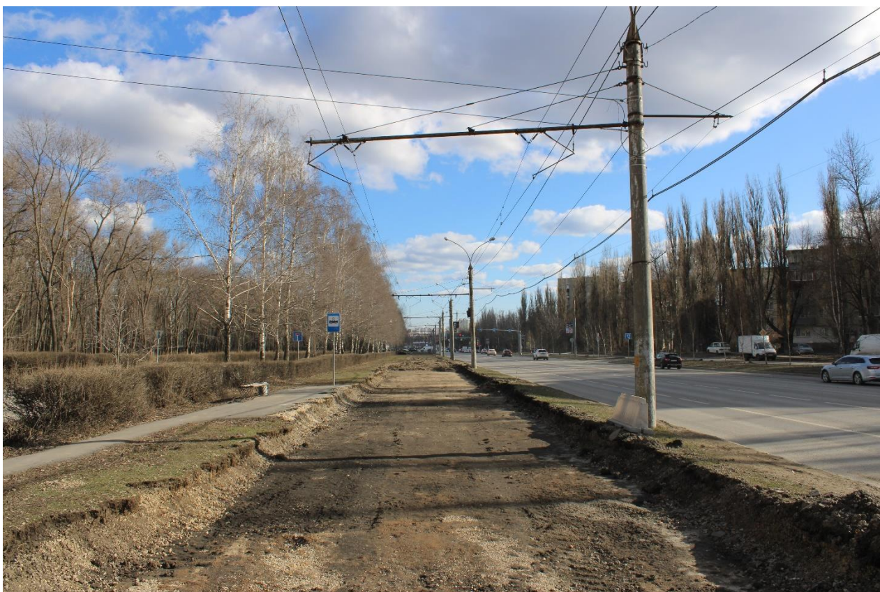
Рис. 81. Ул. Циолковского. Осуществлѐн демонтаж существующих путей за исключением переездов
