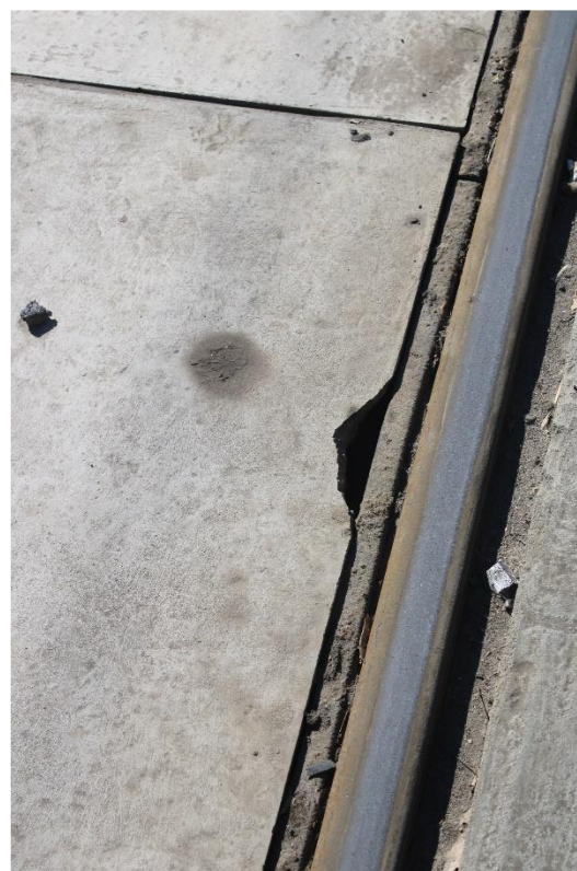
Рис. 53. Повреждение плит, уложенных на остановочном пункте «Улица Катукова»
