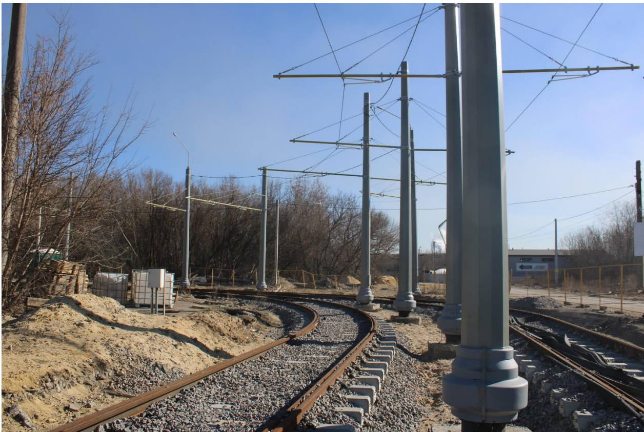
Рис. 18. Реконструкция трамвайных путей в районе ул. Чехова
