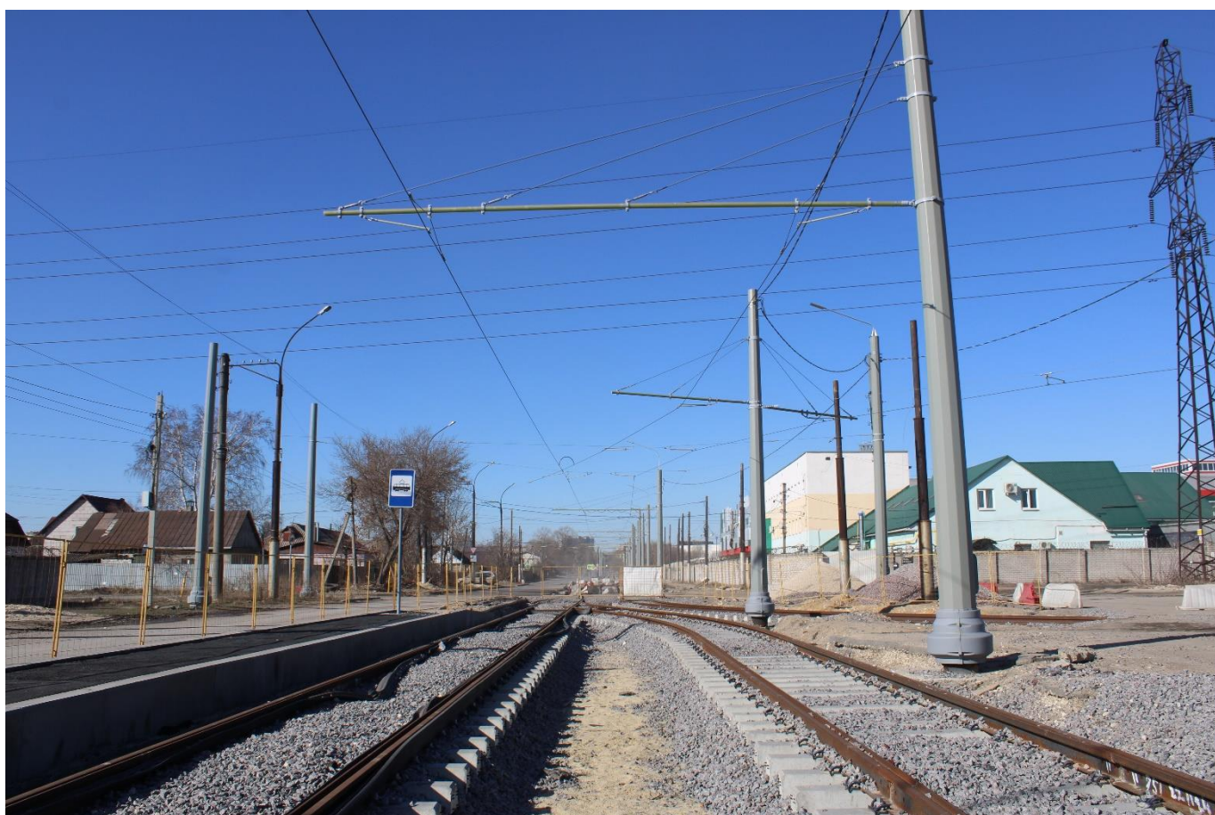
Рис. 17. Реконструкция трамвайных путей в районе ул. Чехова
