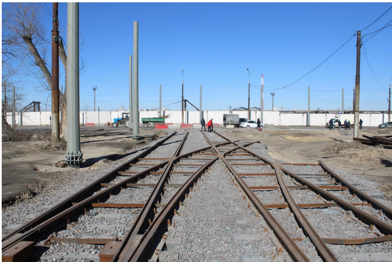
Рис. 42. Стрелочные переводы в районе пересечения ул. Краснозаводская с ул. Metallургов
