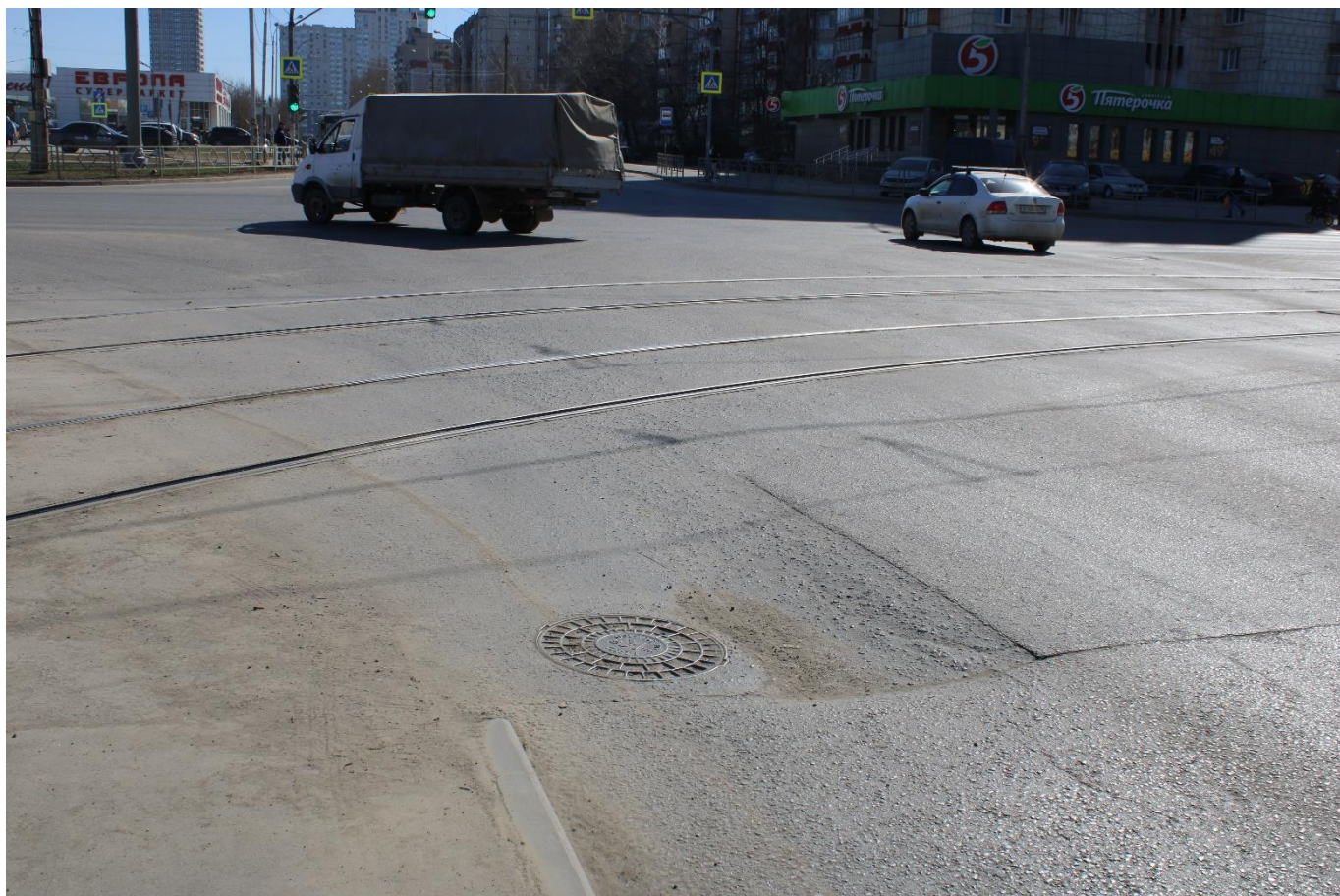
Рис. 54. Просадка канализационного люка, обустроенного подрядчиком Концессионера на пересечении пр. 60 лет СССР и ул. Меркулова
