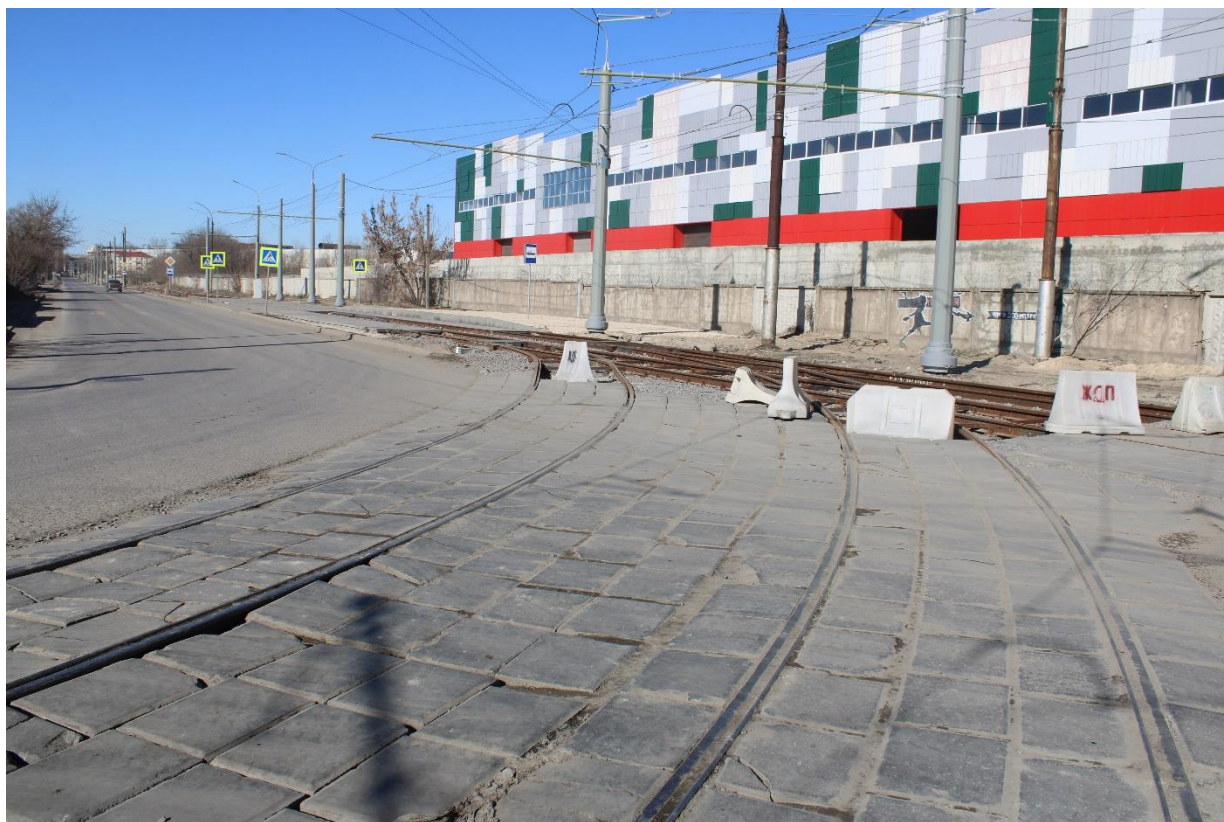
Рис. 23. Текущее состояние временного переезда по ул. 3 Сентября
