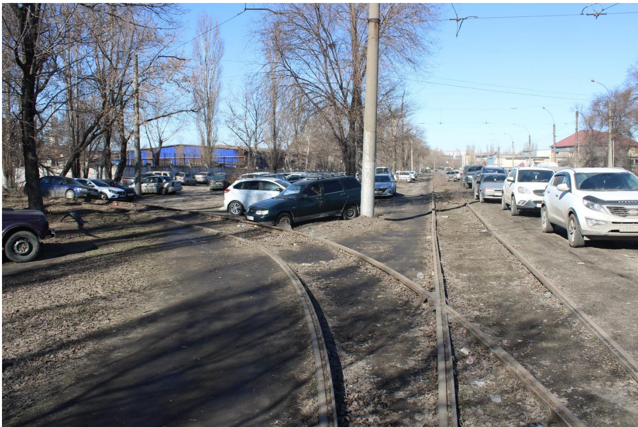
Рис. 94. Разворотный круг по ул. 9 Мая. Демонтажные работы на момент проведения Проверки не начаты.
