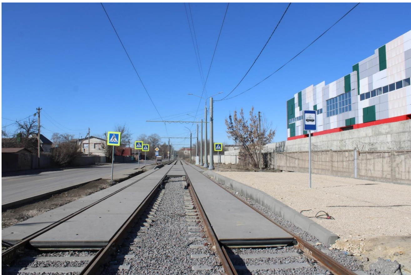
Рис. 26 Текущее состояние остановочного пункта «РСУ»
