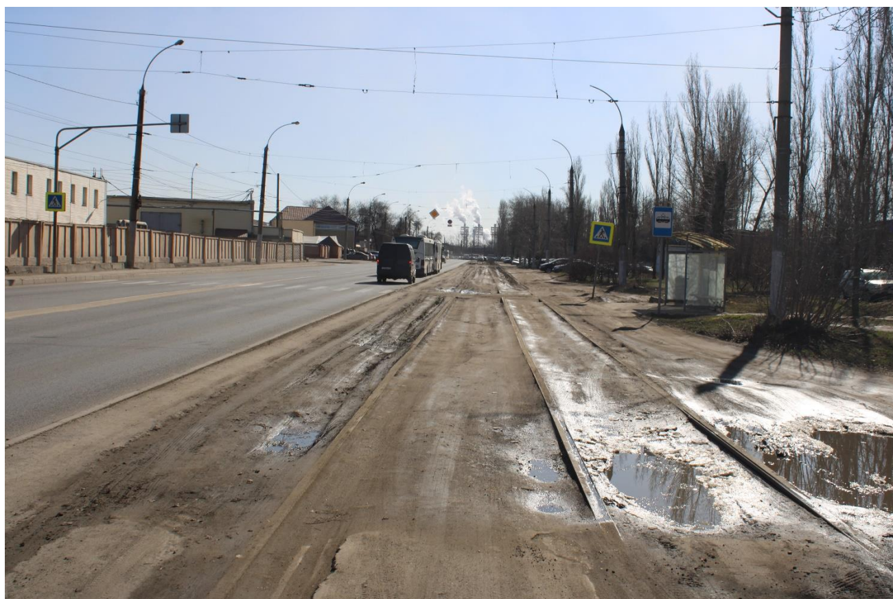
Рис. 93. Ул. 9 Мая. Демонтажные работы на момент проведения Проверки не начаты.
