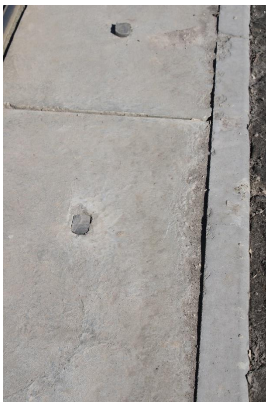
Рис. 53. Повреждение плит, уложенных на остановочном пункте «Улица Катукова»
