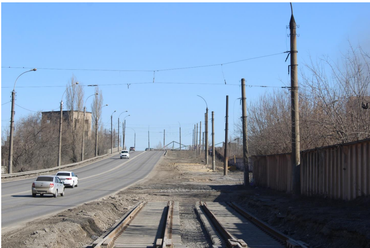
Рис. 88. Общий вид новой уложенной РШР по ул. Metallургов
