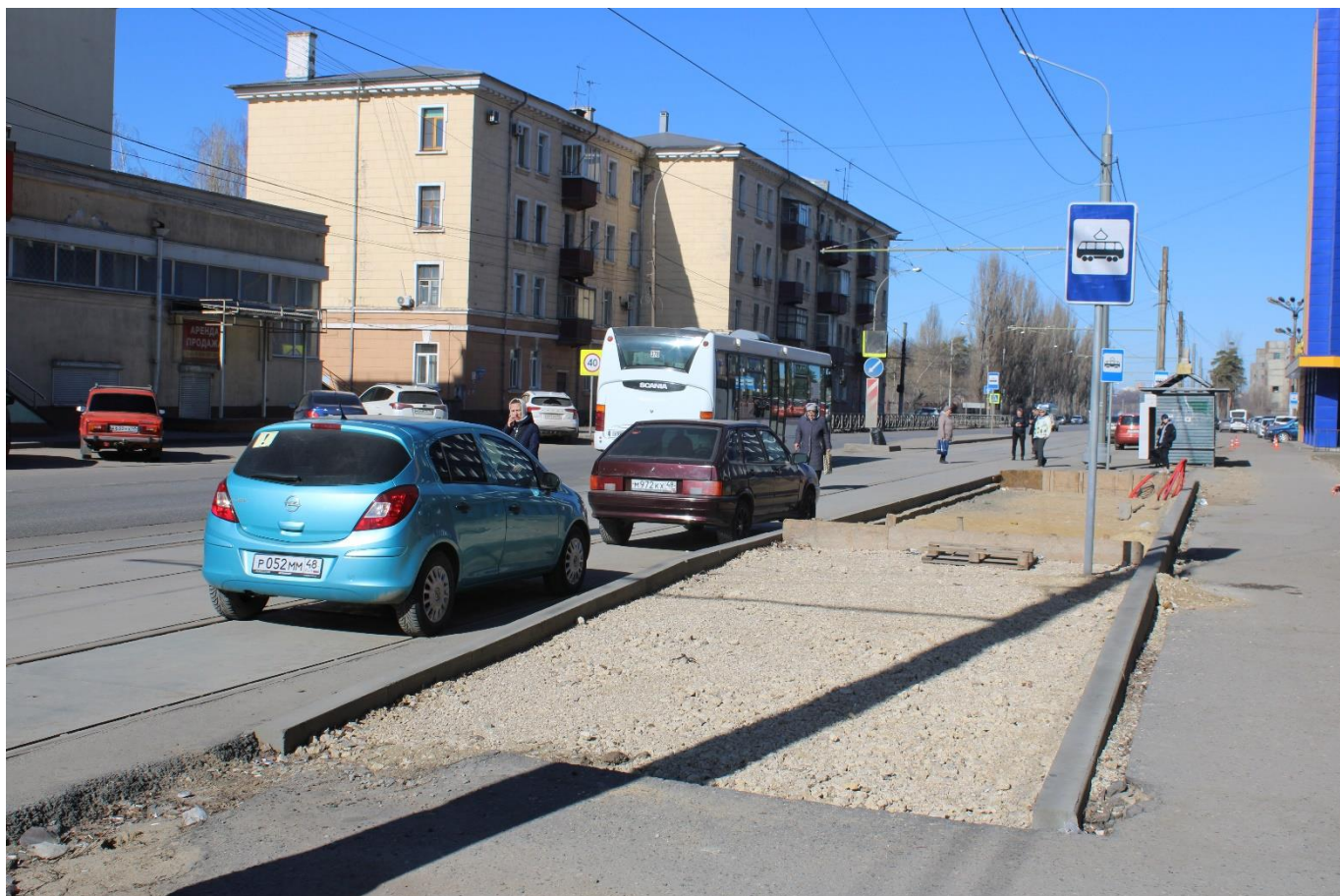
Рис. 36 Текущее состояние остановочного пункта «ЛТЗ»
