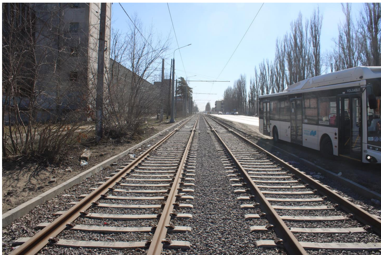
Рис. 37. Общий вид трамвайной инфраструктуры по ул. Краснозаводская
