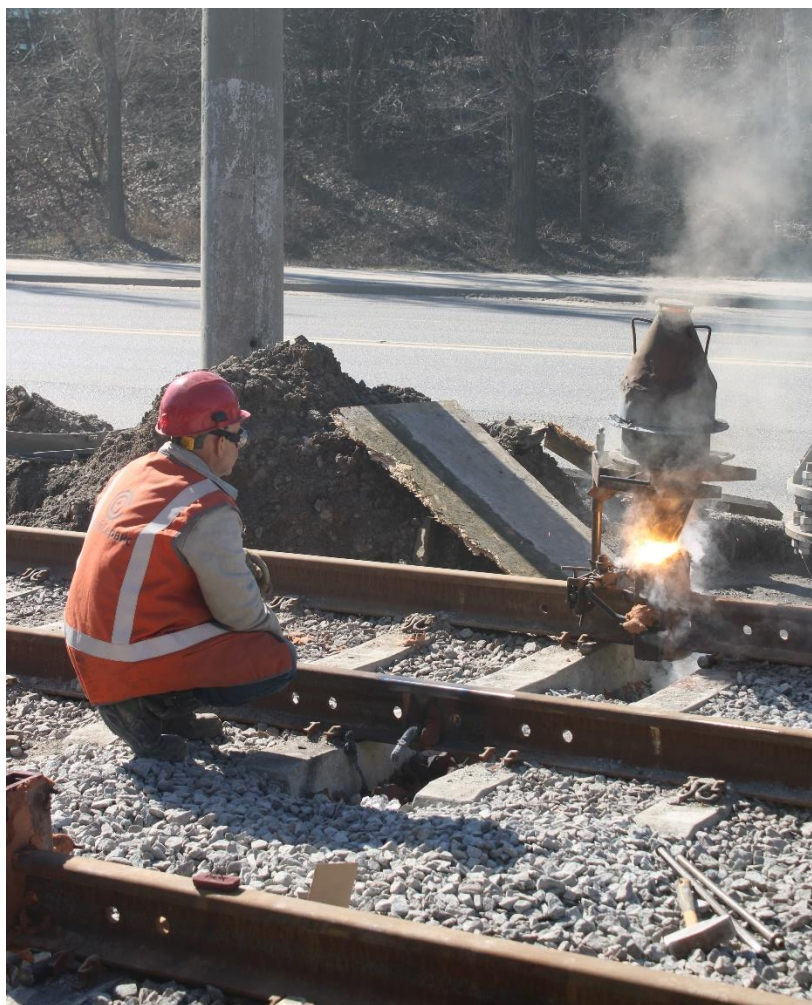
Рис. 102. Сварка стыков на подходах к Октябрьскому мосту со стороны пр. Победы
