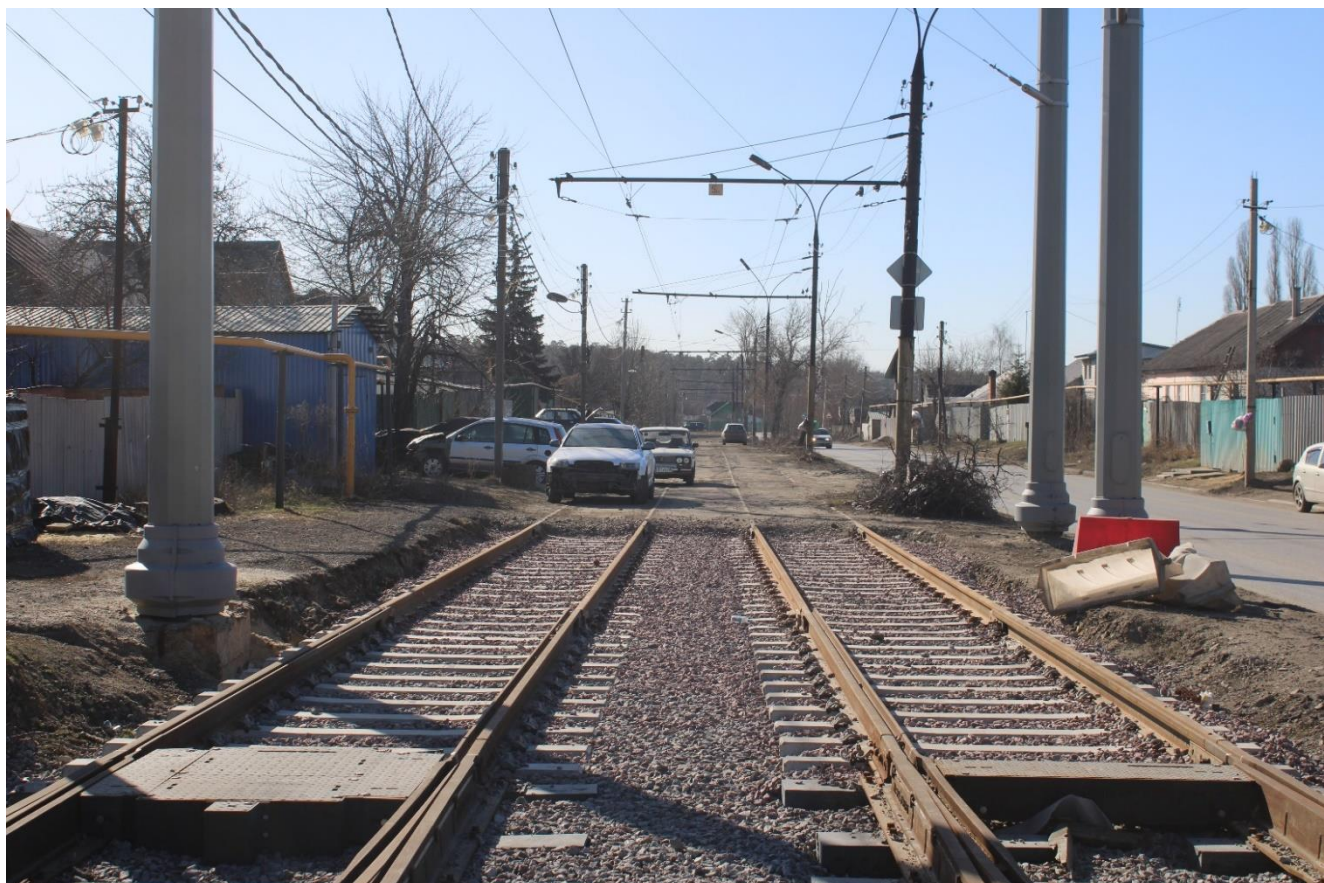
Рис. 22. Реконструкция трамвайных путей по ул. 1-я Воронежская. Выполнено сопряжение с существующими путями
