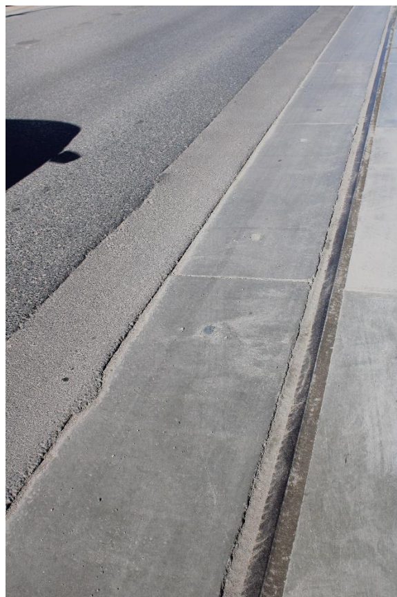
Рис. 35. При подготовке к запуску движения необходимо устранить засорение трамвайного пути и устранить смещение краевых плит по ул. Краснозаводская
