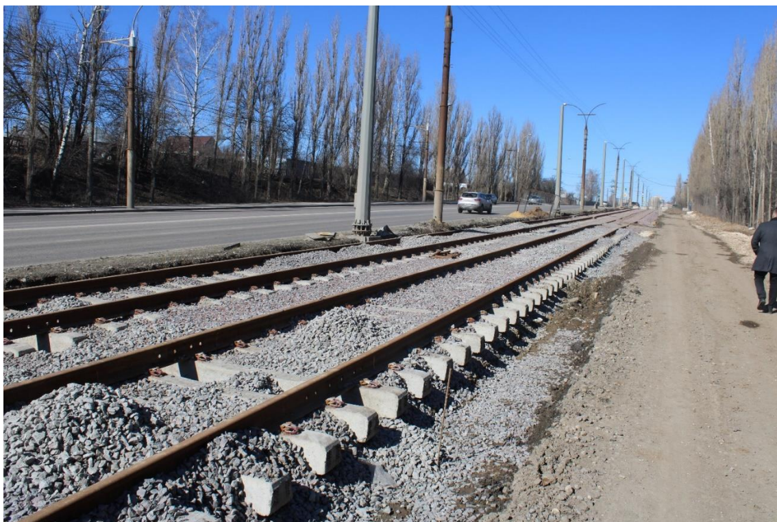
Рис. 103. Подходы к Октябрьскому мосту со стороны пр. Победы
