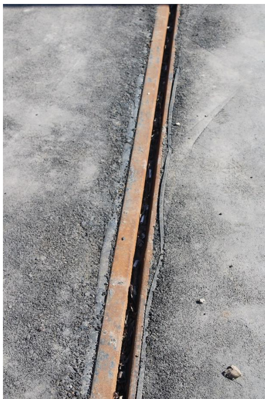
Рис. 51. Неплотное прилегание промежуточного уплотнения между рельсами и асфальтным покрытием остановочный пункт «21 микрорайон».
