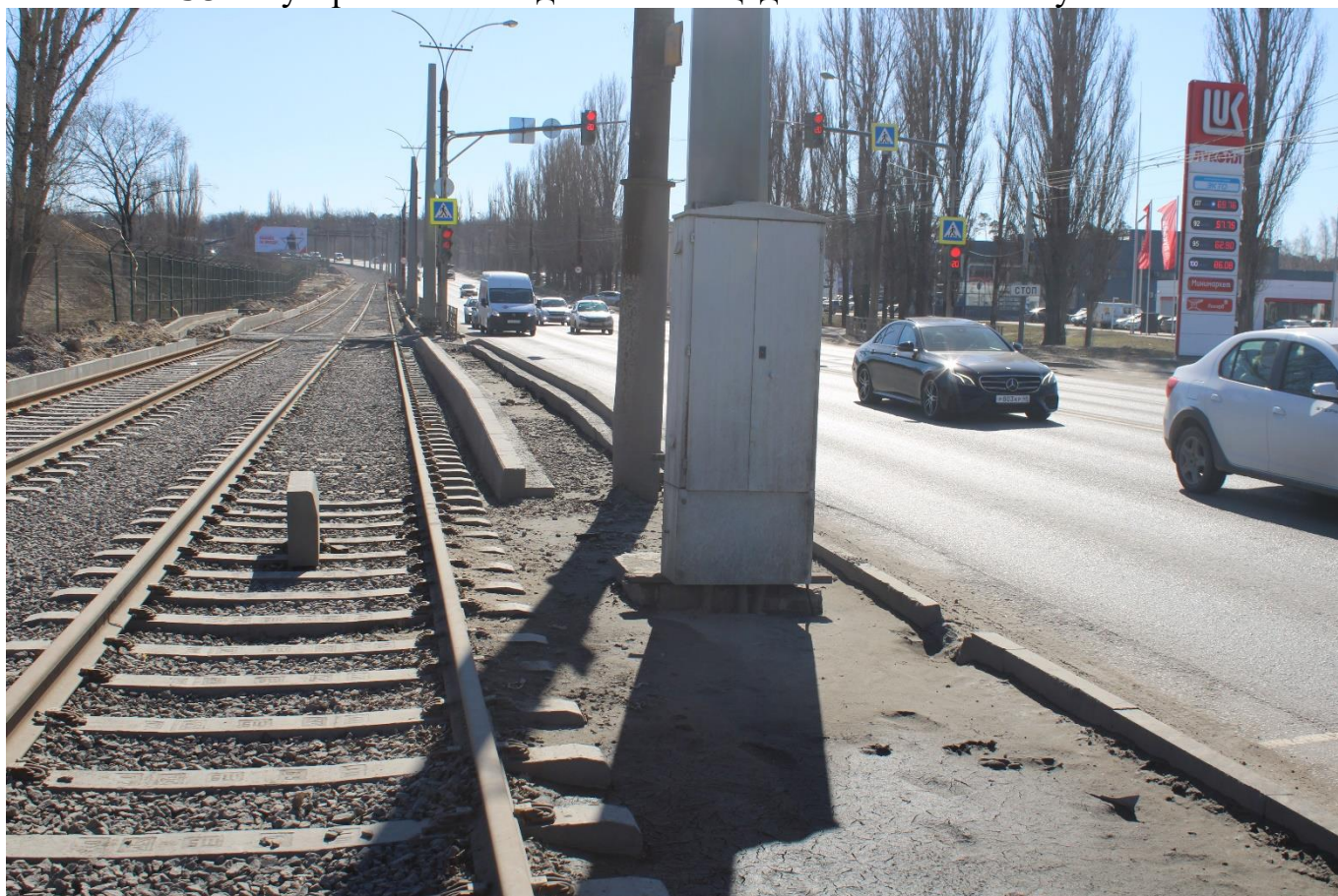
Рис. 99. Обустройство посадочной площадки на остановке «ул. Речная».
