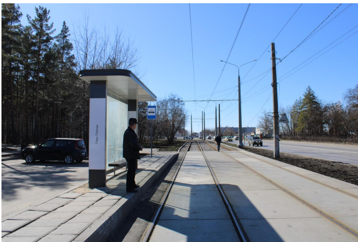
Рис. 61. Остановочный пункт «Парк Победы» в сторону ул. Полиграфическая. Павильон размещён на ненормативном расстоянии от края посадочной площадки. Требуется переустройство со смещением на территорию парковки.
