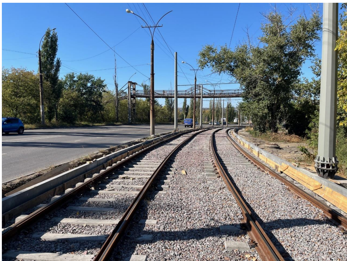
Рис. 98. Прямая рельсовая вставка на кривом участке трамвайного пути подход к Октябрьскому мосту со стороны ЛТЗ.
