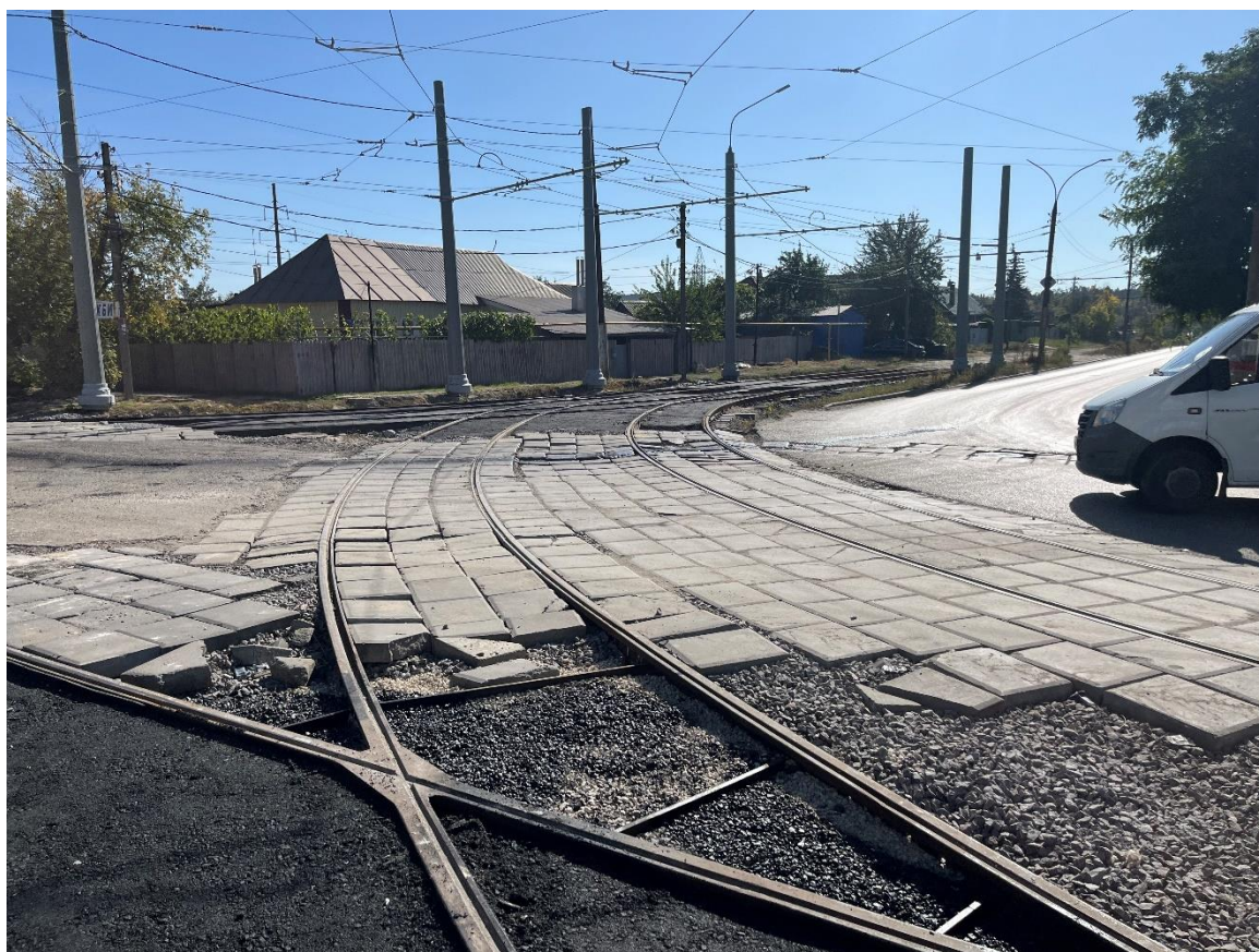
Рис. 22. Текущее состояние временного переезда по ул. 3 Сентября
