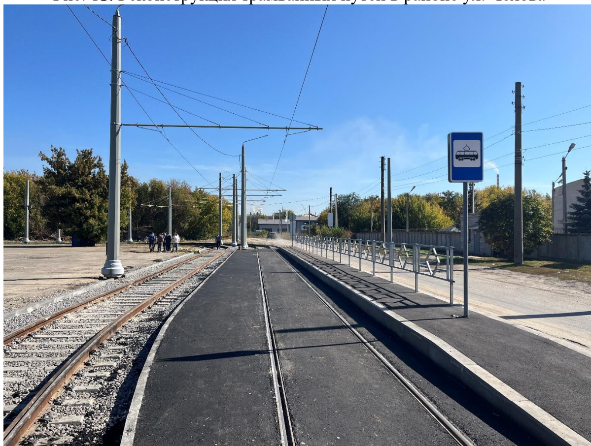
Рис. 16. Обустройство посадочной платформы в районе ул. Чехова
