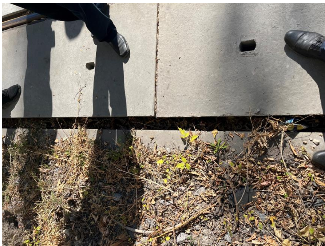
Рис. 47. Фактически примыкание выполнено с установкой бортового камня (остановочный пункт «3-е Сентября»).
