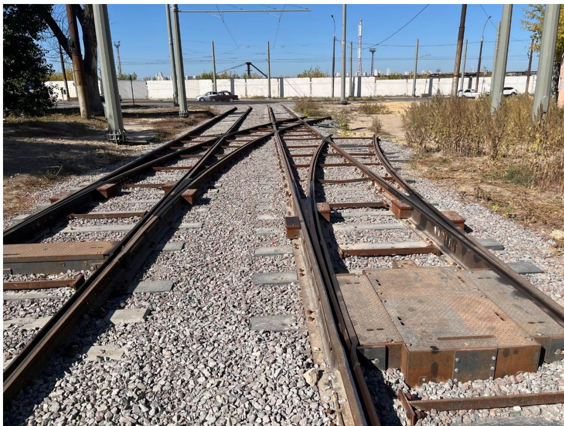
Рис. 42. Общий вид стрелочного перевода ул. Краснозаводская
