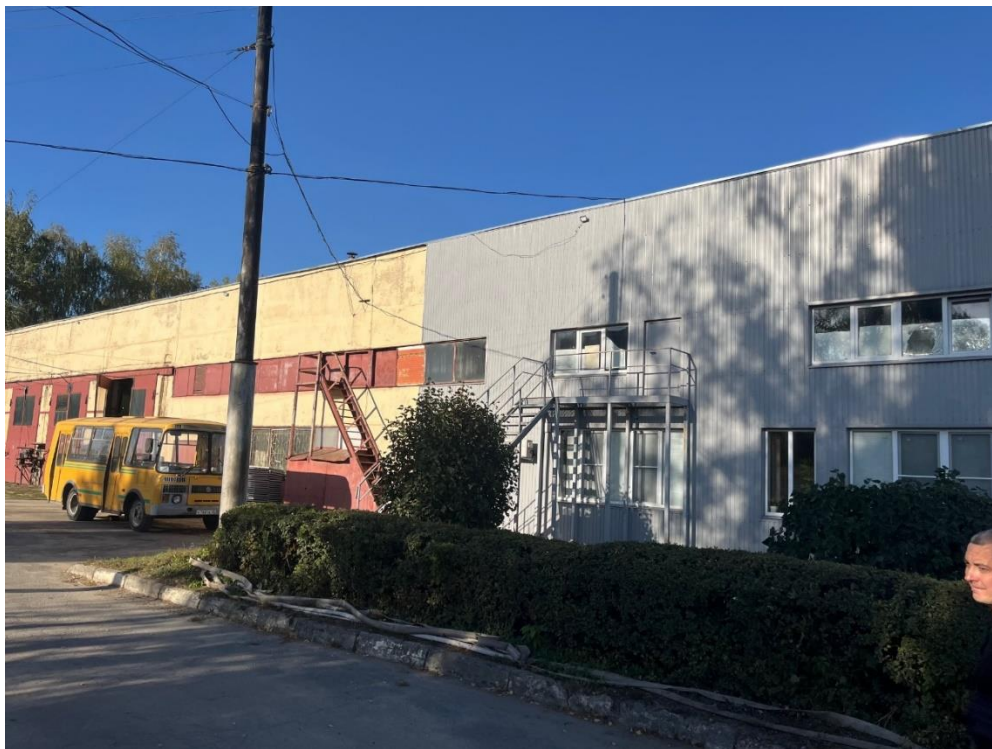
Рис. 115. Общий вид трамвайного депо на момент проведения Проверки.
