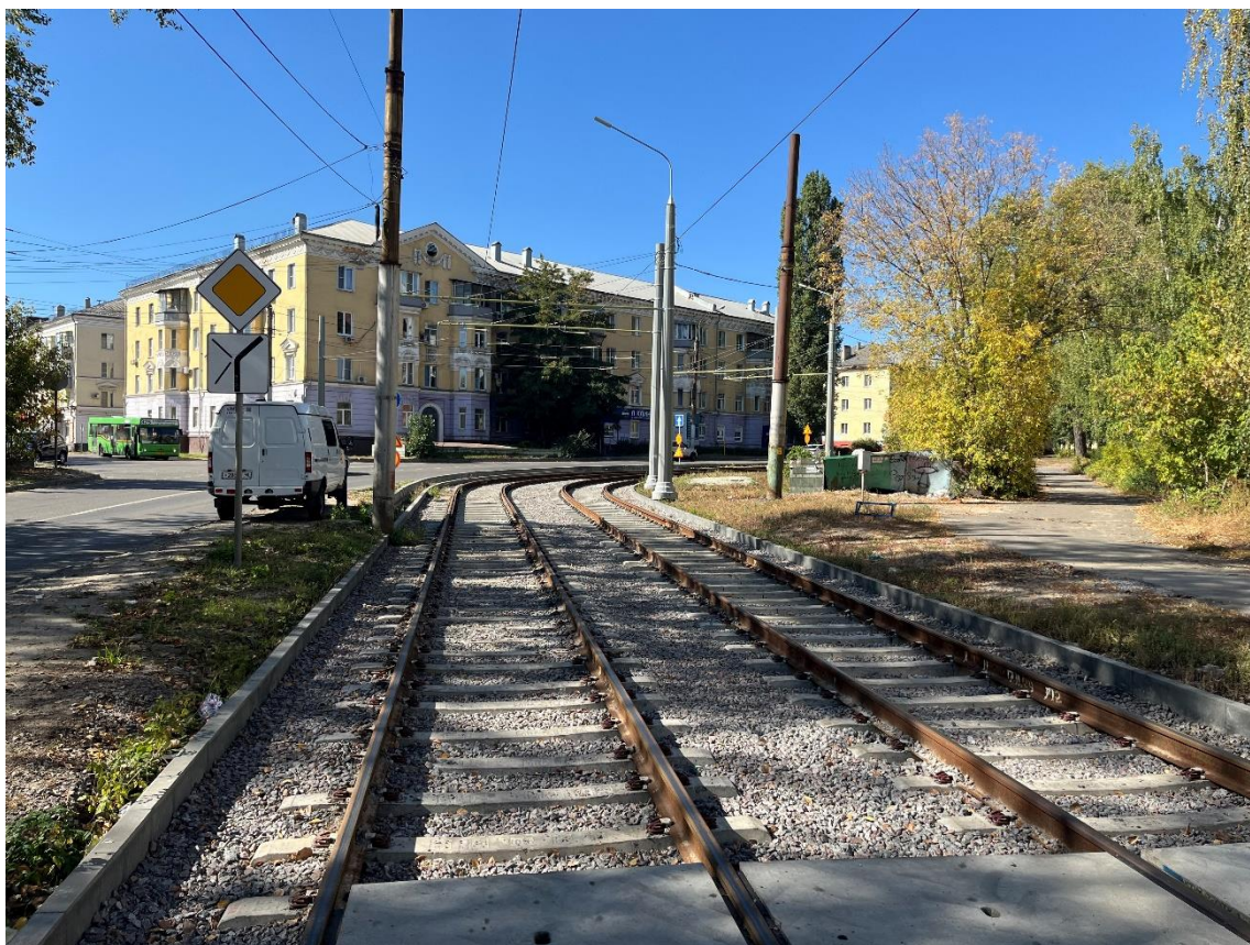
Рис. 33. Кривой участок трамвайного пути на ул. Краснозаводская
