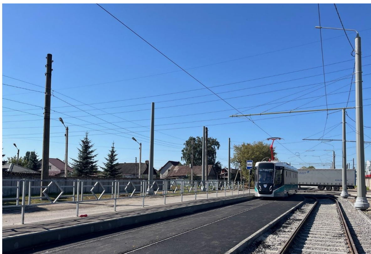
Рис. 14. Реконструкция трамвайных путей в районе ул. Чехова
