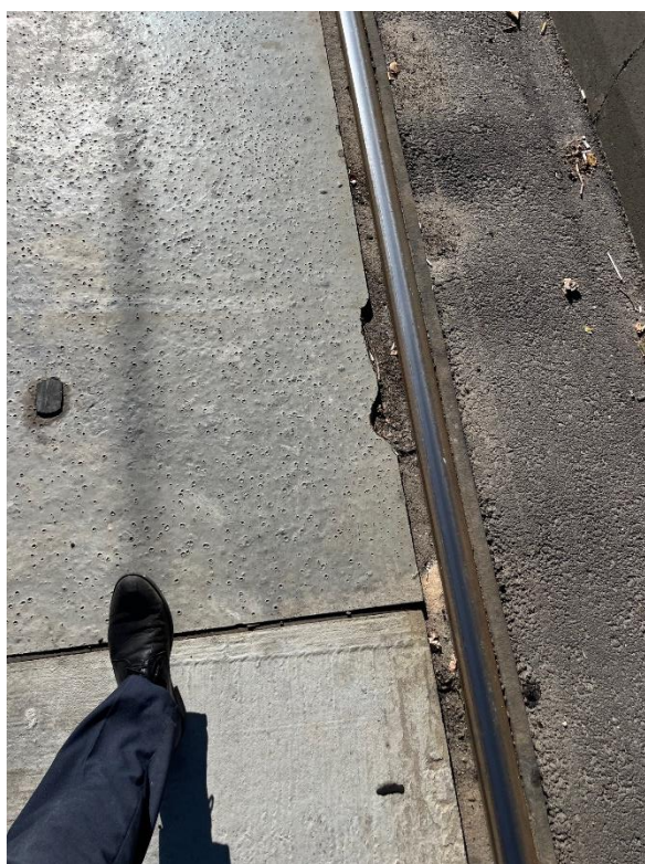
Рис. 55. Повреждение плит, уложенных на остановочном пункте «Улица Катукова»
