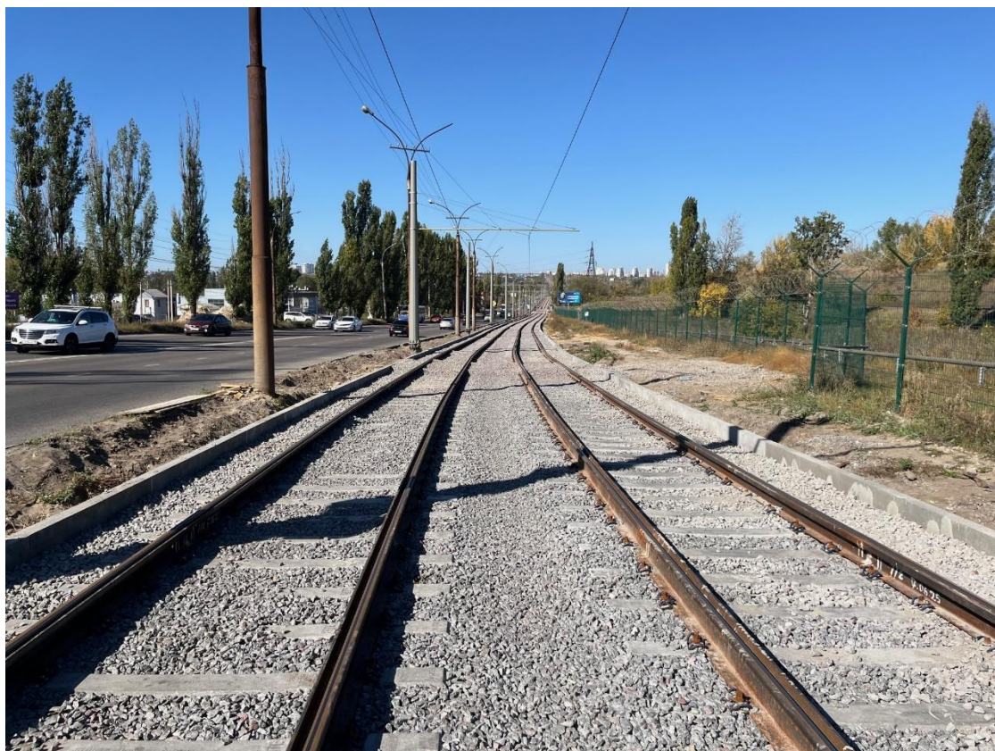
Рис. 99. Прямая рельсовая вставка на кривом участке трамвайного пути подход к Октябрьскому мосту со стороны ЛТЗ.
