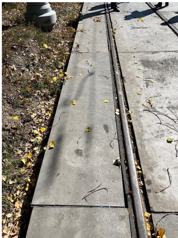
Рис. 36. Смещение краевых плит по ул. Краснозаводская
