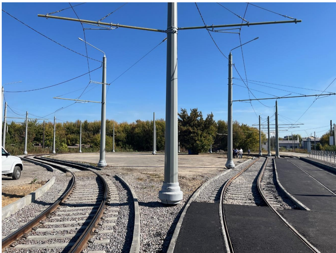
Рис. 15. Реконструкция трамвайных путей в районе ул. Чехова
