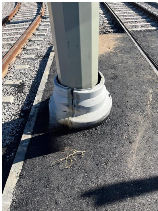
Рис.17. Повреждение кожуха опоры контактной сети
