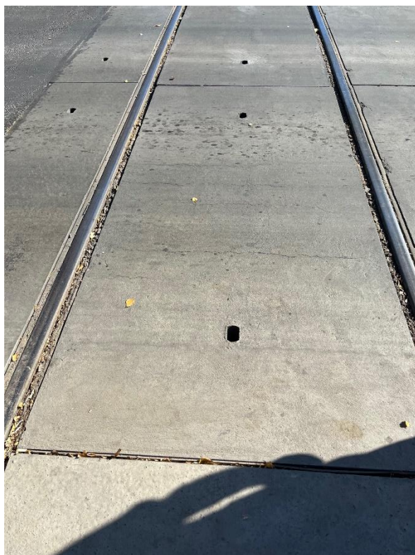
Рис. 111. Сетка трещин на плитах, уложенных на пересечении трамвайных путей с проспектом Победы.
