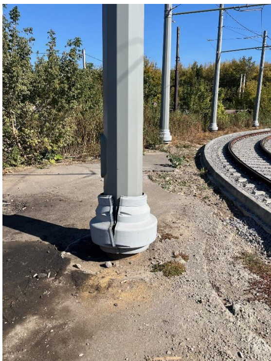
Рис.17. Повреждение кожуха опоры контактной сети
