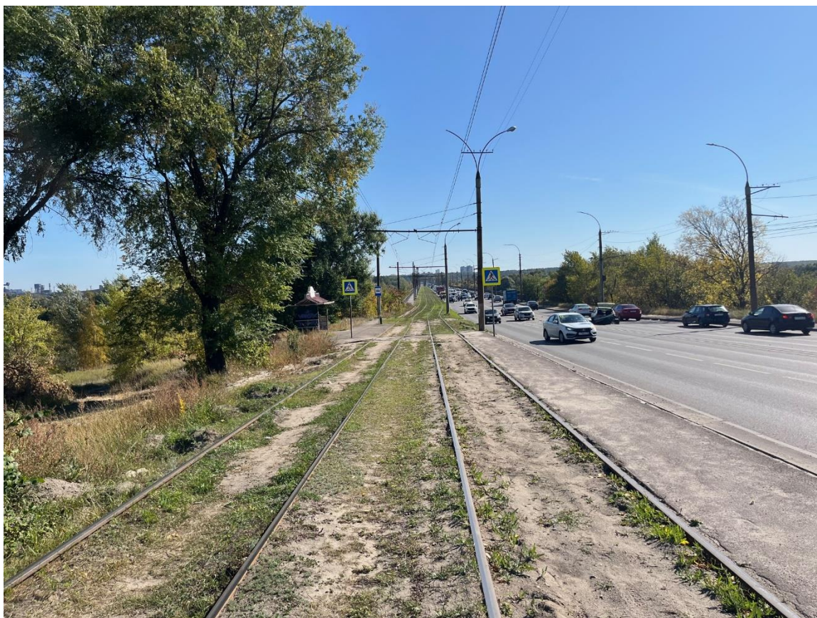
Рис. 105. Трамвайные пути в районе остановочного пункта «Мост».
