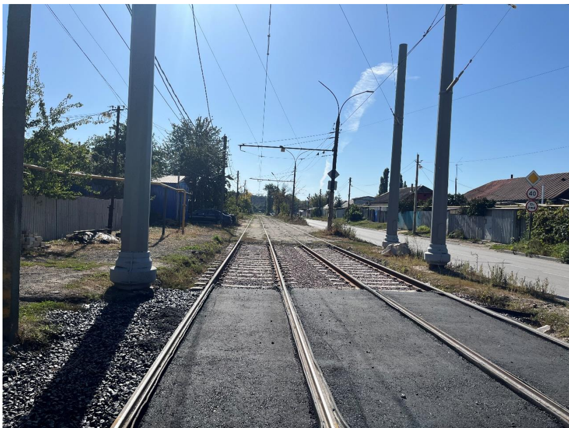
Рис. 21. Реконструкция трамвайных путей по ул. 1-я Воронежская. Выполнено сопряжение с существующими путями
