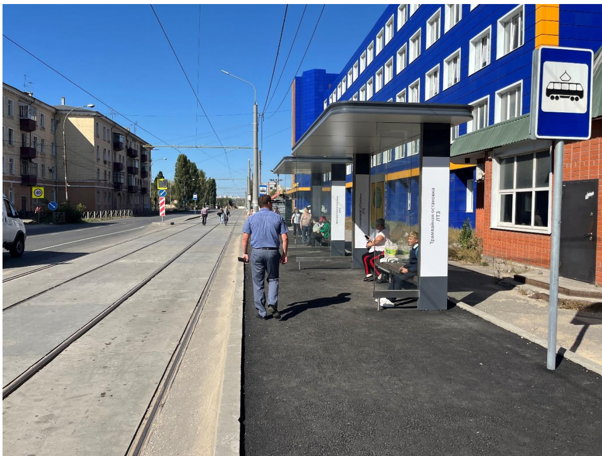
Рис. 37 Текущее состояние остановочного пункта «ЛТЗ»
