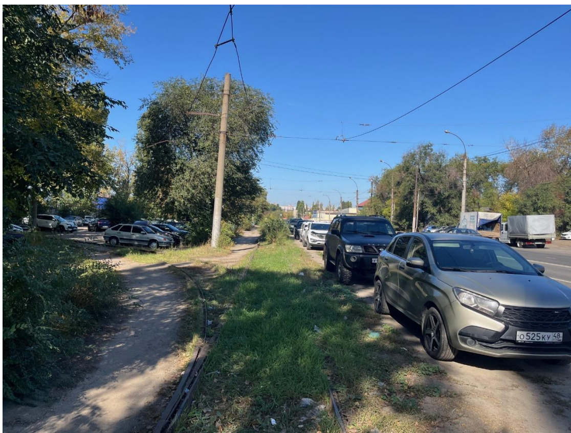
Рис. 93. Разворотный круг по ул. 9 Мая. Демонтажные работы на момент проведения Проверки не начаты.
