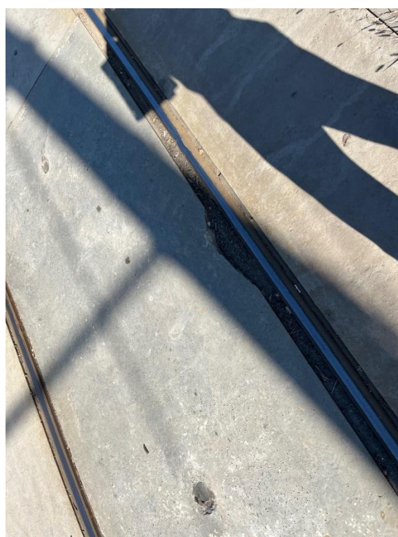
Рис. 55. Повреждение плит, уложенных на остановочном пункте «Улица Катукова»
