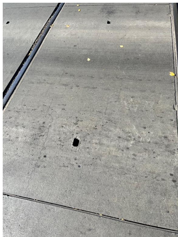
Рис. 111. Сетка трещин на плитах, уложенных на пересечении трамвайных путей с проспектом Победы.
