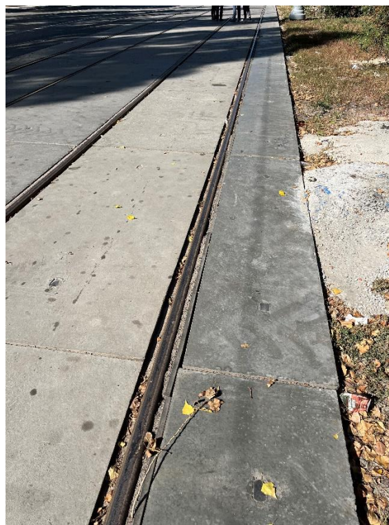
Рис. 36. Смещение краевых плит по ул. Краснозаводская
