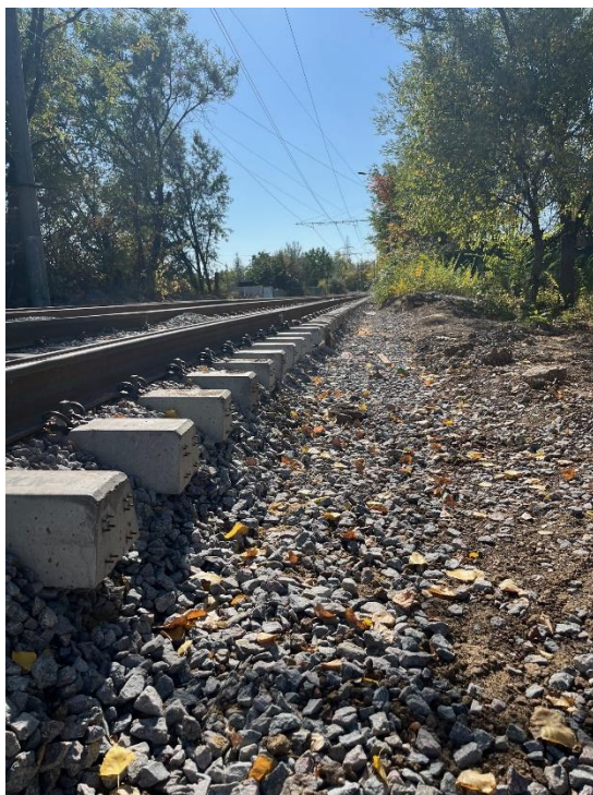
Рис.110. Подход к проспекту Победы со стороны остановочного пункта «Село Сырское» отсутствует балластный слой в торцах шпал.
