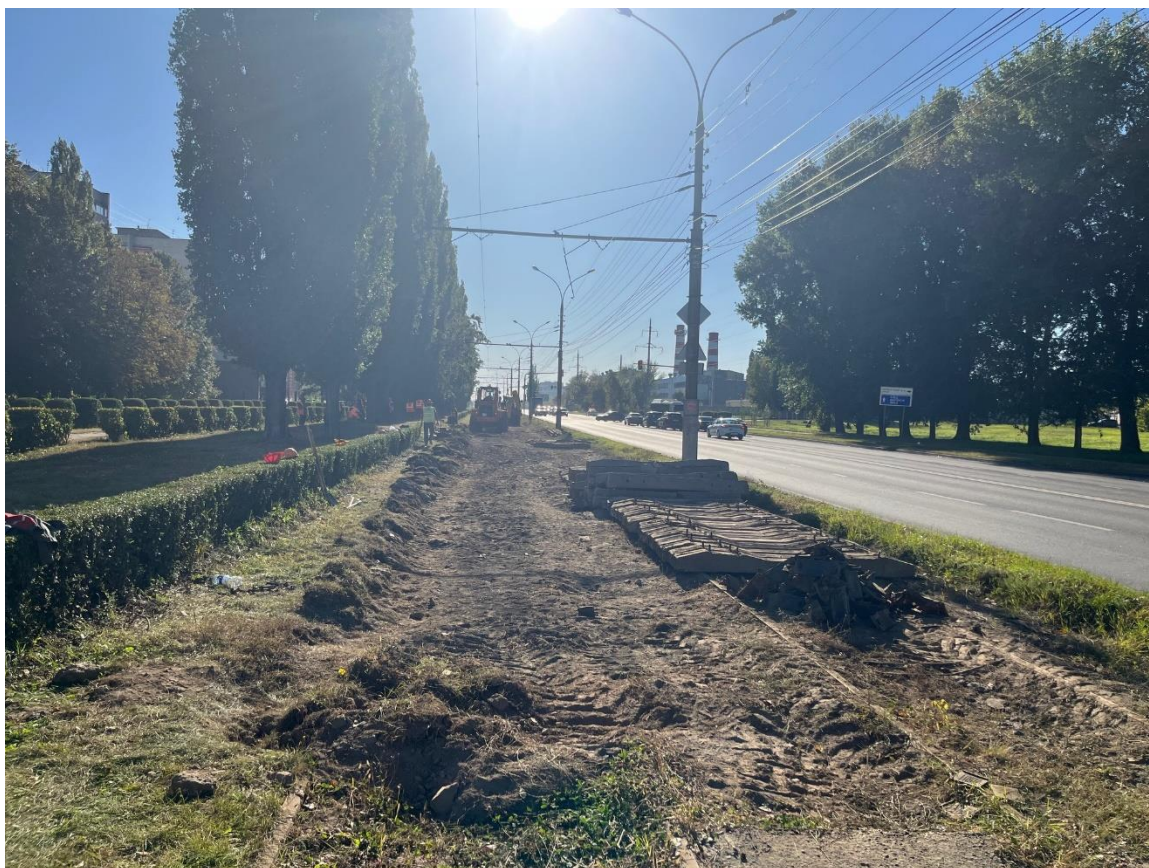
Рис. 80. Ул. Московская. Демонтаж существующих путей за исключением переездов
