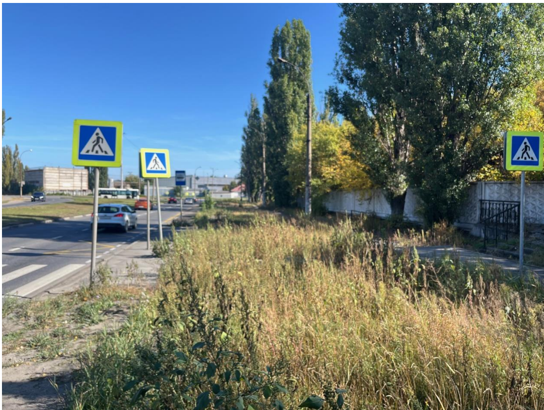
Рис. 91. Вид на ул. Metallургов в сторону кольцевого пересечения с ул. 9 Мая
