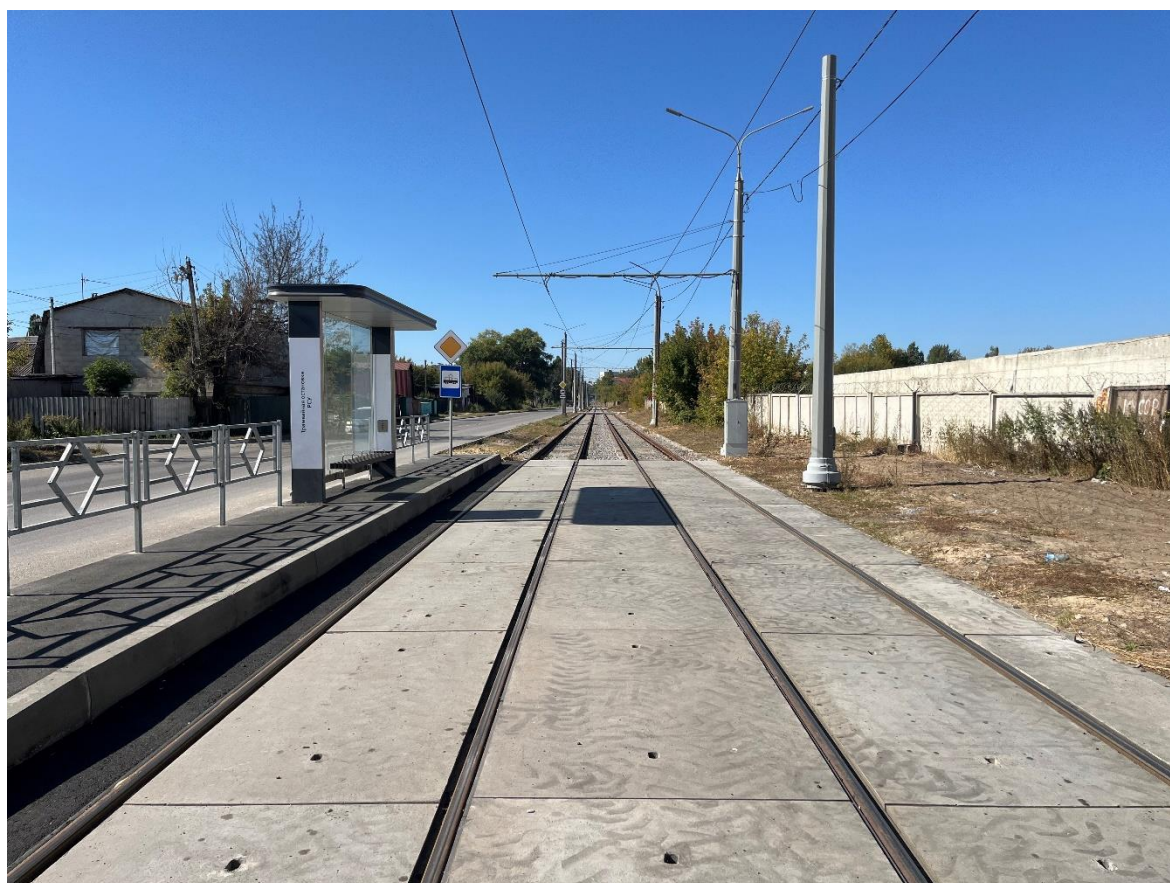
Рис. 24 Текущее состояние остановочного пункта «РСУ»
