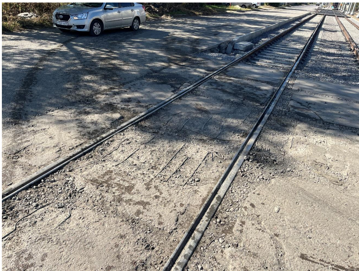
Рис. 18. Текущее состояние временного переезда в районе кольца ул. Чехова
