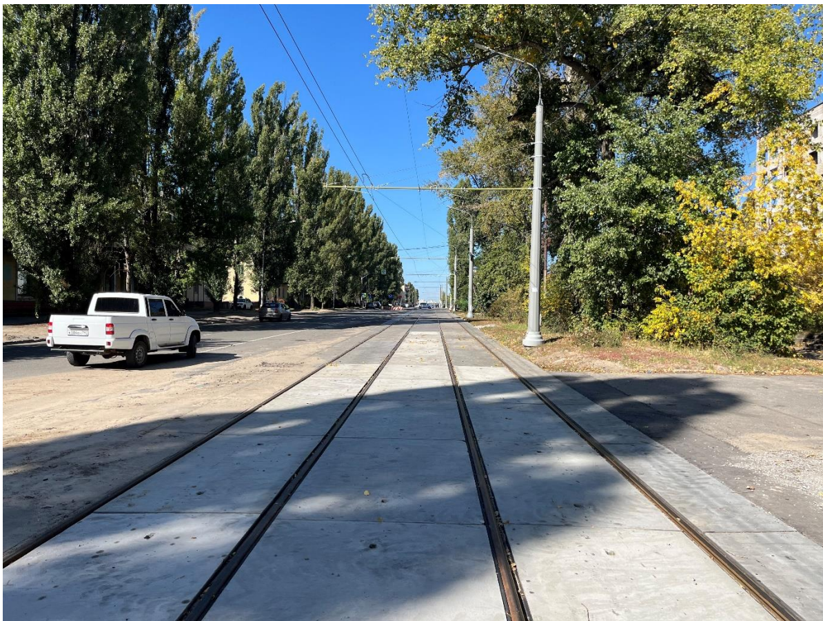
Рис. 35. Общий вид трамвайной инфраструктуры по ул. Краснозаводская
