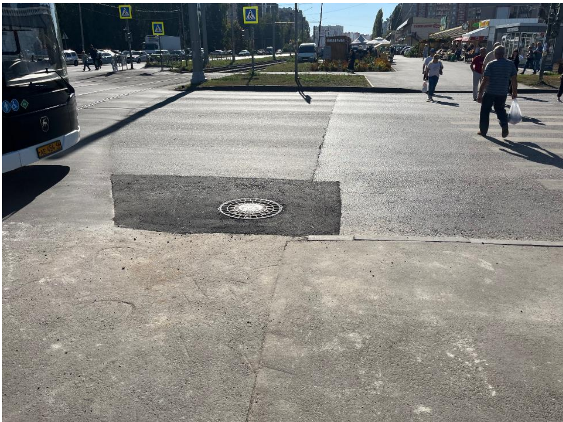
Рис. 56. Устранена просадка канализационного люка на пересечении пр. 60 лет СССР и ул. Меркулова
