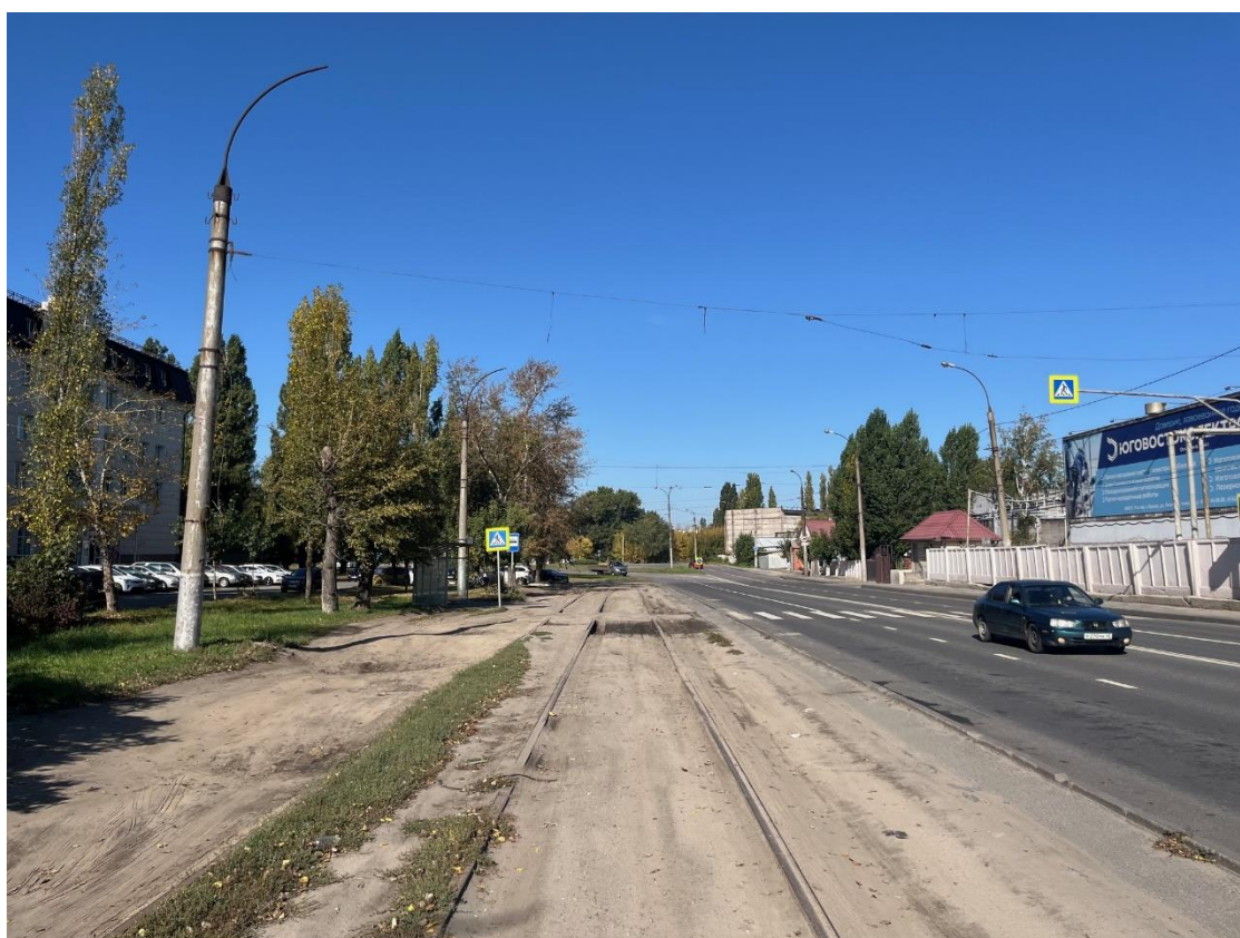
Рис. 92. Ул. 9 Мая. Демонтажные работы на момент проведения Проверки не начаты.
