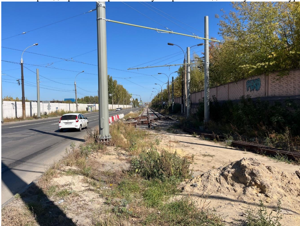
Рис. 44. Участок работ в районе пересечения ул. Краснозаводская с ул. Metallургов
