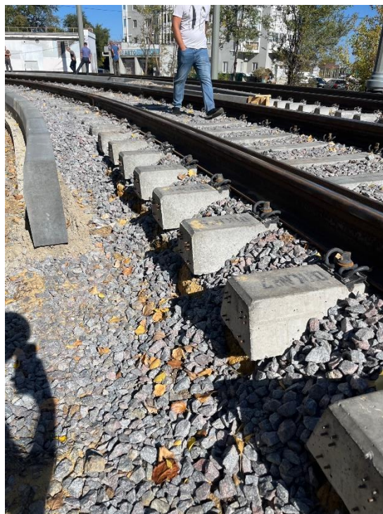
Рис.110. Подход к проспекту Победы со стороны остановочного пункта «Село Сырское» отсутствует балластный слой в торцах шпал.
