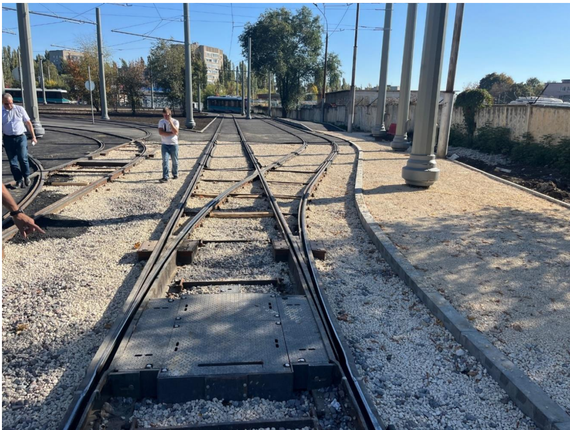
Рис. 76. Разворотный петля 9 микрорайона стрелочный перевод не работает в автоматическом режиме
