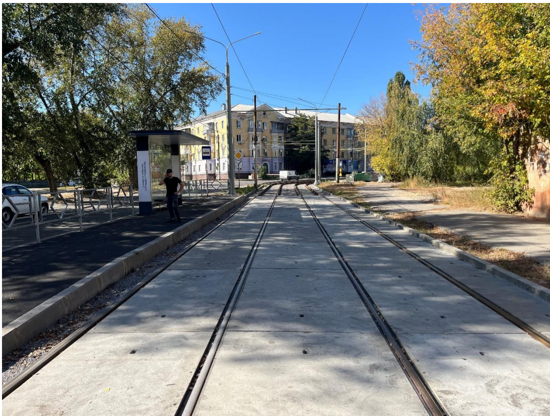
Рис. 31 Текущее состояние остановочного пункта «Площадь Клименкова»
